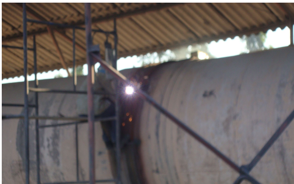
Figura 7: Manutenção no forno rotativo da empresa Tecnocal Ltda Fonte: Dados da pesquisa aplicada.
