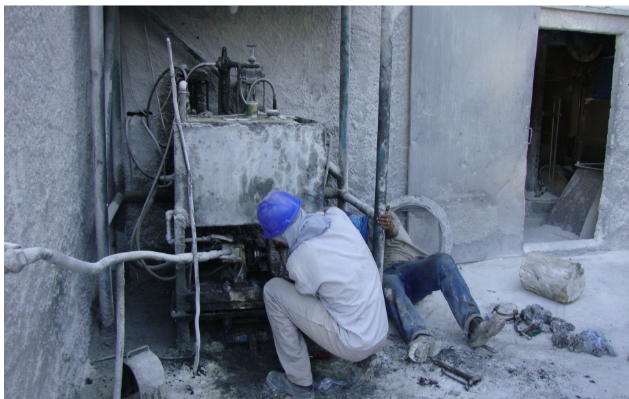
Figura 10: Reparo no sistema hidráulico.
