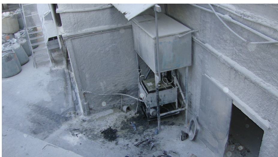
Figura 11: Reparo no sistema hidráulico.
