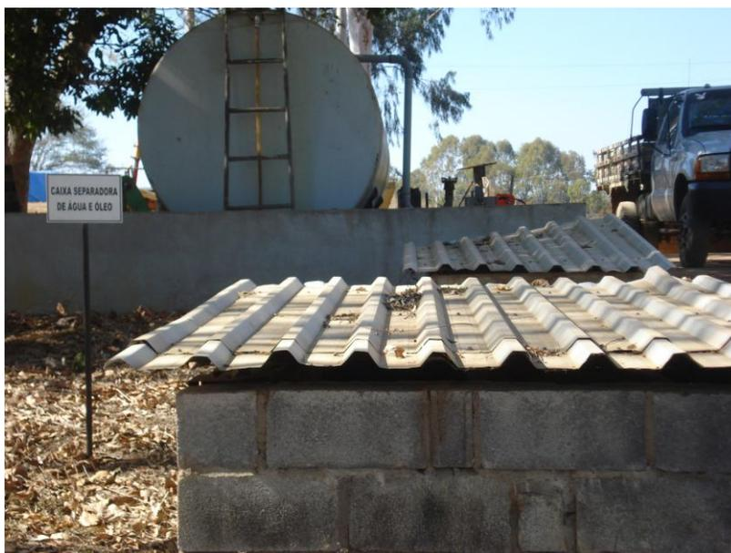
FIGURA 13: Caixa separadora de água e óleo.
