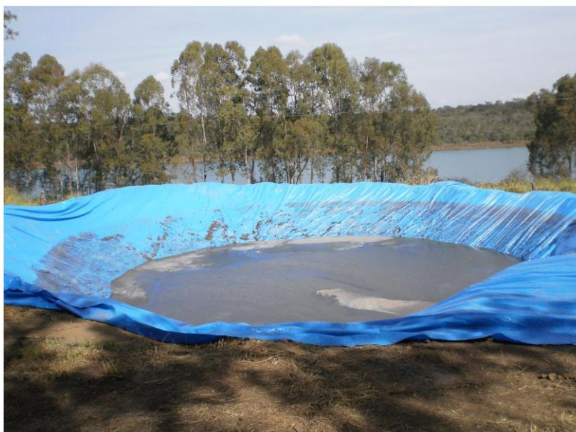
FIGURA 8: Lagoa de decantação das águas residuárias.
