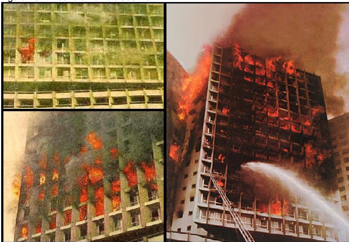
Figura 15 – Incêndio Edifício Joelma
