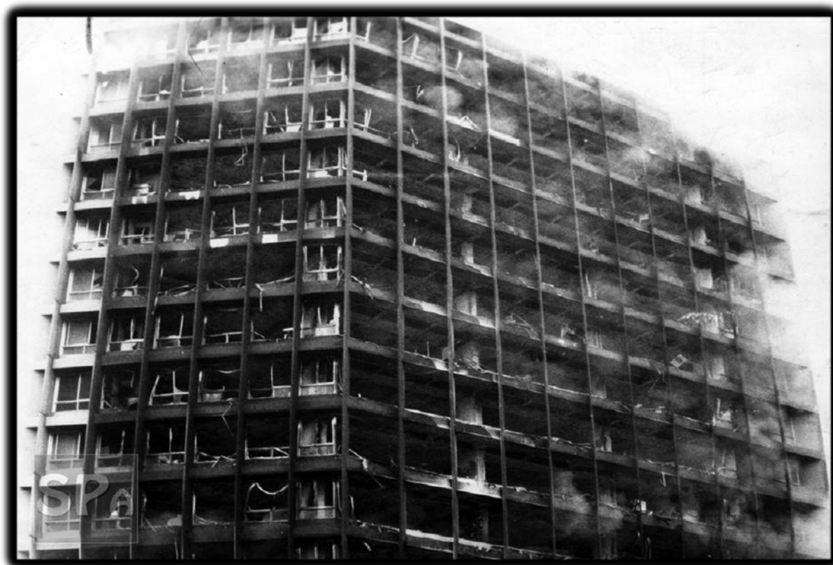
Figura 16 – Edifício Joelma após extinção das chamas
