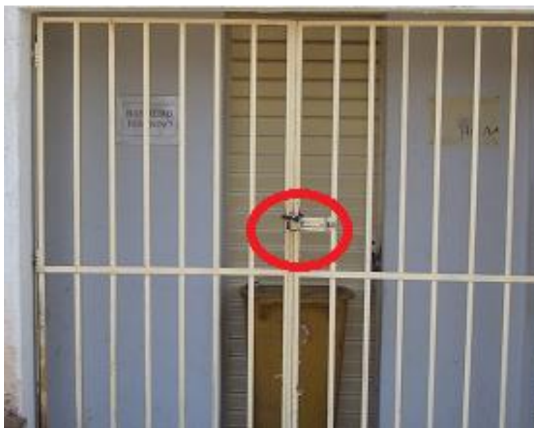
Figura 68 – Banheiro público da Praça M. S. V. Férrer
