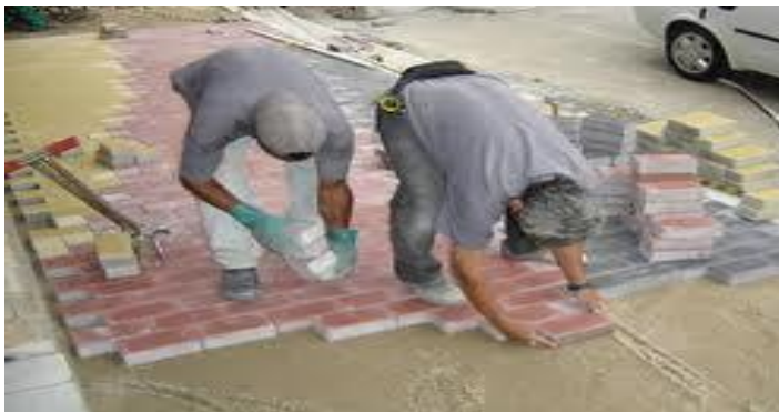
Figura 34 – Assentamento de pavimento intertravado.
