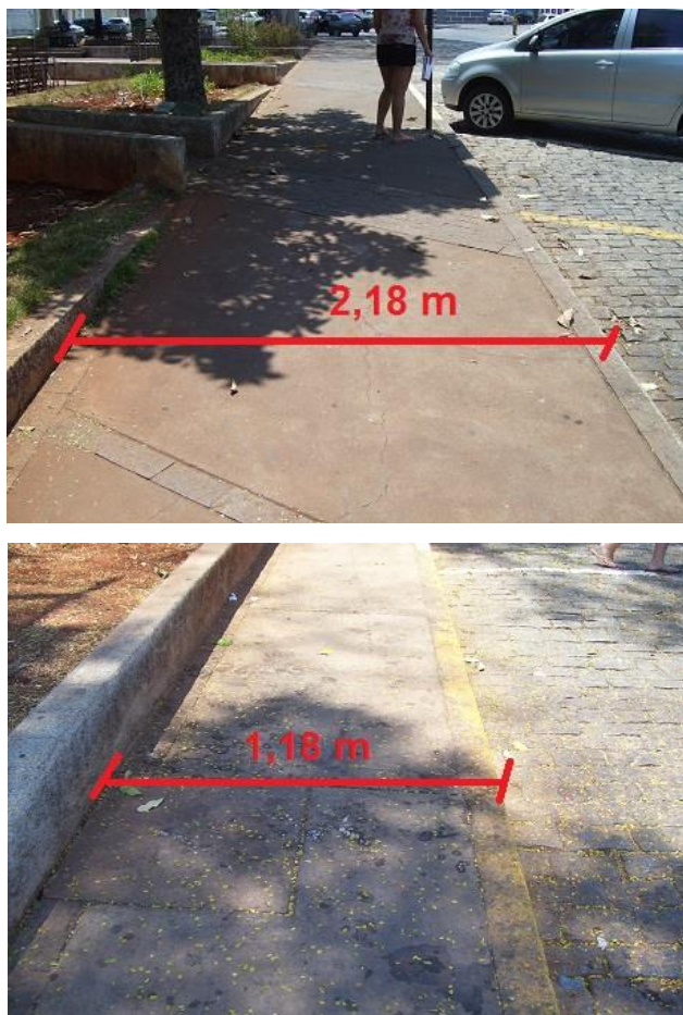
Figura 55 - Largura da calçada
