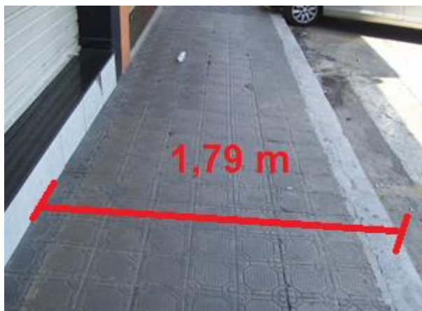
Figura 71 – Largura da calçada
