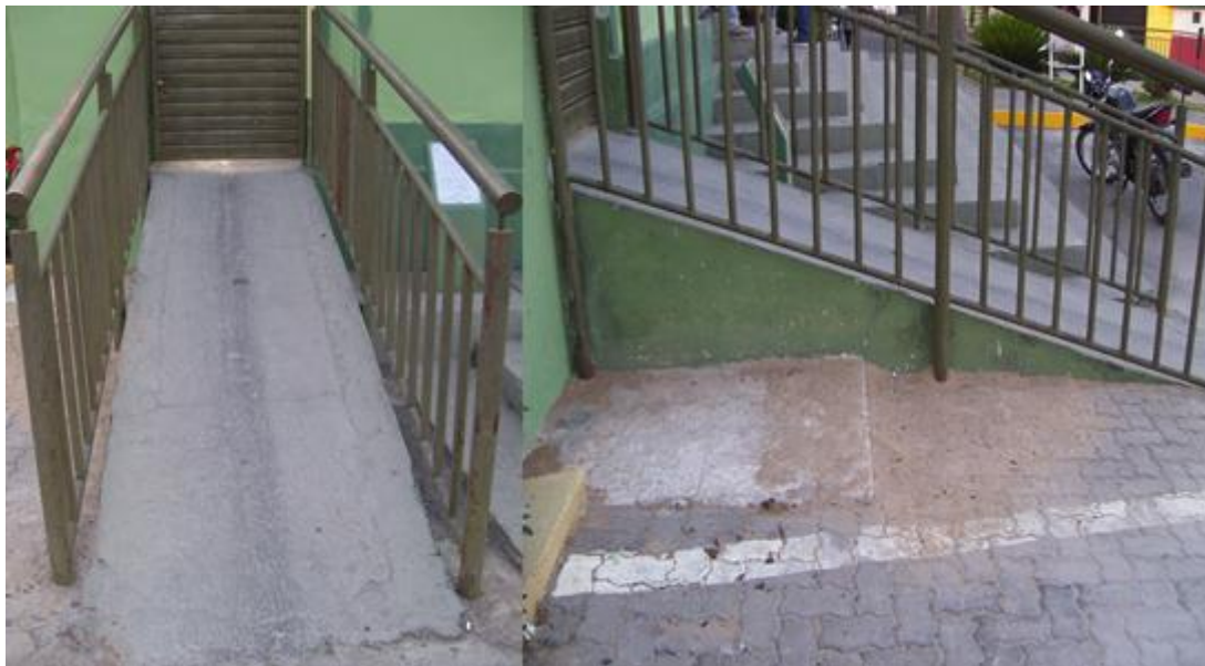
Figura 97 – Rampa que dá acesso ao cemitério
