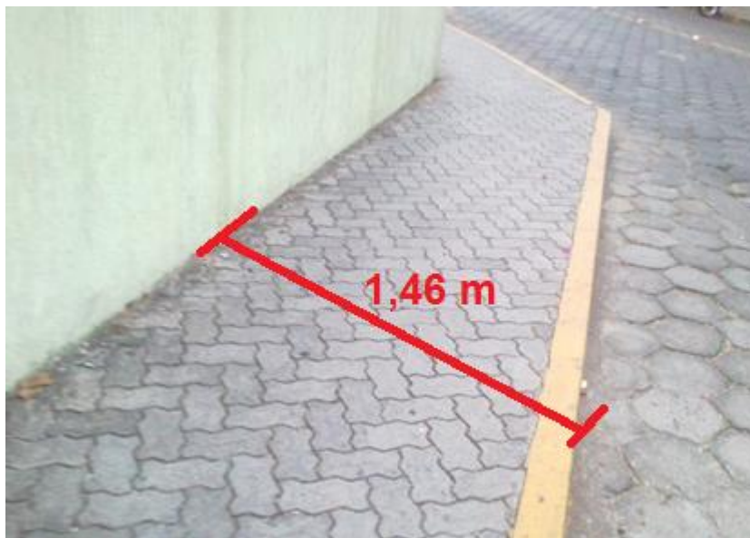
Figura 90 – Largura da calçada
