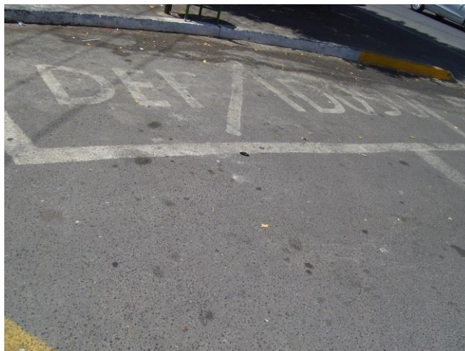
Figura 77 – Vaga paralela a calçada sem área de circulação
