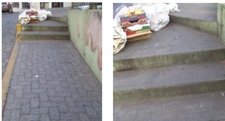
Figura 92 – escada no fim da calçada
