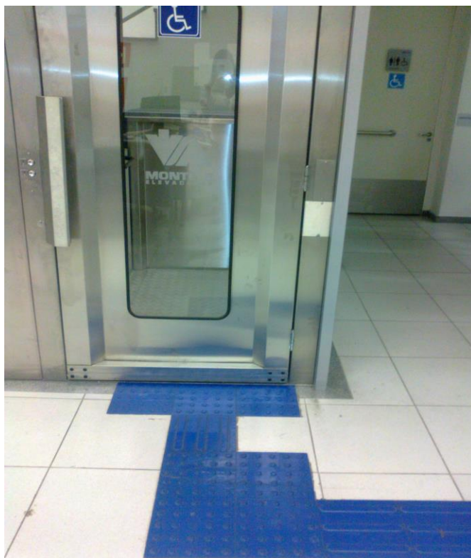
Figura 28 – Composição tátil de alerta e direcional junto às portas de elevadores
