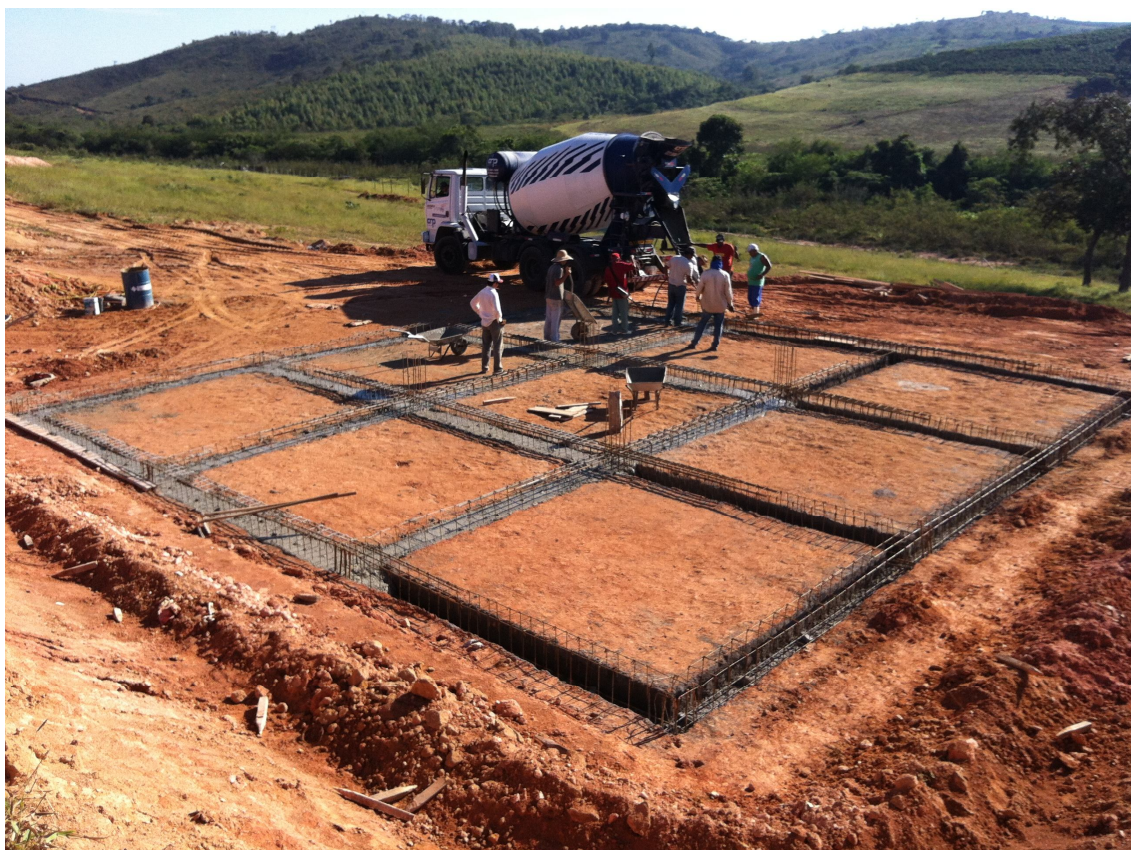
Figura 6 - Fundação tipo Viga Baldrame
