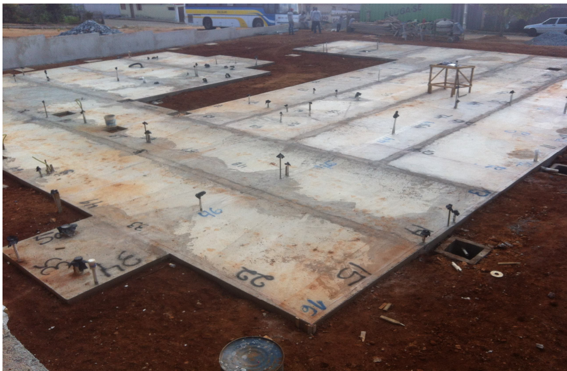
Figura 27 - Radier com as tubulações hidráulicas já instaladas.
