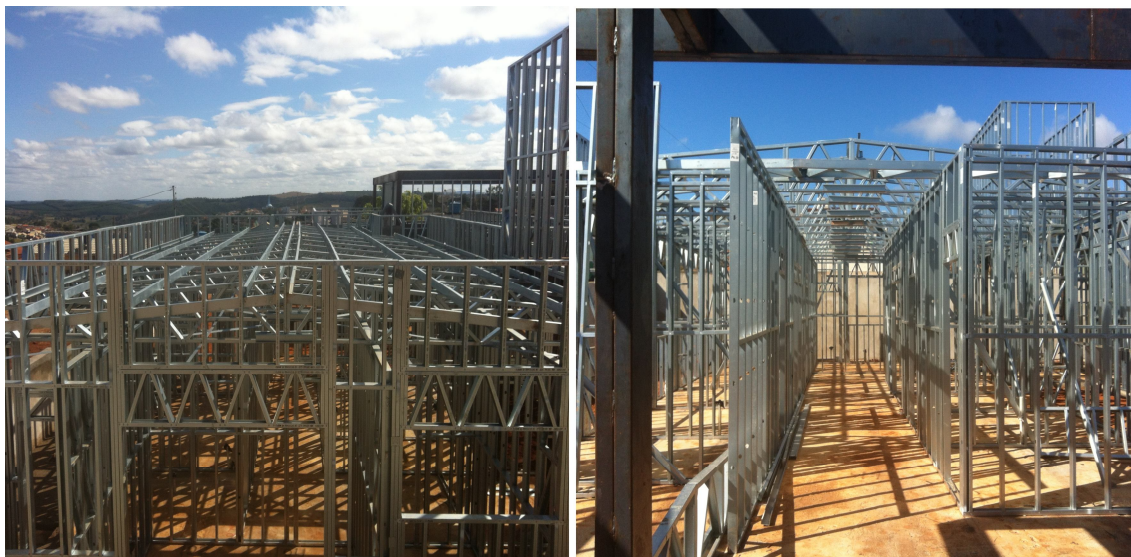
Figura 36 - Estrutura do telhado
