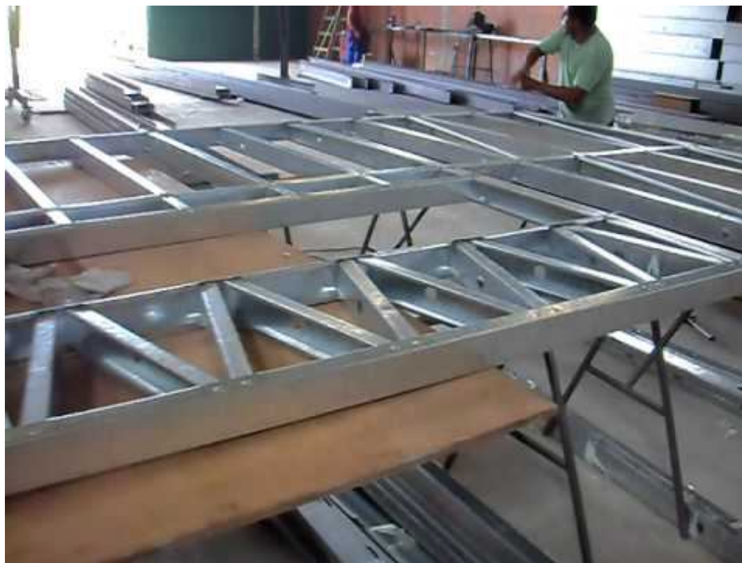
Figura 7 - Pré-montagem dos perfis na fábrica.
