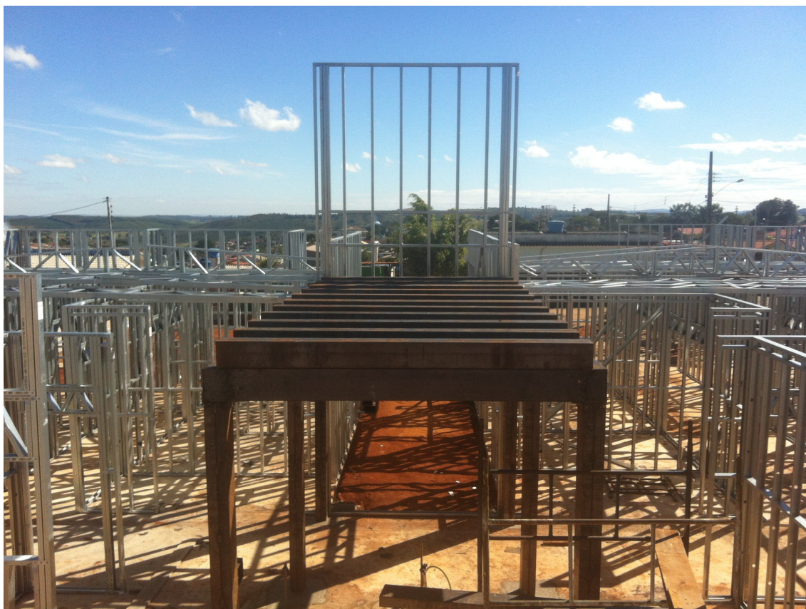
Figura 35 - Pórtico da caixa d'água
