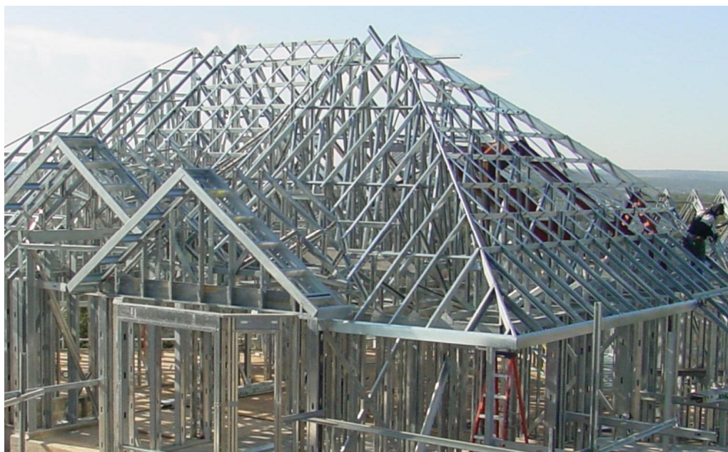
Figura 3 - Imagem da estrutura da edificação
