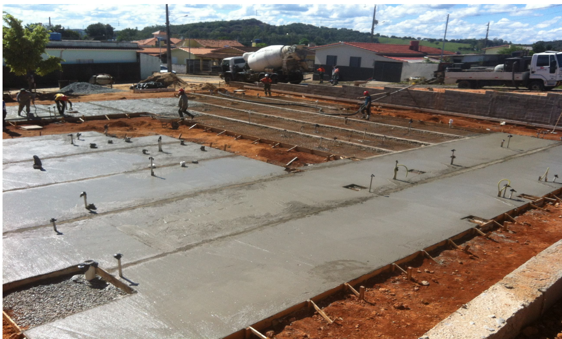
Figura 4 - Fundação tipo Radier
