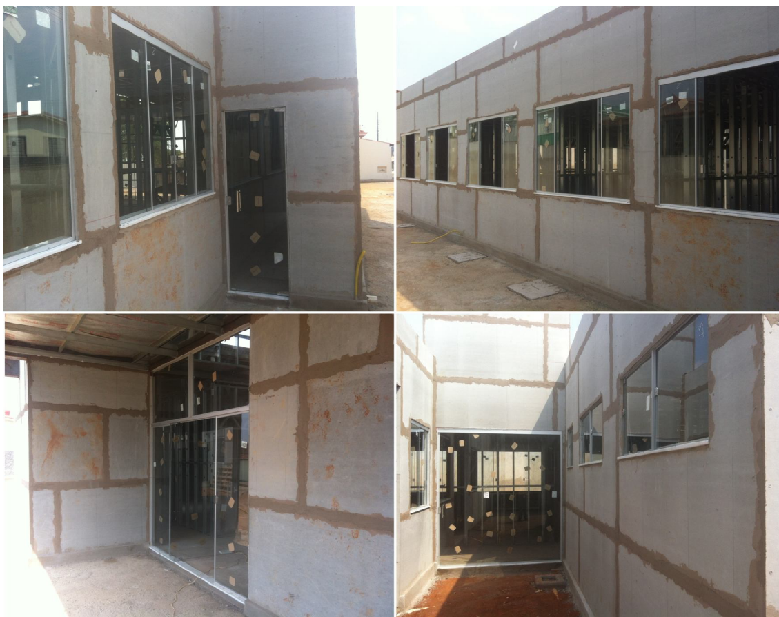
Figura 38 - Esquadrias de alumínio e vidro
