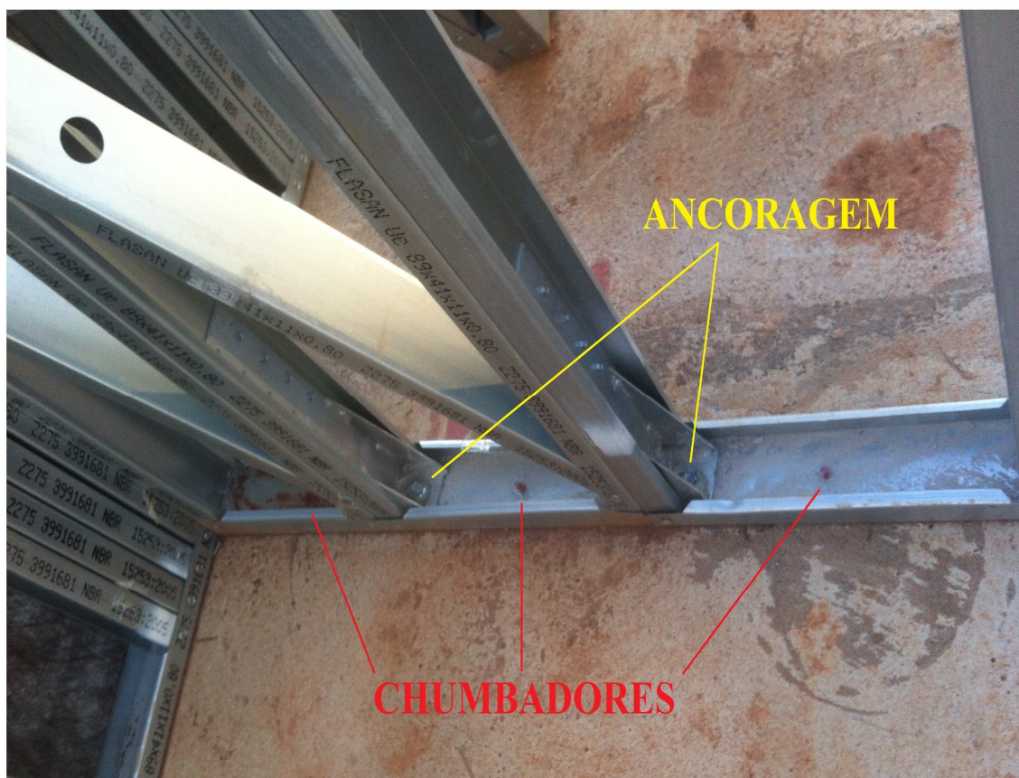
Figura 29 - Chumbadores e a ancoragem dos perfis metálicos ao radier "in loco"
