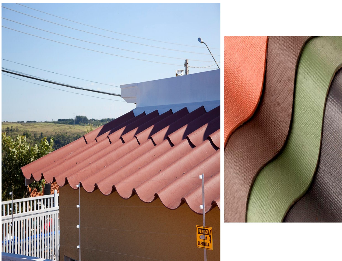
Figura 22 - Cobertura em telha de fibrocimento
