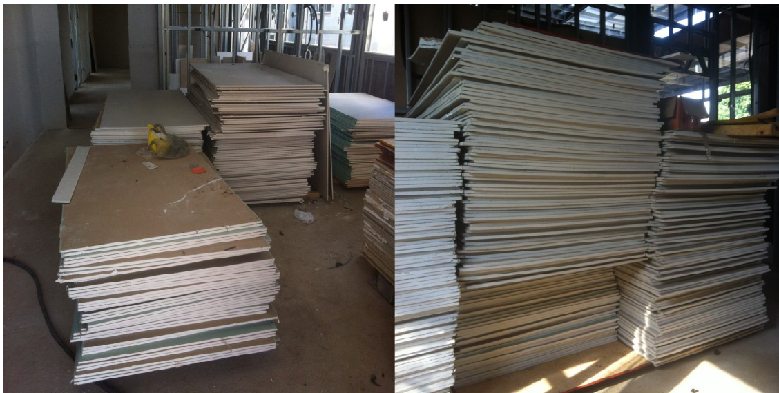
Figura 43 - Estocagem das placas de gesso acartonado na obra.
