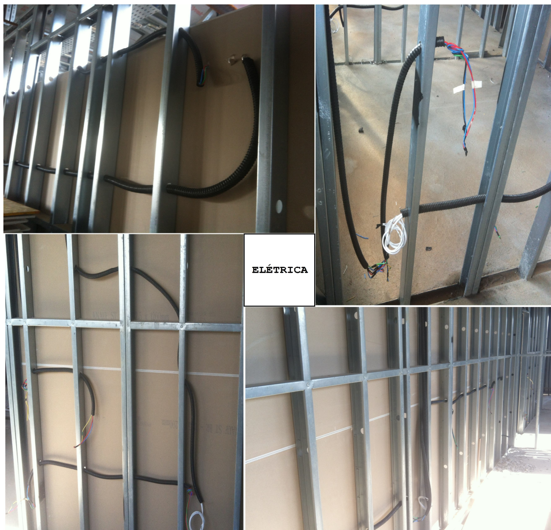
Figura 39 - Instalação Elétrica
