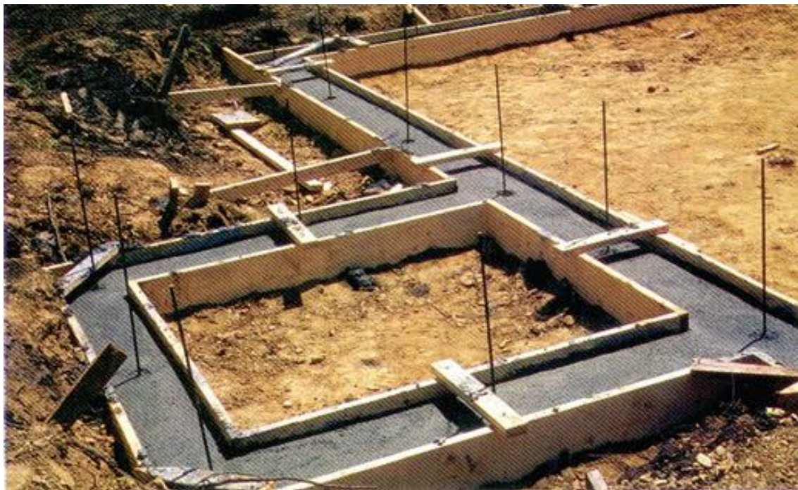
Figura 5 - Fundação tipo Sapata Corrida
