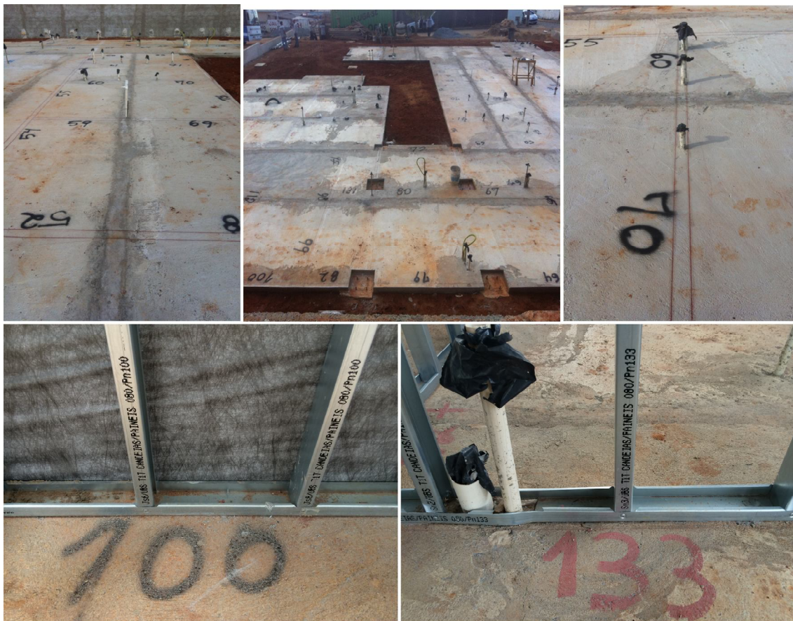
Figura 33 - Marcação do gabarito e seus respectivos painéis
