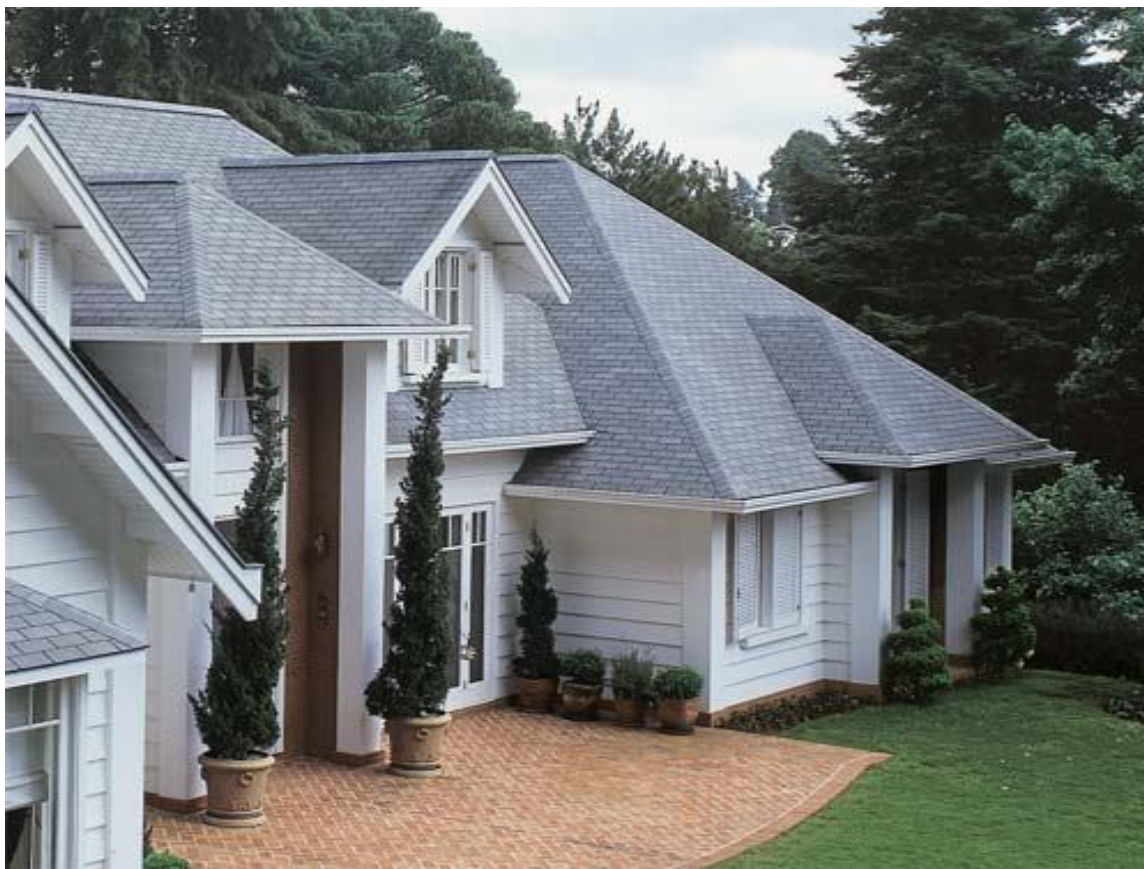
Figura 23 - Cobertura em telhado tipo Shingle
