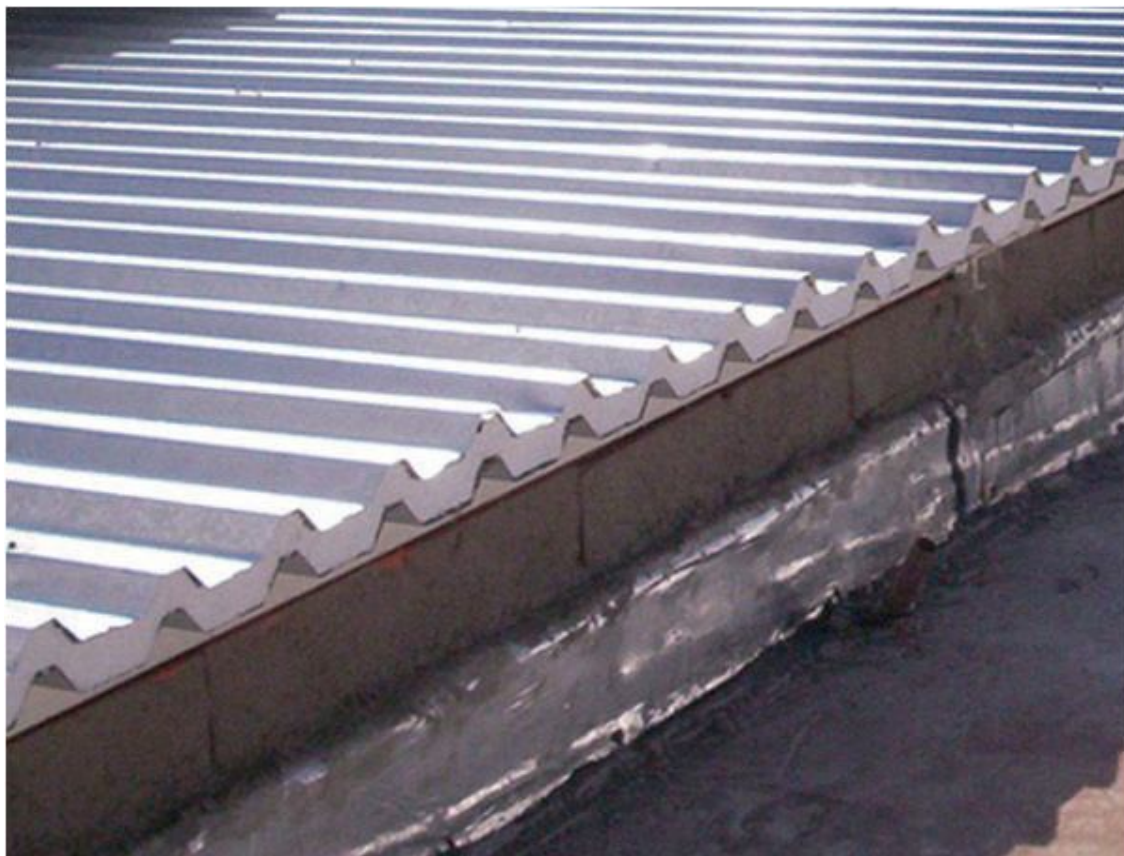
Figura 21 - Cobertura em telha de aço tipo "sanduíche"
