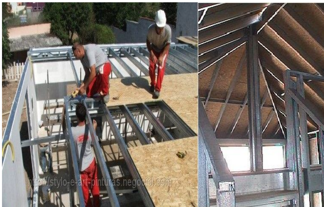
Figura 20 - Aplicação do substrato em OSB para receber a Telha Cerâmica
