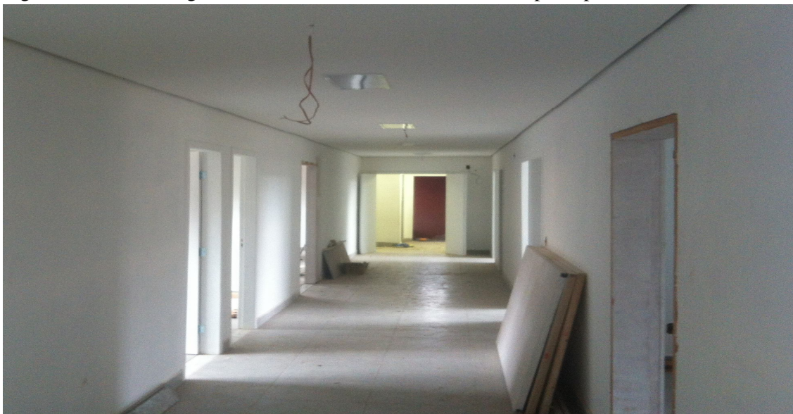
Figura 44 - Placas de gesso acartonado assentadas no corredor principal da obra
