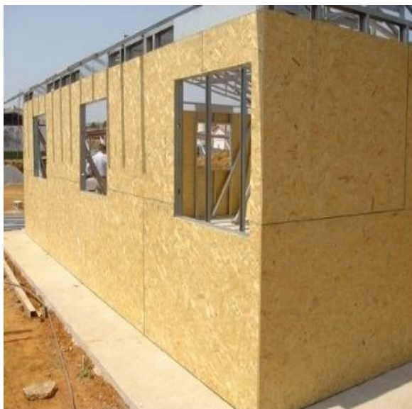
Figura 12 - Fechamento estrutural externo em OSB
