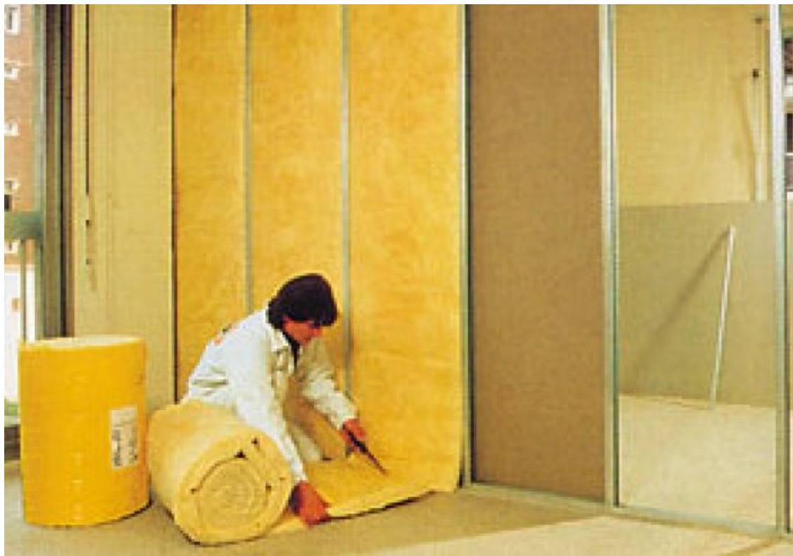
Figura 25 - Instalação de isolamento em lã de vidro
