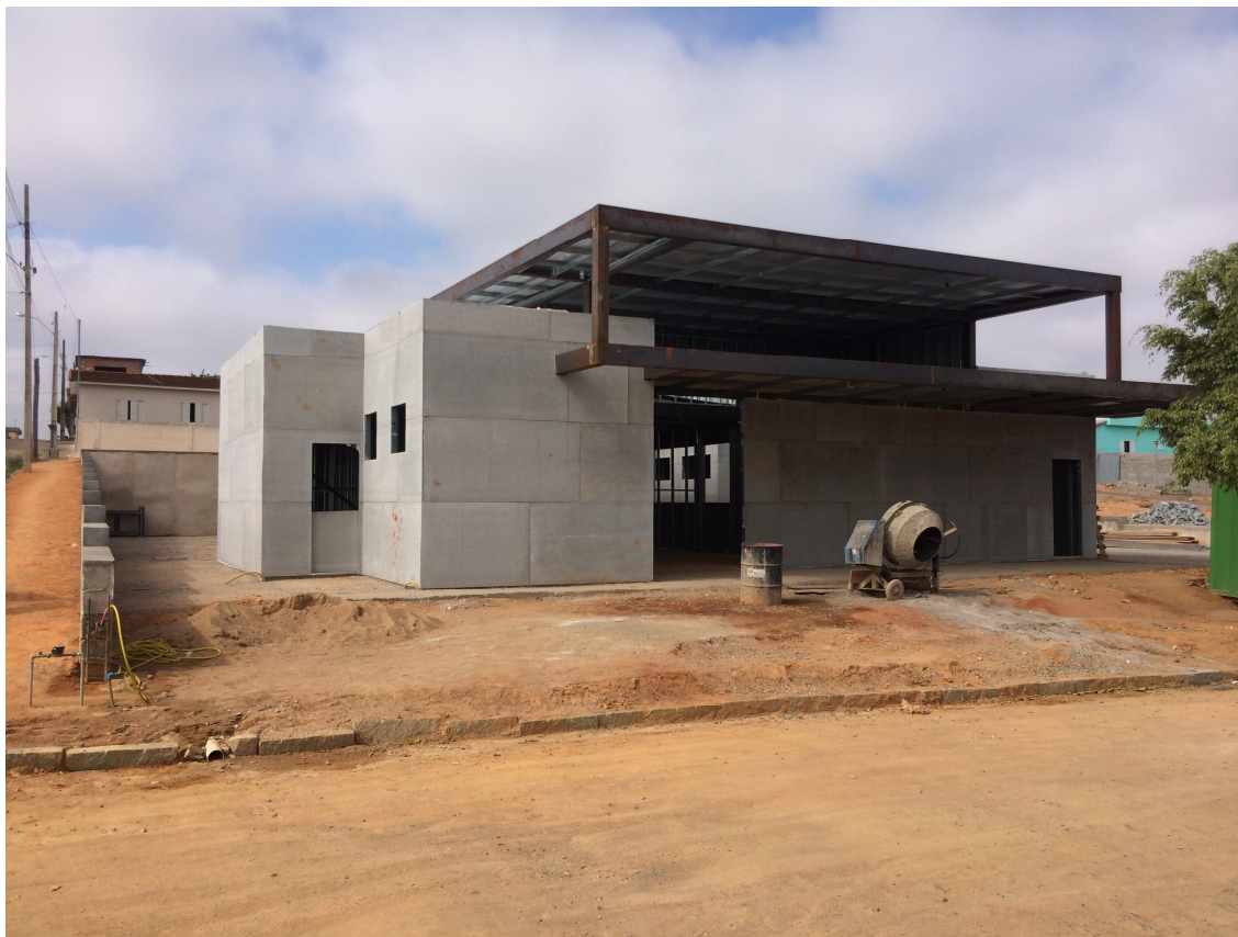
Figura 13 - Fechamento estrutural externo em Placas Cimentícias
