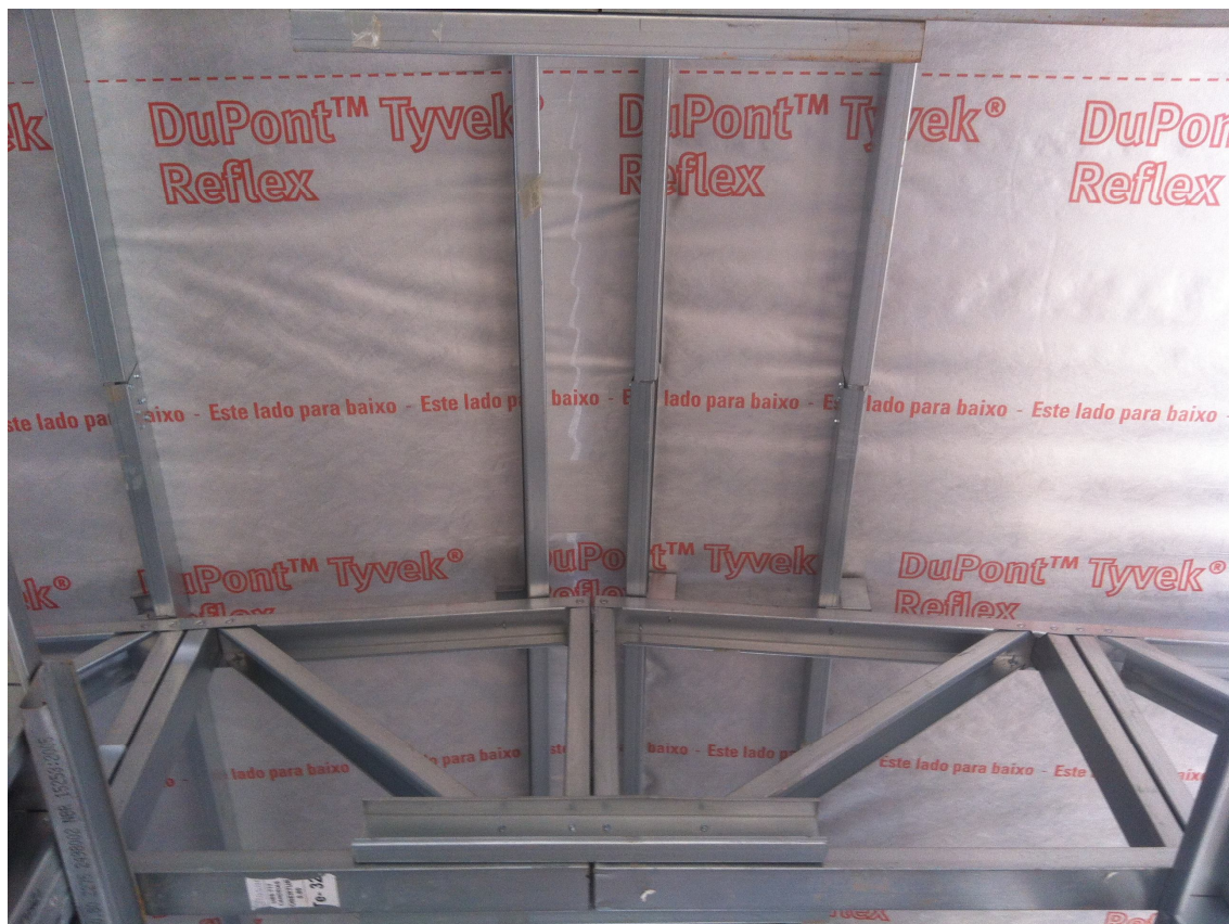
Figura 41 - Isolante térmico instalado entre a estrutura e o telhado
