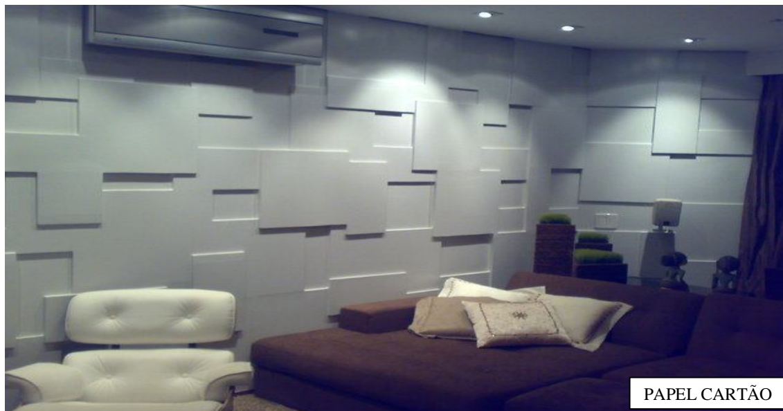
Figura 26 - Acabamento em paredes drywall
