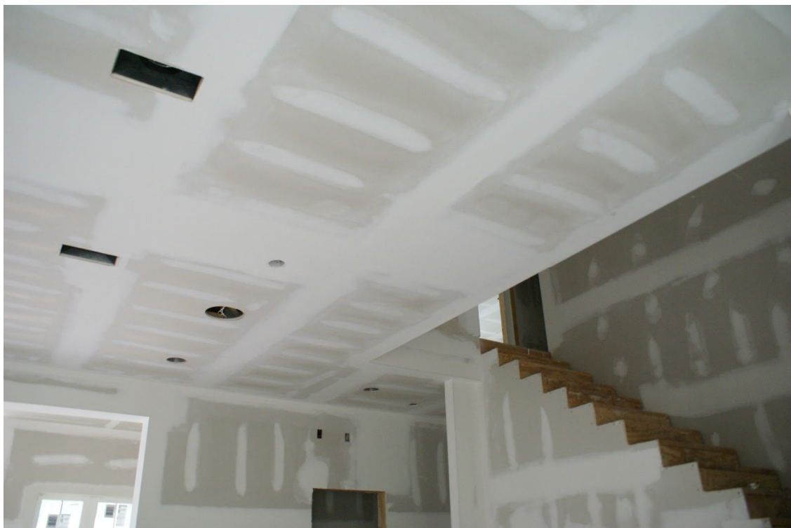
Figura 14 - Fechamento interno em Gesso Acartonado
