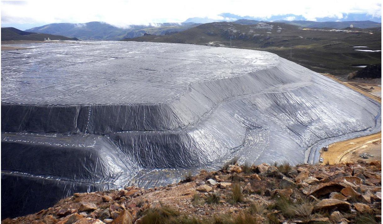
Figura 14 – Aterro de geossintético
