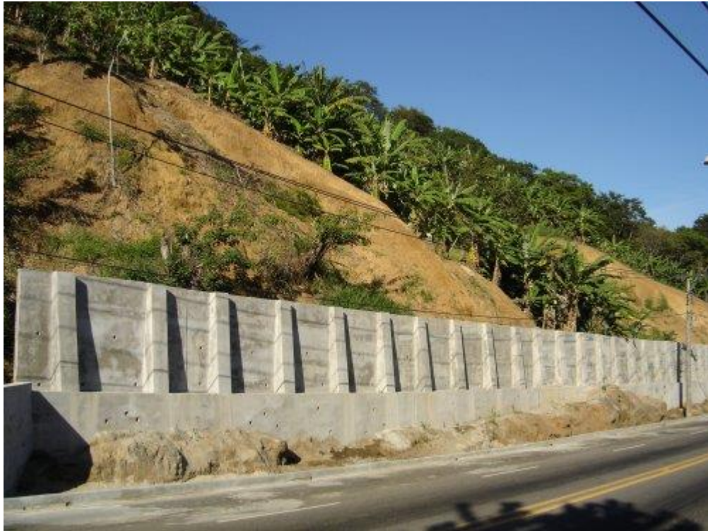
Figura 12 – Muro com contraforte
