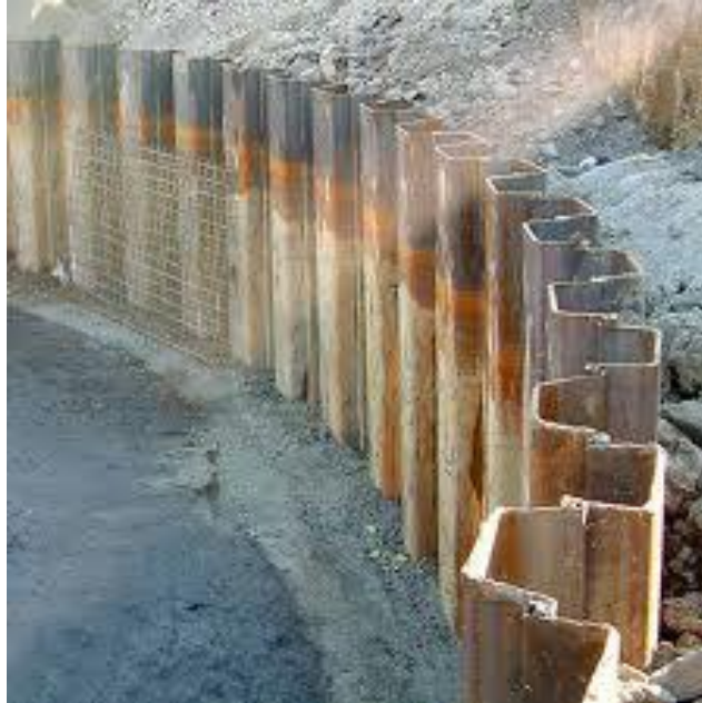
Figura 15 – Cortina de estacas-pranchas
