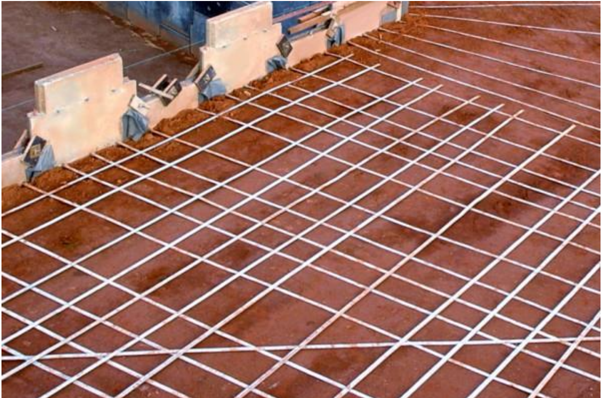
Figura 13 – Execução de terra armada
