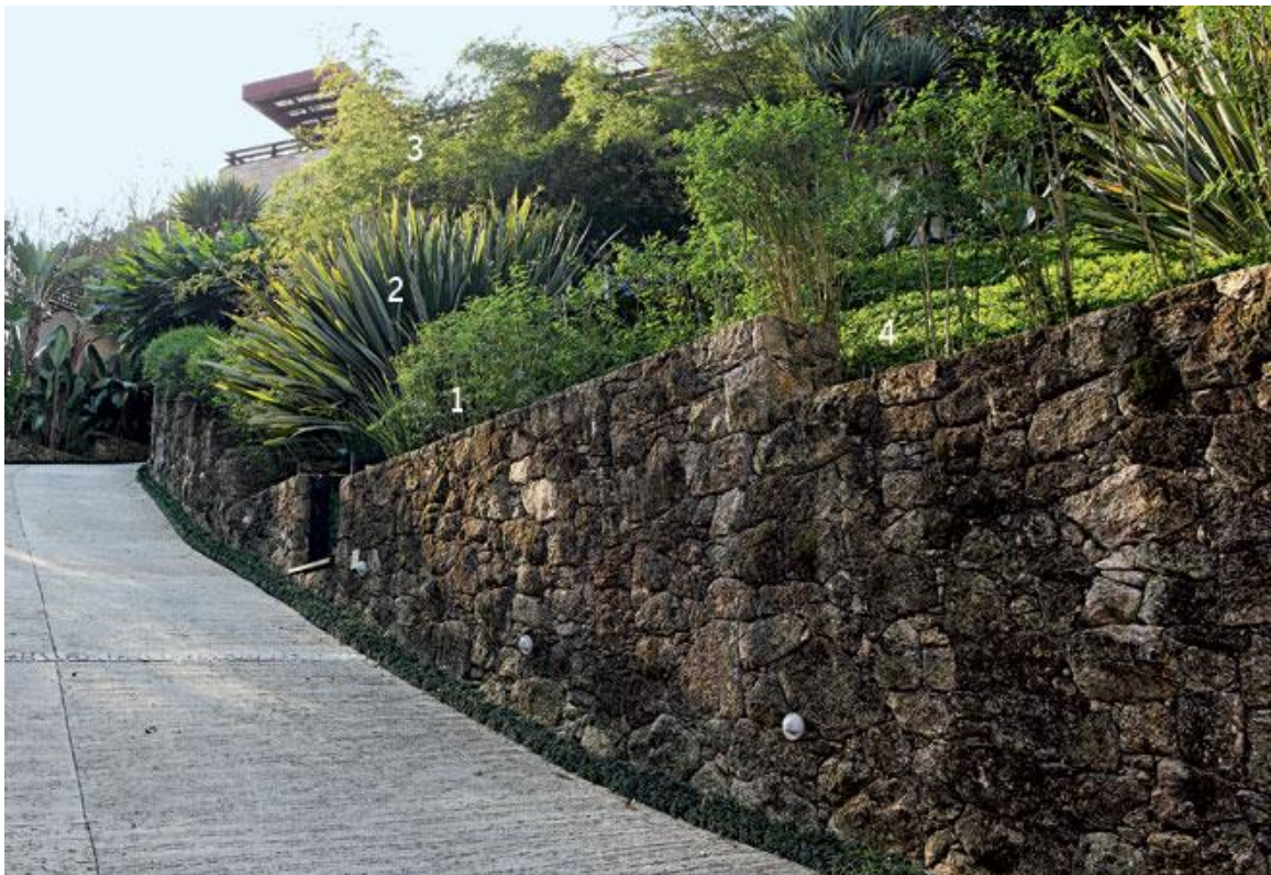
Figura 5 – Muro de gravidade de alvenaria em pedras
