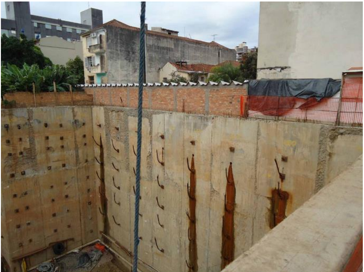
Figura 18 – Parede diafragma
