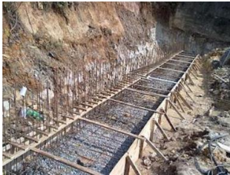
Figura 17 – Execução de parede de estacas metálicas com pranchões de madeira
