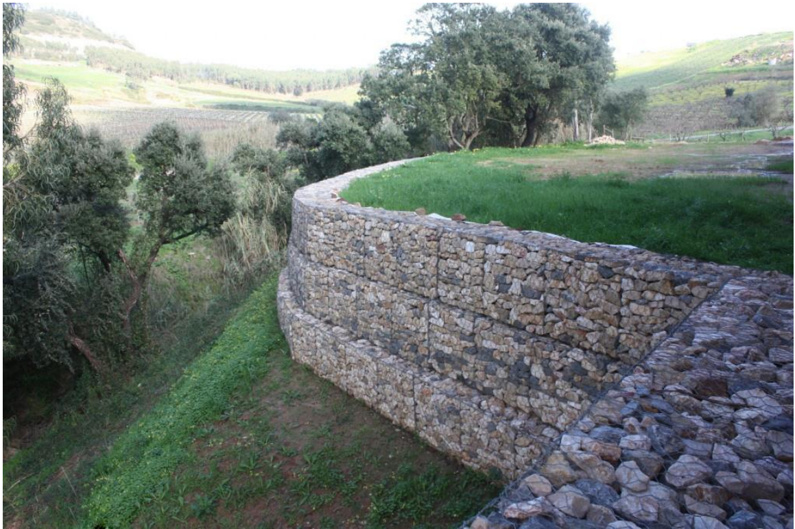
Figura 6 – Muro de gabiões
