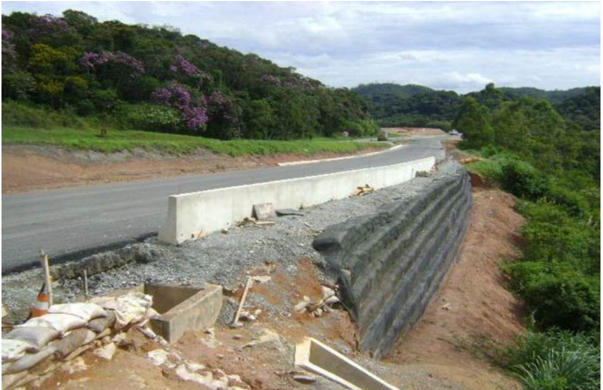
Figura 8 – Muro de sacos de solo-cimento
