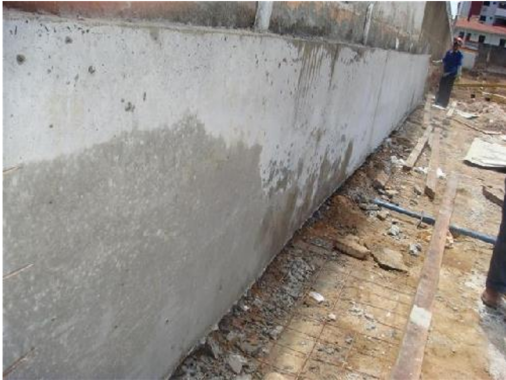
Figura 4 – Muro de gravidade de concreto
