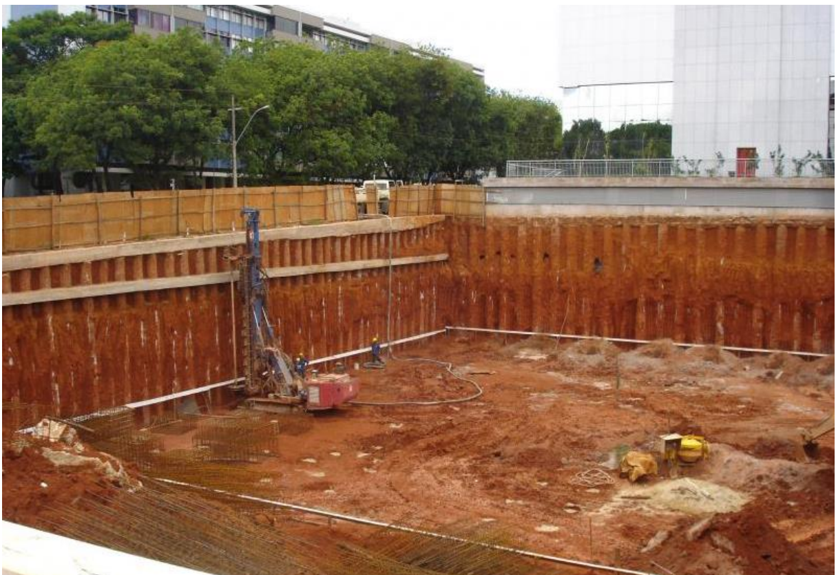
Figura 19 – Muro de estacas escavadas
