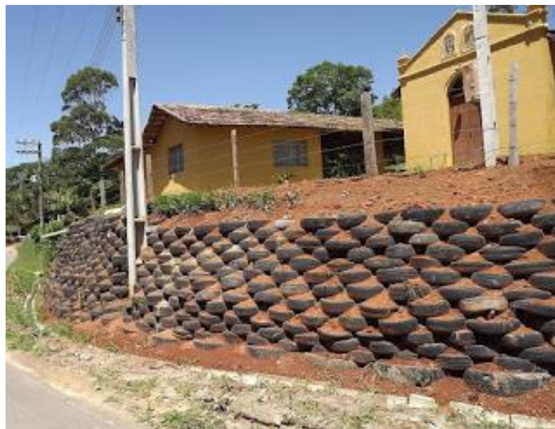
Figura 9 – Muro de pneus
