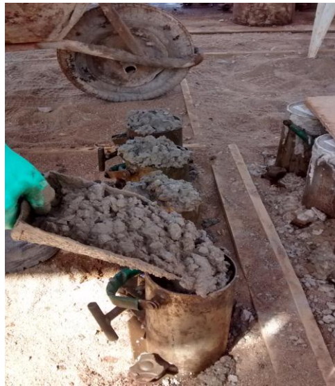
Figura 18 – Lançamento do concreto nos moldes
