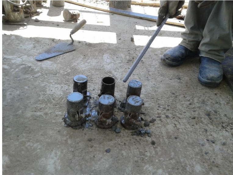
Figura 12 – Adensamento da argamassa
