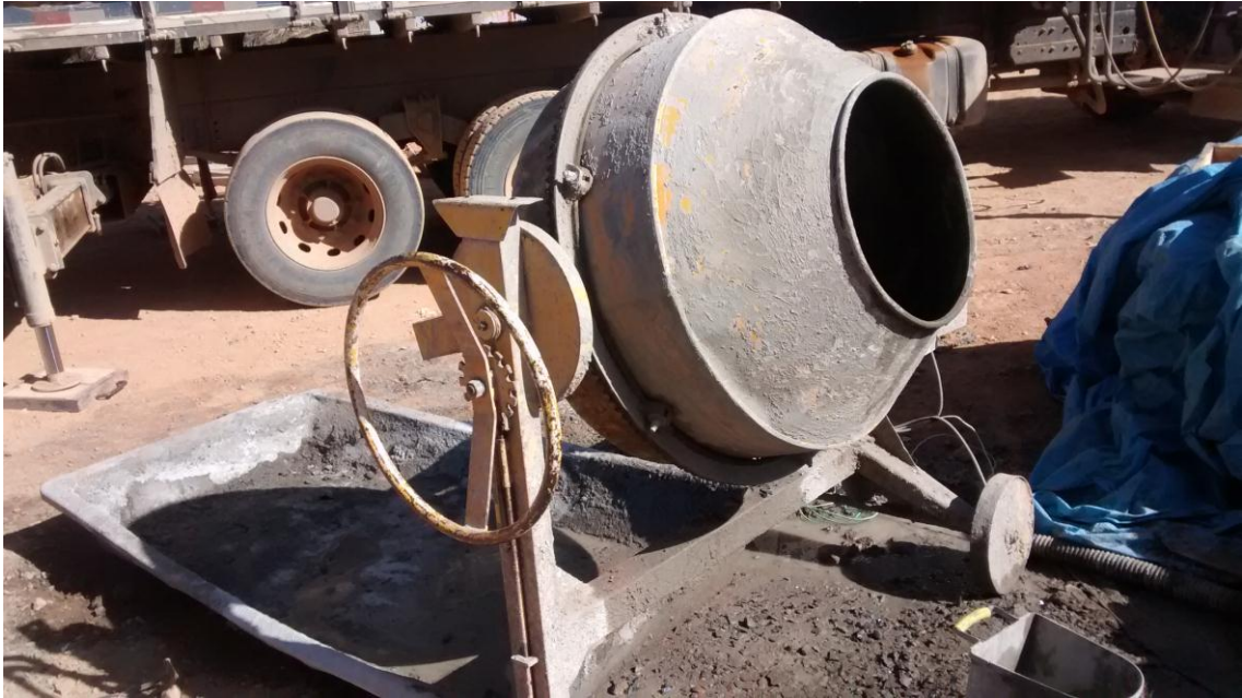
Figura 16 – Betoneira para mistura dos materiais
