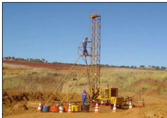
Figura 14 – Procedimento de sondagem.
