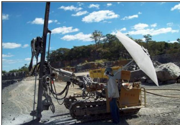
Figura 15 – Procedimento de perfuração.
