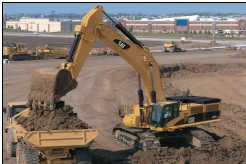
Figura 3 – Escavadeira Caterpillar® 385C L.
