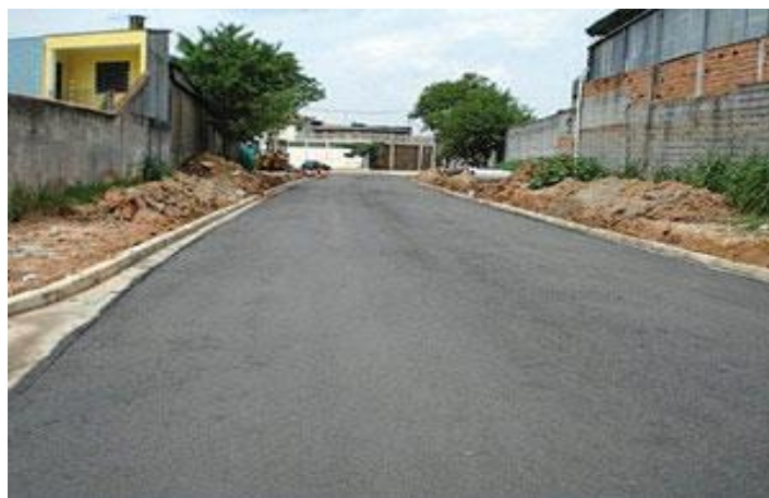
Figura 7 - Pavimento de asfalto feito com adição de agregado reciclado.
