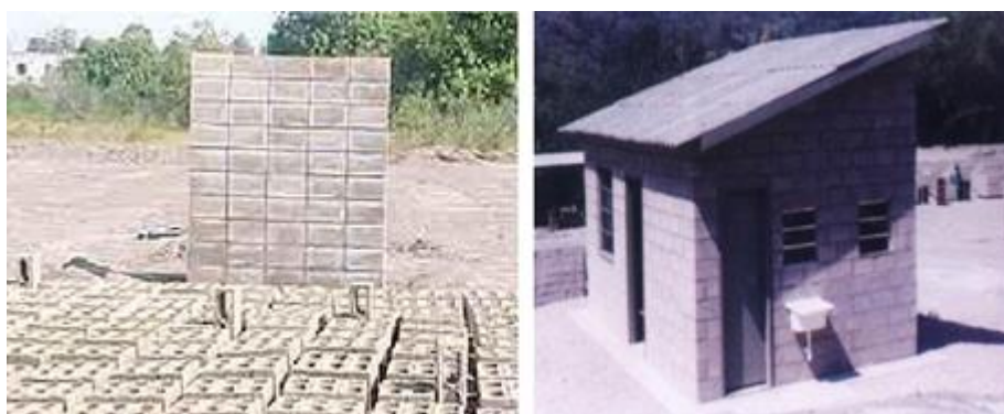
Figura 8 - Blocos e casa popular, feitos a partir do material de demolição do Edifício Andorinhas.
