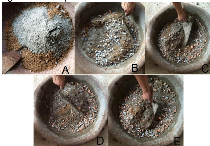
Figura 14 – Preparo do Concreto.
