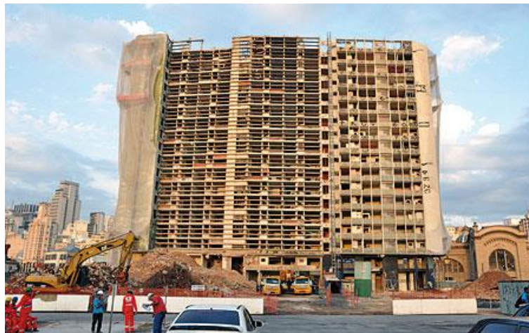
Figura 3 - Edifício São Vito, em São Paulo, prestes a ser demolido.
