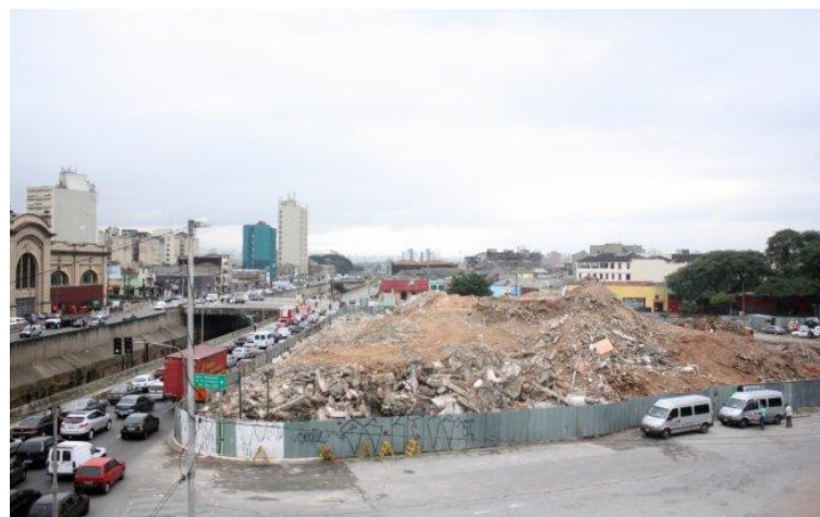
Figura 4 - Demolição do Edifício São Vito, destroços.
