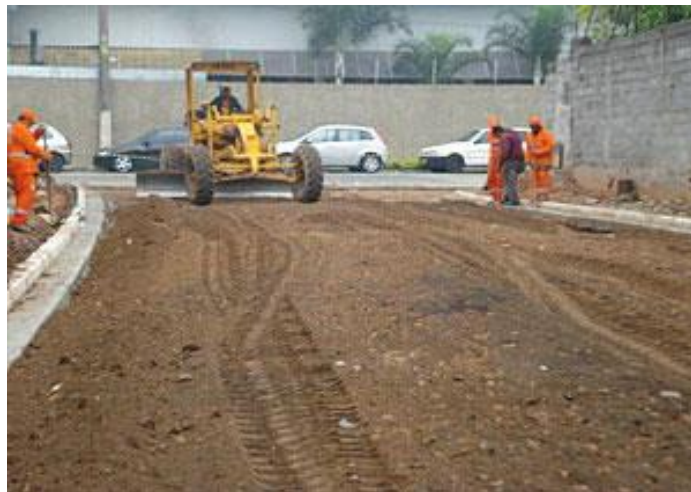
Figura 6 - Aplicação da base de RCD.
