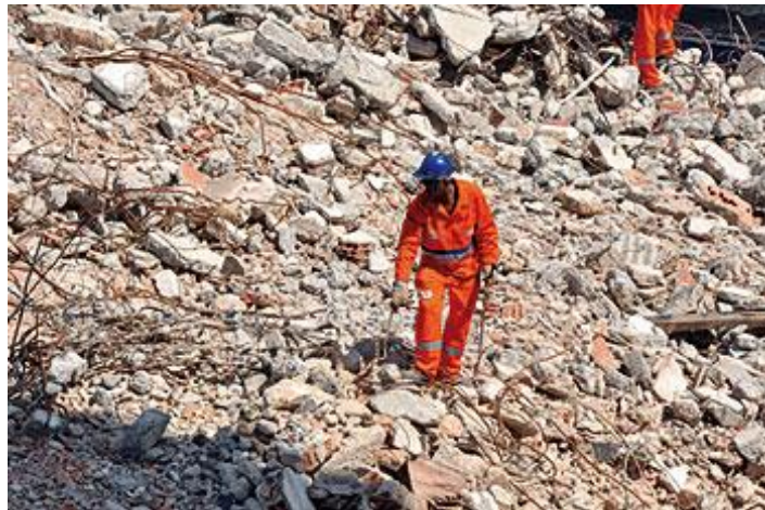
Figura 5 - Seleção dos resíduos da demolição, triagem.
