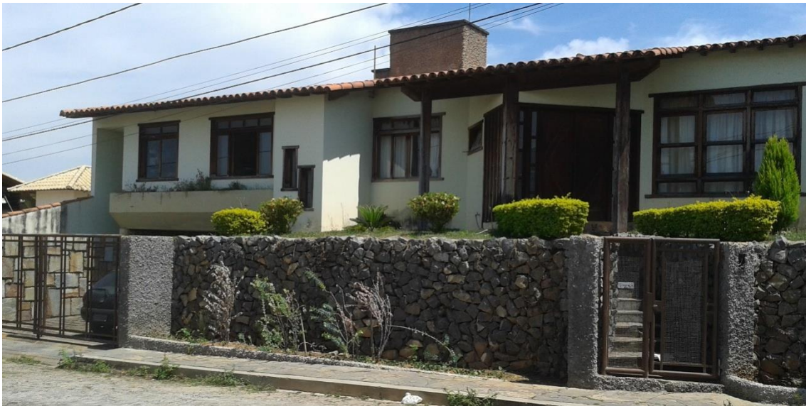
Figura 7– Fachada da residência em estudo, localizada em Formiga – MG.
