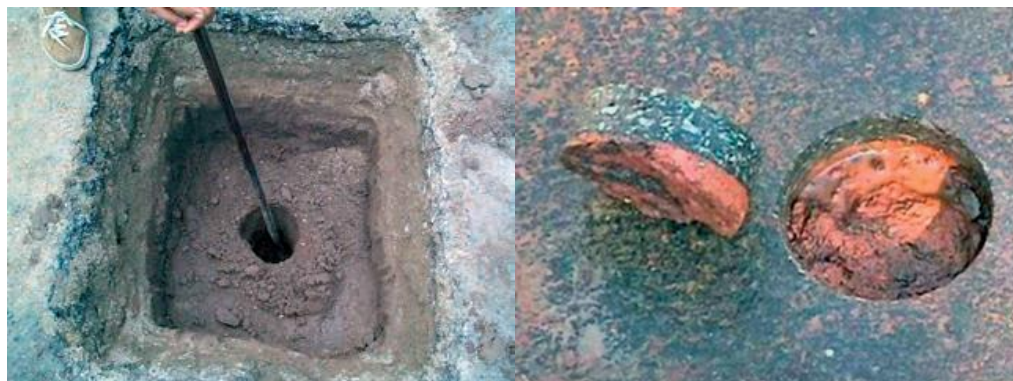
Figura 2 - Extração de corpos-de-prova e de poços de sondagem
