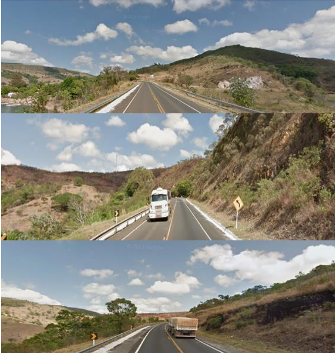
Figura 4 - Atuais características da RODOVIA X - Segmento 12
