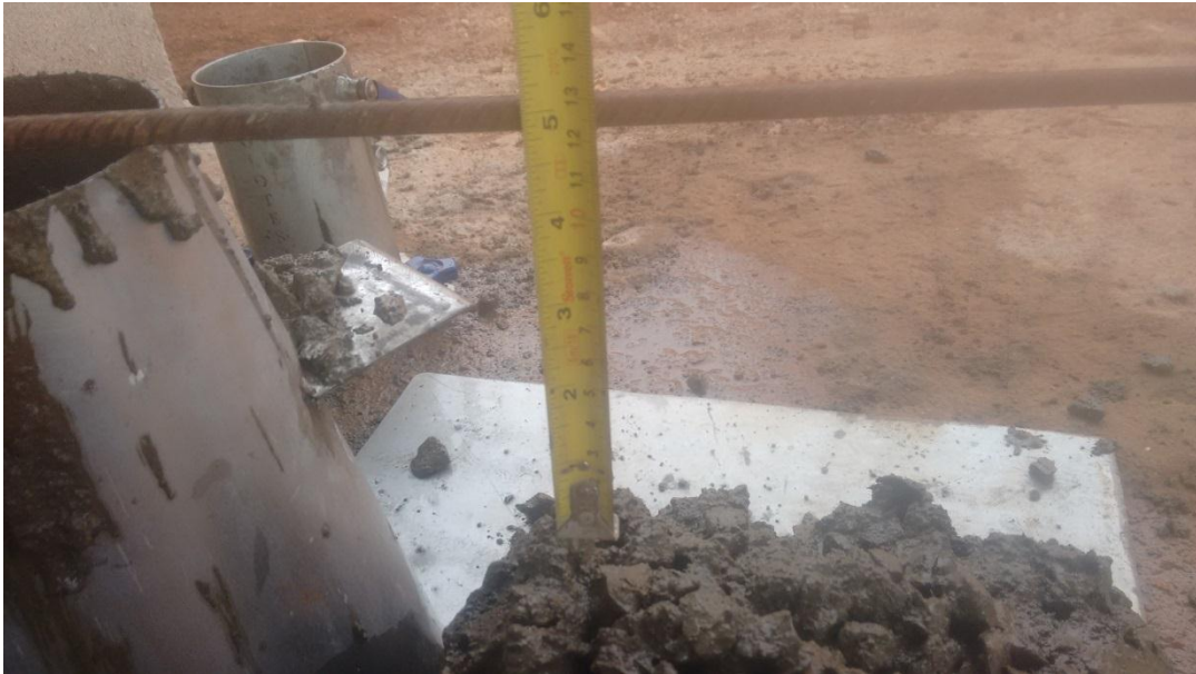
Figura 11 – Aferição do abatimento do concreto
