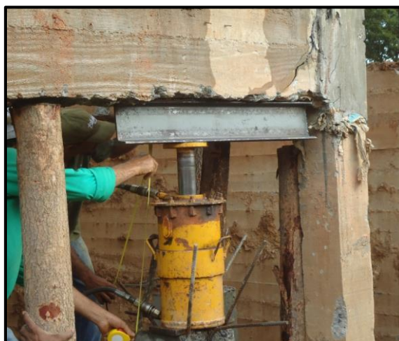
Figura 21 - Perfil metálico e cunhas para auxílio do pistão
