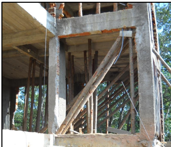
Figura 17 - Reforço provisório
