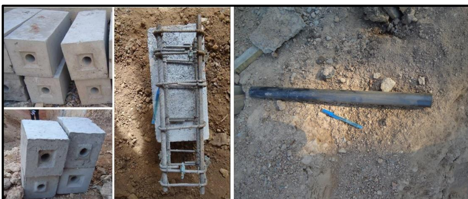
Figura 24 - Estacas Mega e peça cilíndrica de aço
