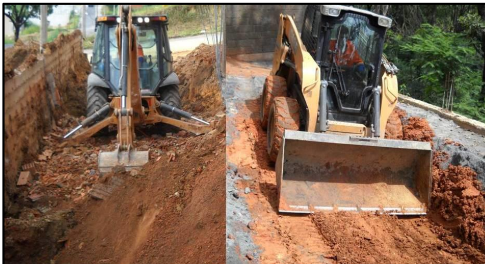
Figura 16 - Remoção do aterro
