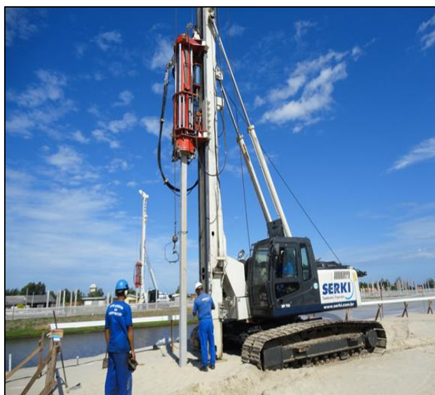
Figura 1 - Estaca cravada à percussão
