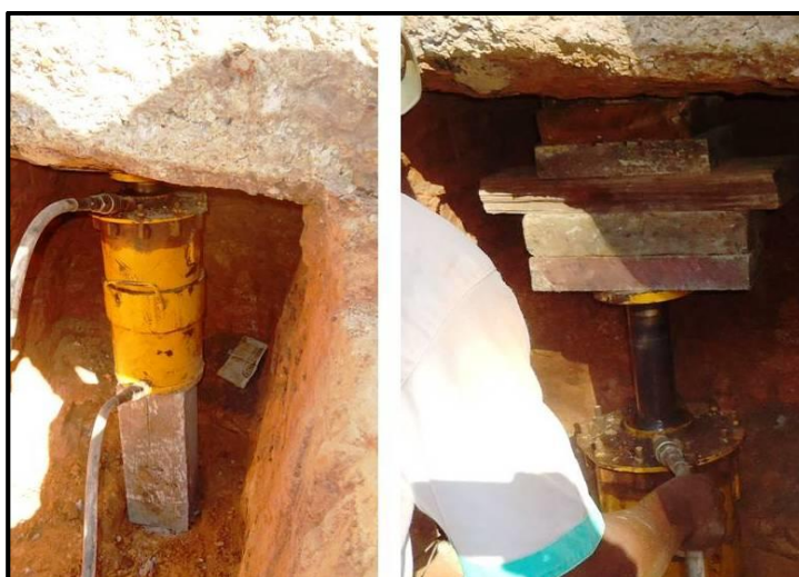
Figura 25 - Posicionamento da estaca e pistão, e uso de calços de madeira
