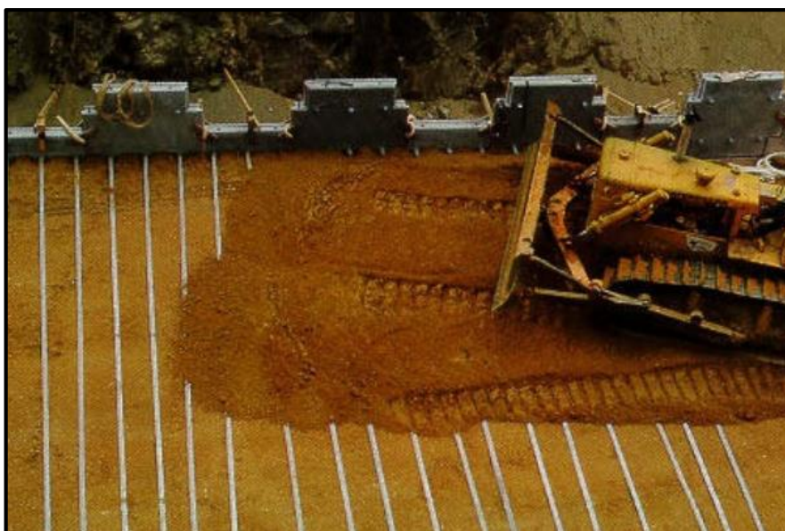
Figura 11 - Solo armado com elementos metálicos
