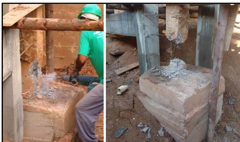
Figura 22 - Retirada do bloco
