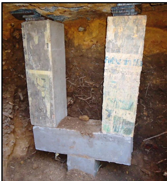
Figura 27 - Finalização do reforço
