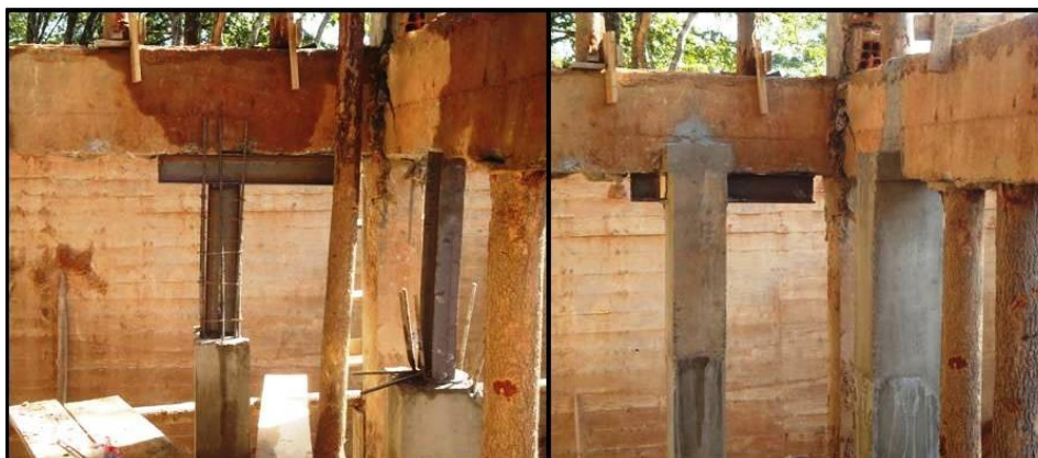
Figura 23 - Perfis metálicos em substituição do pistão
