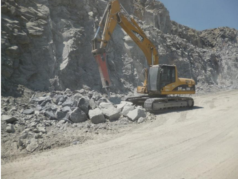
Figura 14 – Rompedor hidráulico acoplado a escavadeira
