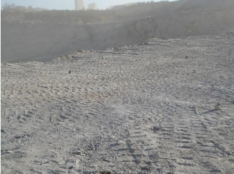
Figura 11 – Limpeza da área a ser perfurada
