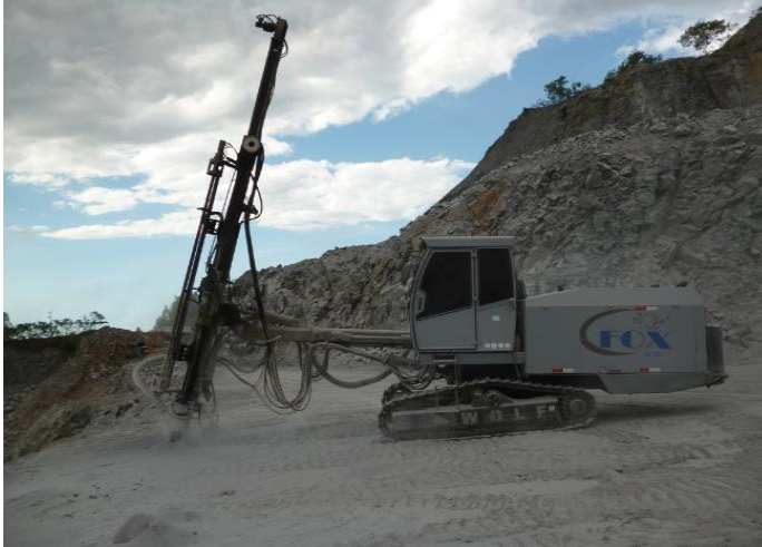
Figura 4 – Perfuratriz roto percussiva Hidráulica
