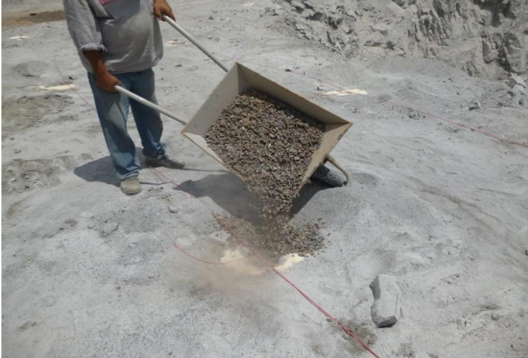
Figura 13 – Tamponamento utilizando Brita P-1
