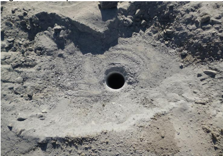
Figura 12 – Limpeza da boca da mina
