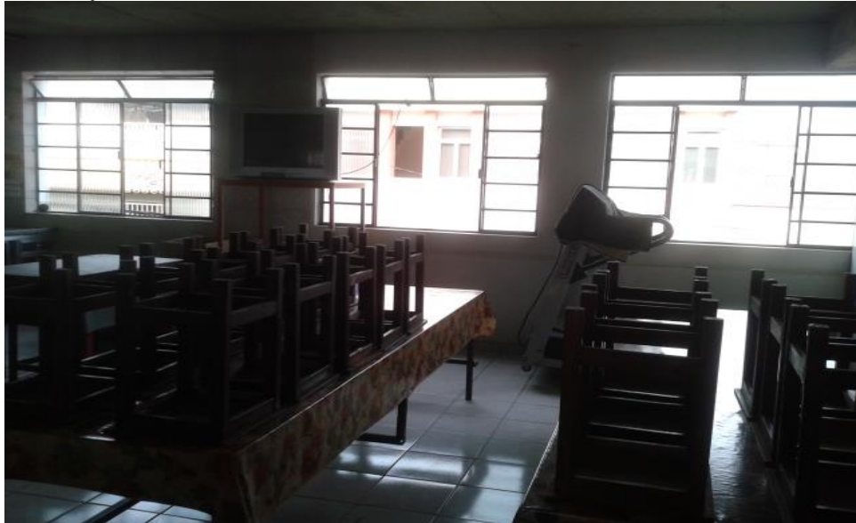
Figura 21 – Arejamento do refeitório
