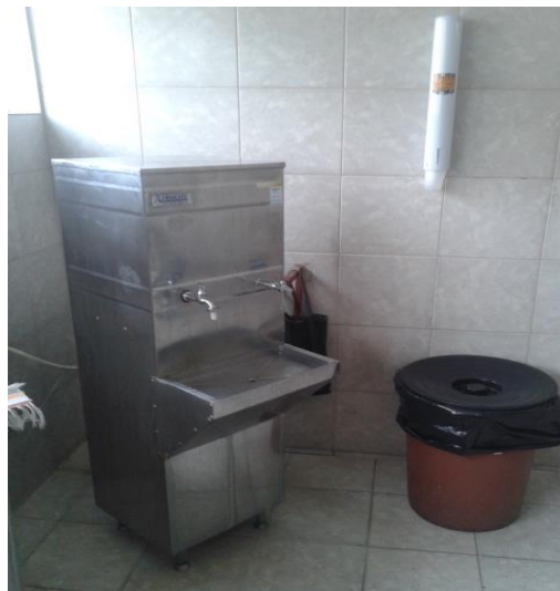
Figura 10 - Condições do local onde é localizado o filtro de água após vistoria
