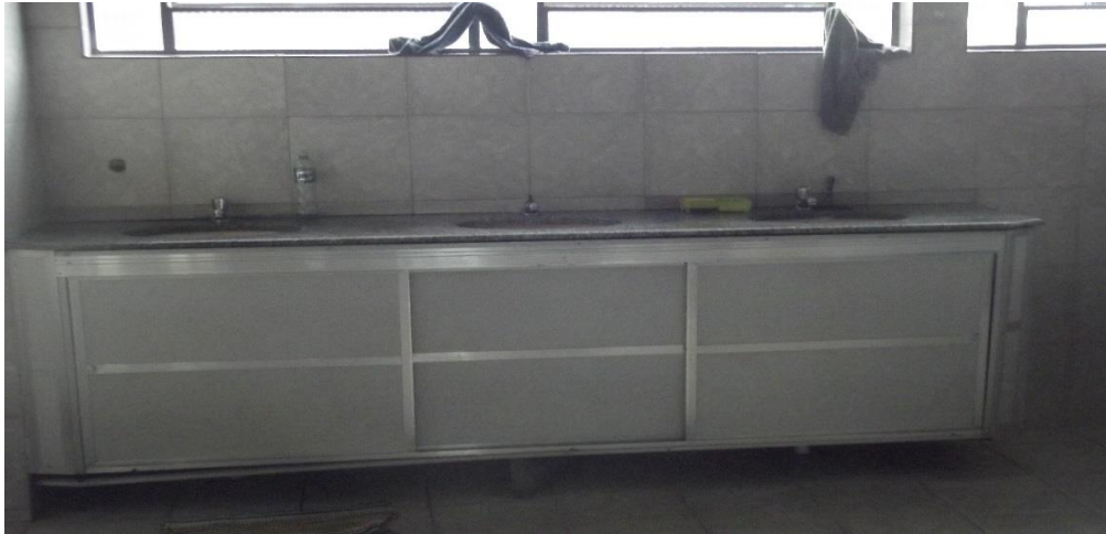
Figura 7 – Existência de produtos de higiene nos sanitários antes da vistoria
