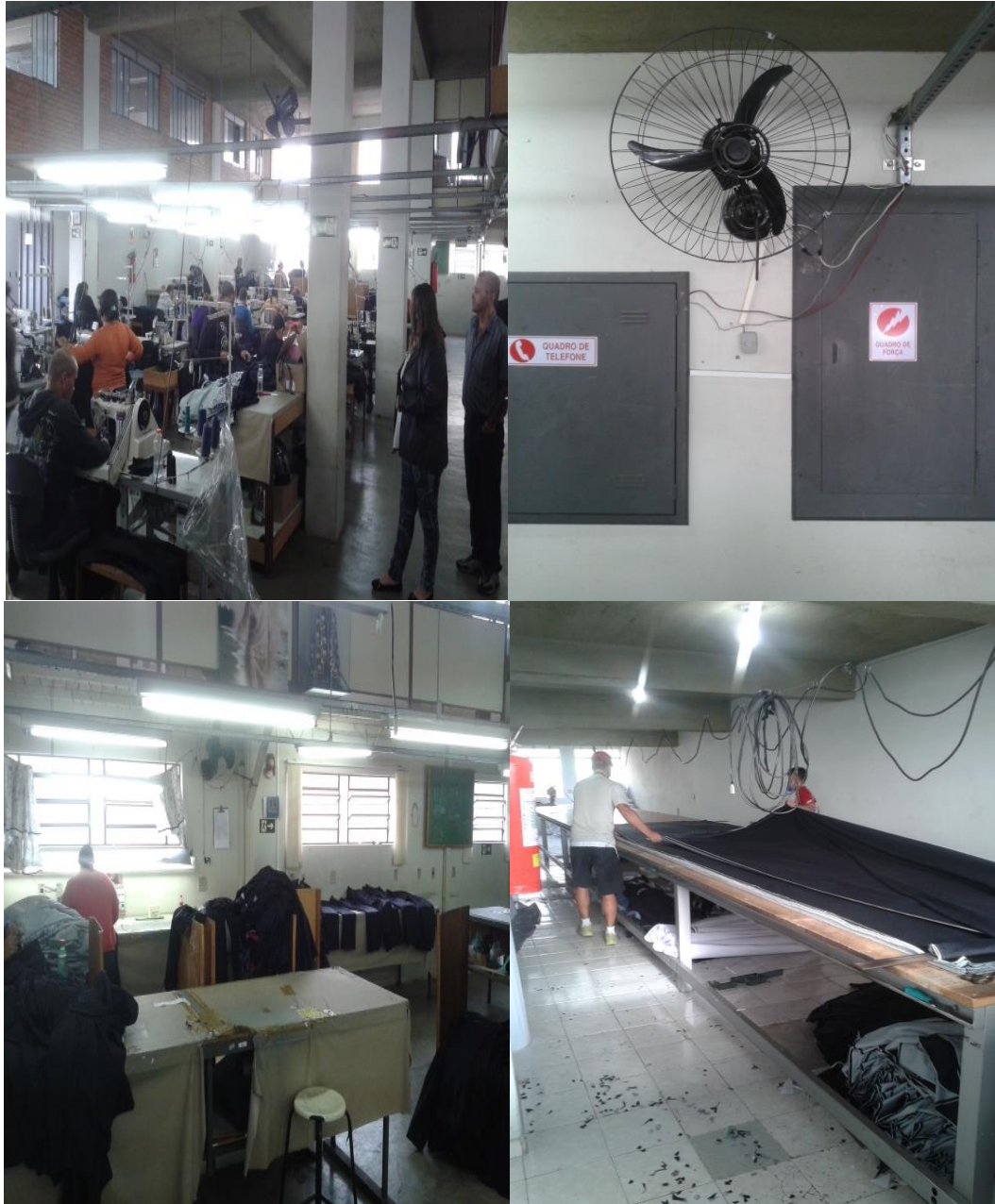
Figura 13 – Aspecto dos sistemas de ventilação
