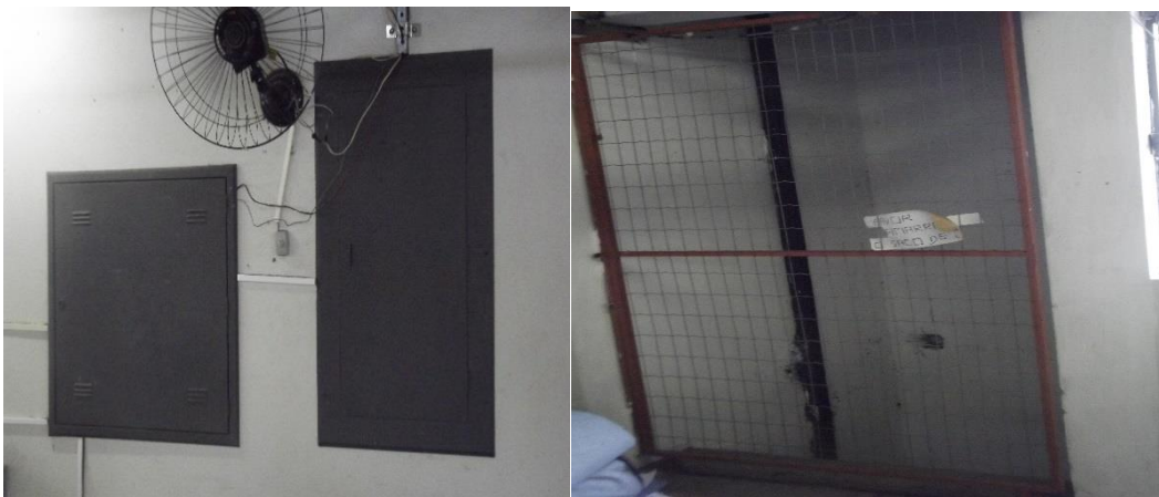
Figura 4 – Instalações elétricas antes da vistoria
