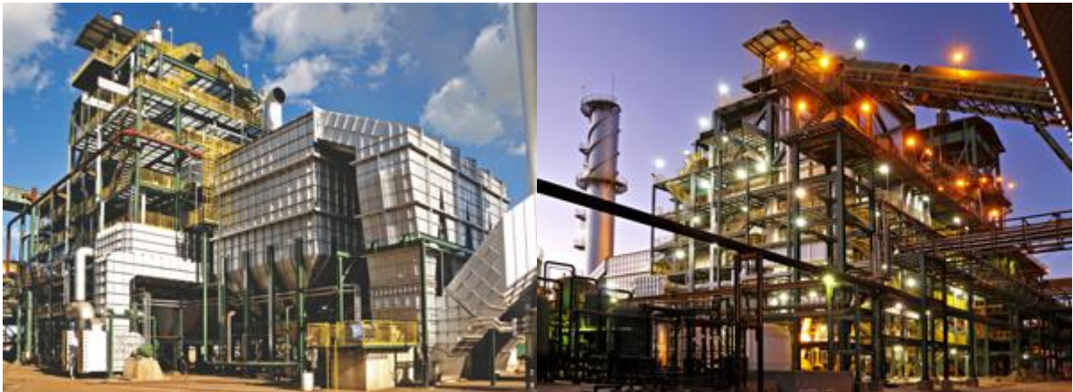
Figura 7 - Foto da Caldeira Aquatubular Monodrum
