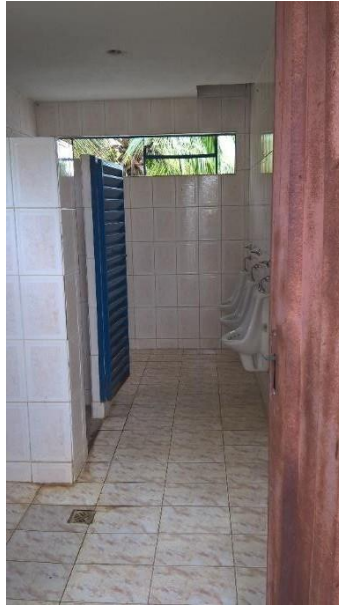
Figura 97 – Interior dos banheiros
