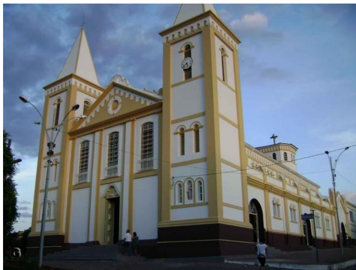
Figura 80 – Igreja Matriz Nossa Senhora do Carmo – Arcos/MG
