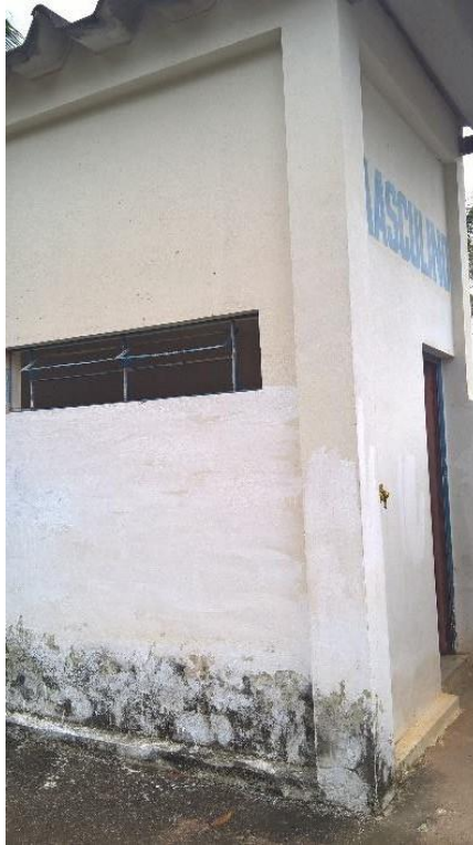
Figura 95 – Exterior dos Banheiros e Vestiários
