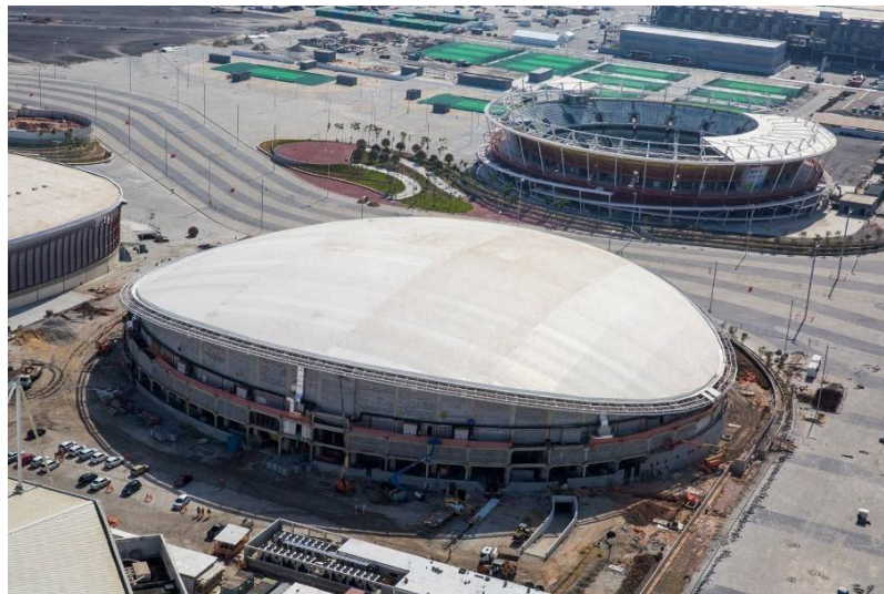
Figura 36 – Construção do Velódromo
