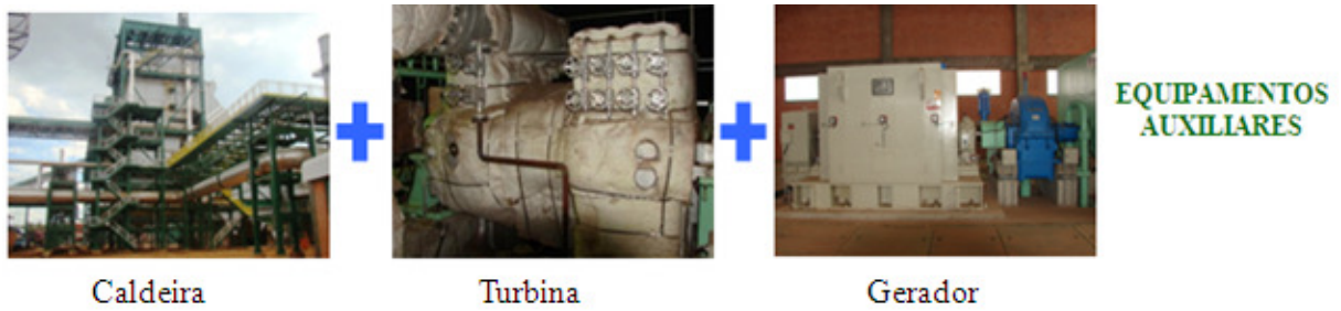
Figura 7 – Constituição do Sistema de Cogeração da usina estudada
