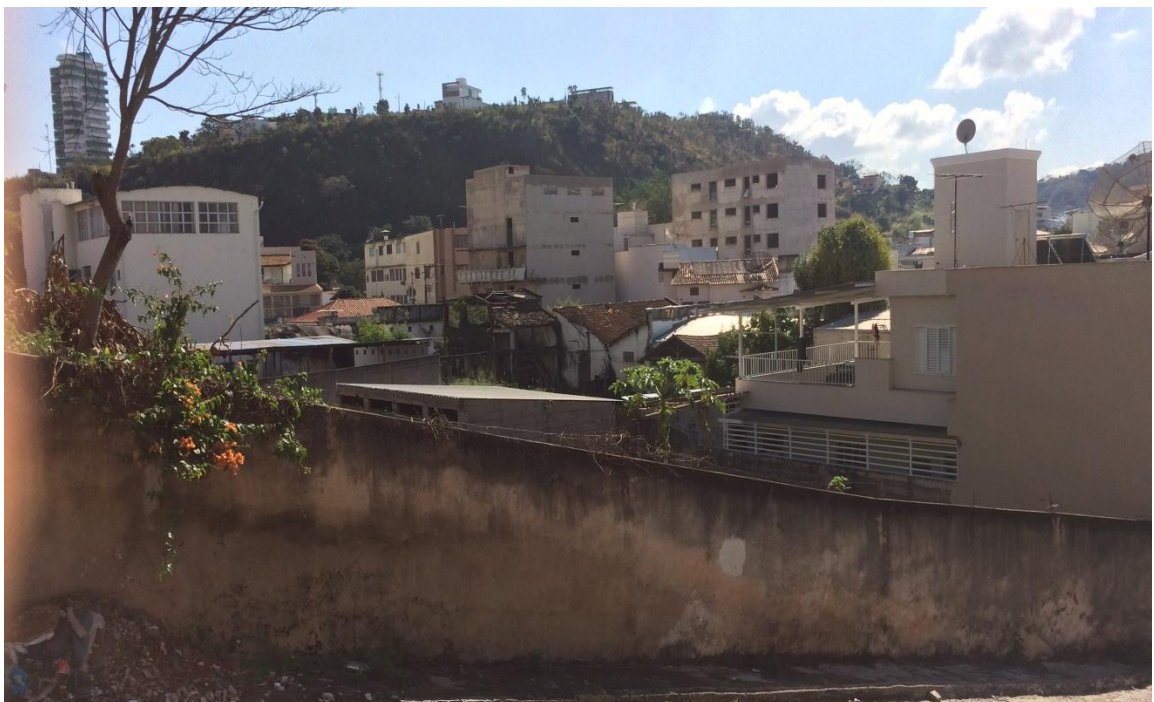
Figura 62 – Fachada Rua Ana Parreira Barbosa, acesso 2
