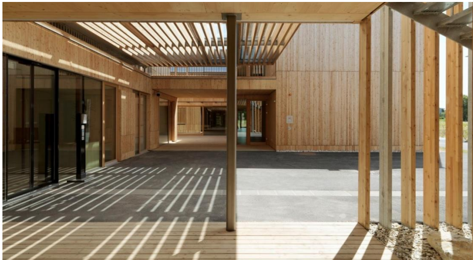
Figura 37 – Vista do interior da edificação do Lar de Idosos Peter Rosegger
