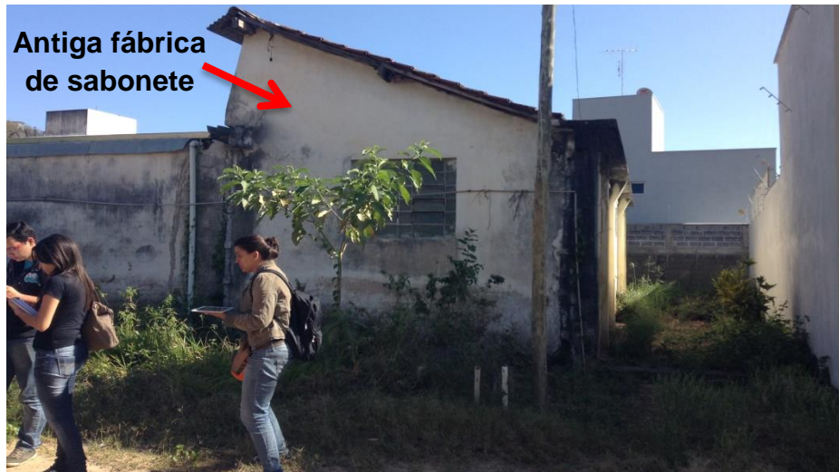
Figura 66 – Interior do terreno 4
