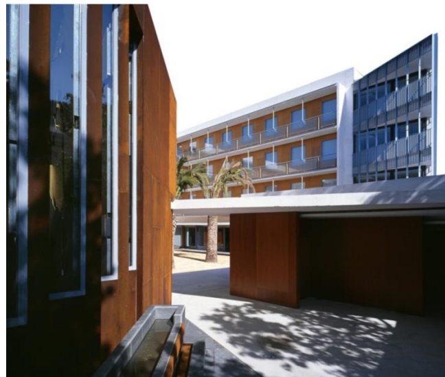
Figura 46 – Vista interna da Residencia para Tercera Edade
