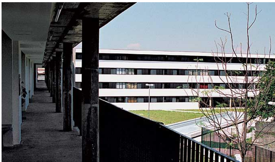
Figura 41 – Galeria de pilotis no Residencial Vila dos Idoso
