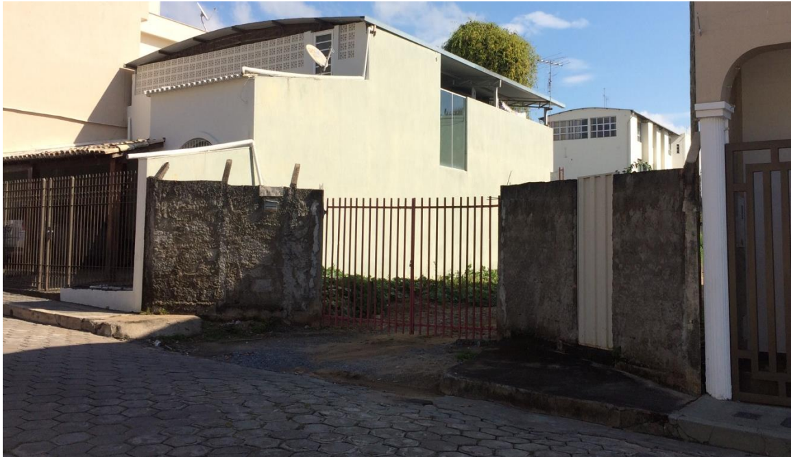
Figura 61 – Fachada Rua Ana Parreira Barbosa, acesso 1
