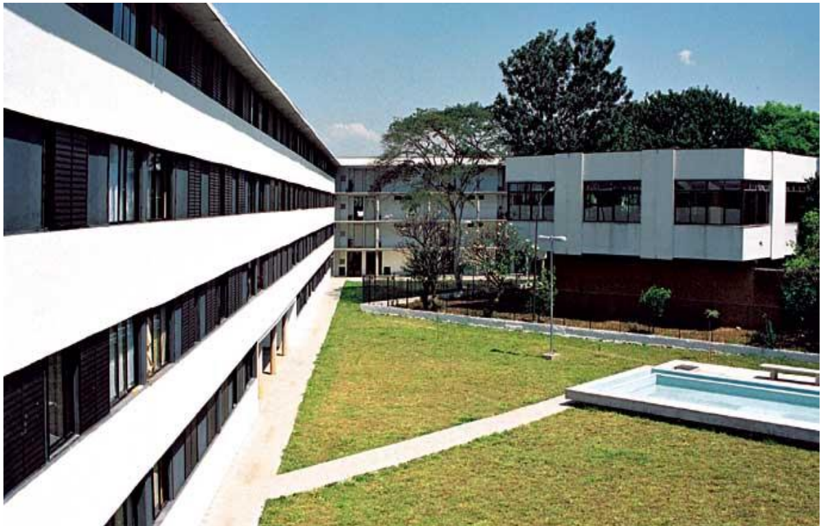
Figura 39 – Vista do interior do Residencial Vila dos Idoso
