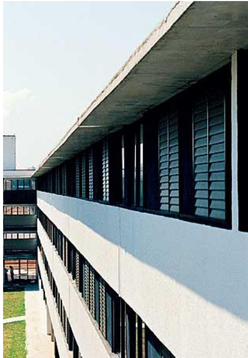
Figura 40 – Vista da fachada interna do Residencial Vila dos Idoso.
