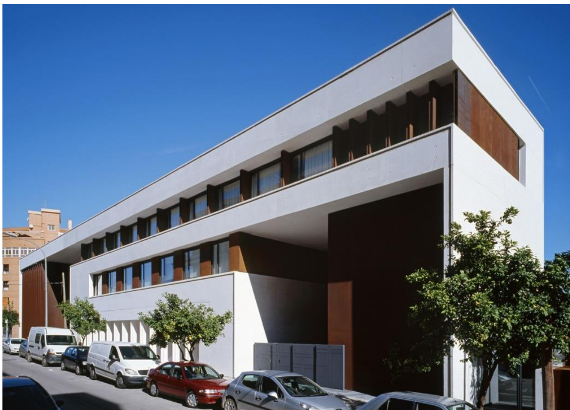
Figura 44 – Fachada frontal do Residencia para Tercera Idade
