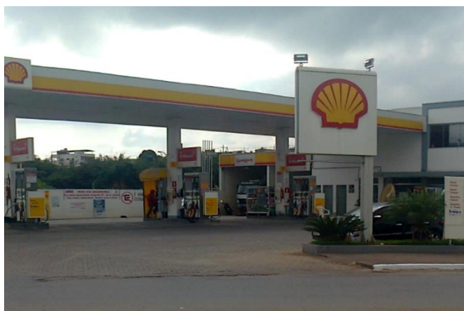
Figura 83 – Auto Posto Avenida
