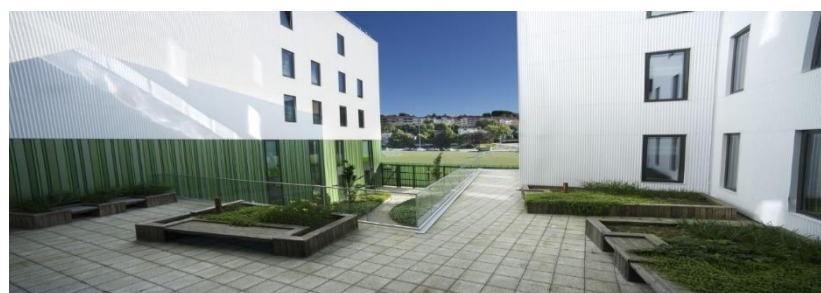
Figura 68 – Terraço jardim integrados aos quartos de internação
