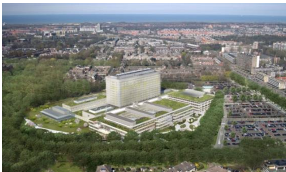
Figura 11 – Implantação e entorno do Haga Hospital – Haia/Holanda
