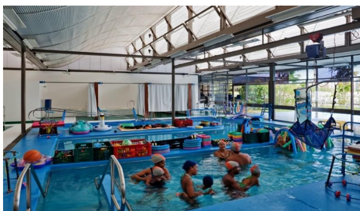
Figura 52 – Área de piscina com shed's metálicos e brises horizontais
