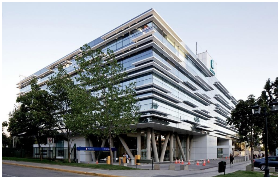
Figura 40 – Brises na fachada frontal do Centro Clínico Manquehue
