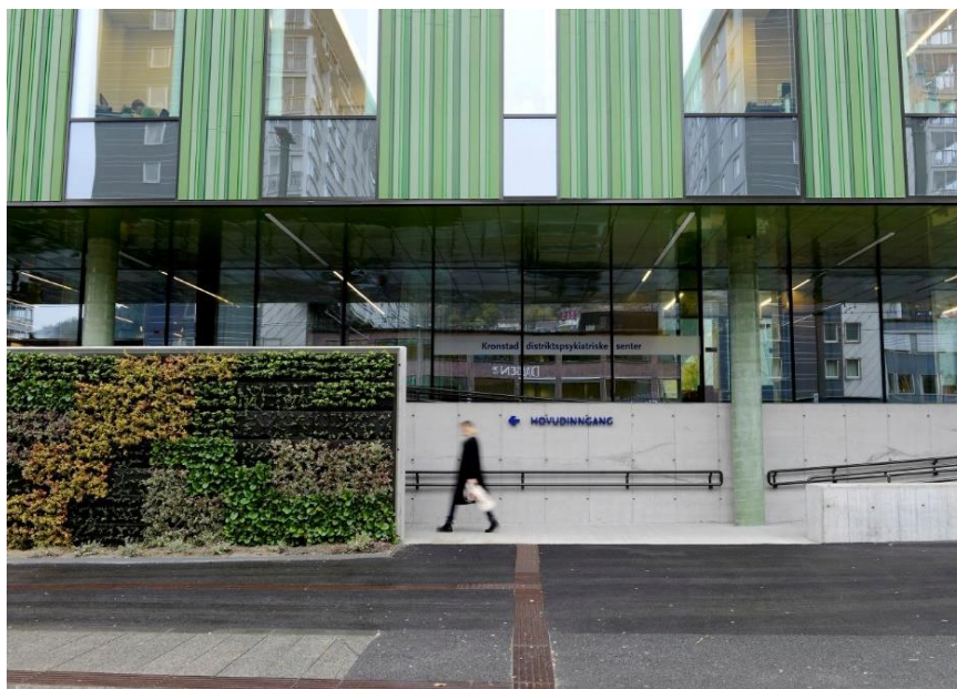
Figura 65 – Jardim vertical na fachada do Hospital
