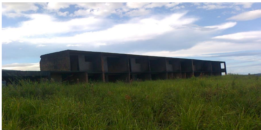
Figura 72 – Antiga edificação em ruínas
