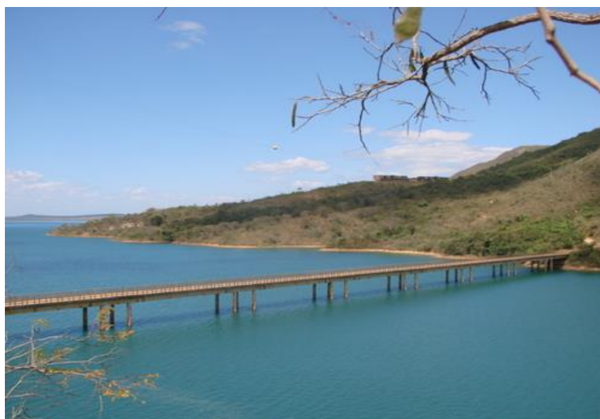
Figura 60 – Ponte de Santo Hilário Atualmente
