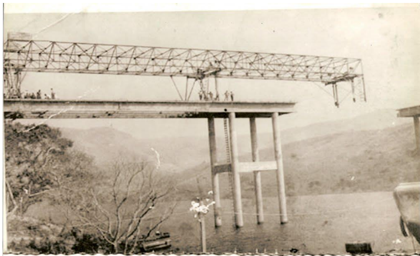
Figura 59 – Construção da Ponte de Santo Hilário na década de 60
