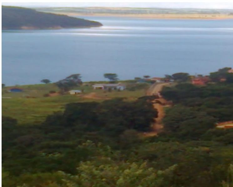
Figura 71 – Condomínio Pena Branca
