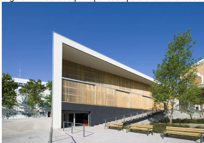
Figura 4 - Fachada principal casa para a terceira idade
