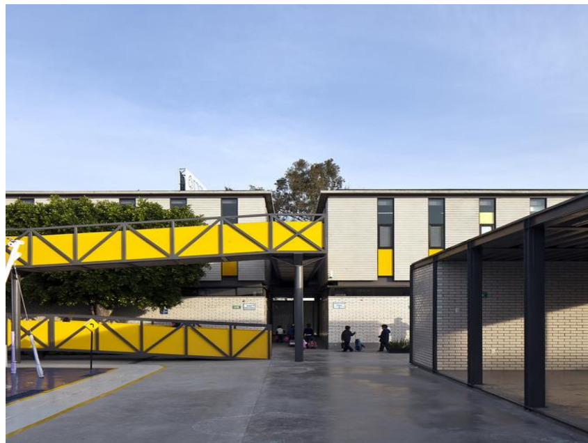
Figura 14 - Vista rampa edifício pré-escolar
