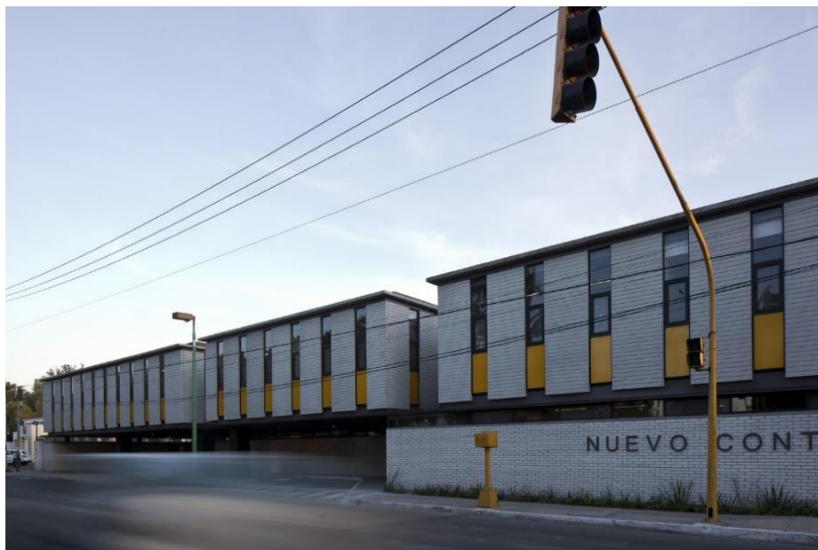
Figura 12 - Fachada principal edifício pré-escolar
