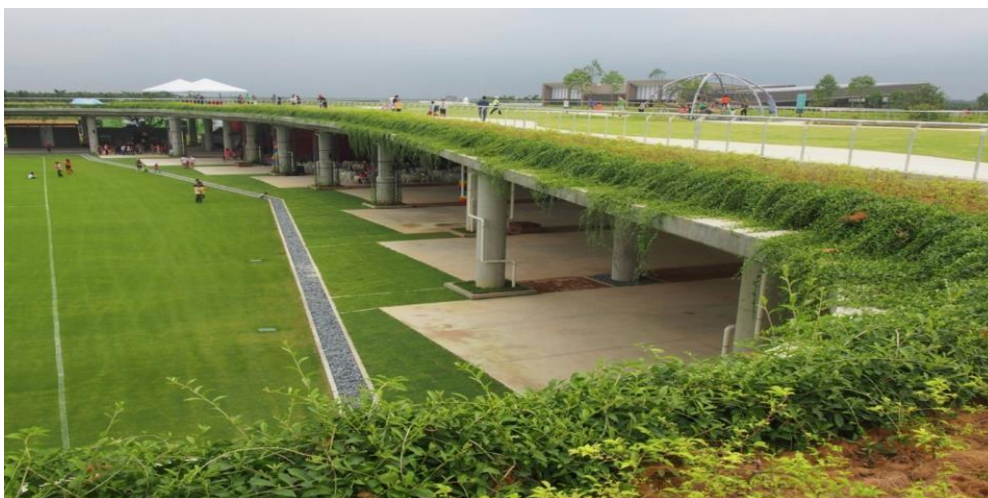
Figura 19 - Arco em Bandar Rimbayu (passarela coberta por vegetação)
