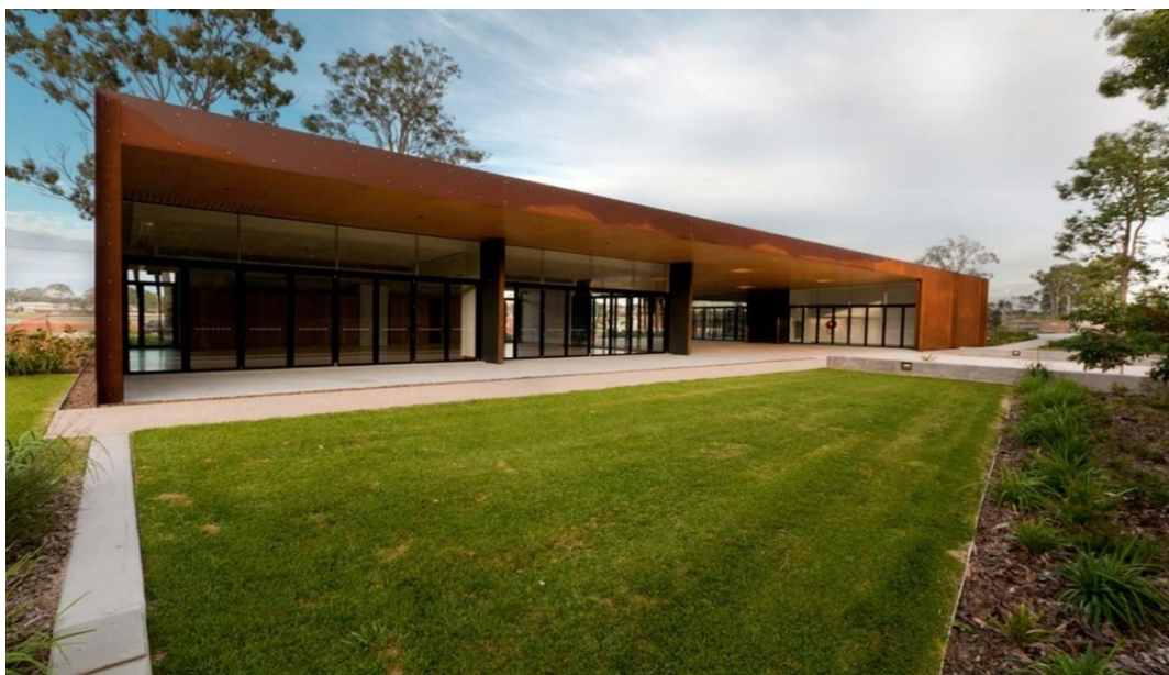
Figura 7 – Centro comunitário Fitzgibbon (vista posterior)
