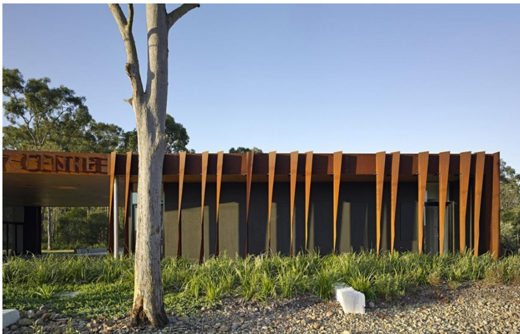
Figura 9 – Centro comunitário Fitzgibbon (fachada principal)
