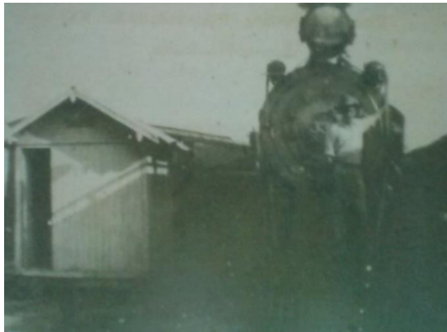
Figura 28 - Antiga Estação Ferroviária de Lagoa da Prata
