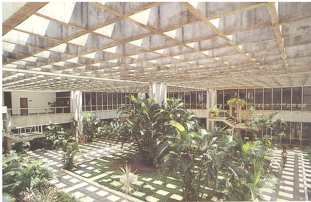
Figura 52- Vista de praça/jardim interno CPA Cuiabá-MT
