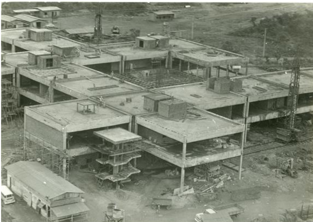
Figura 51- setores do CPA Cuiabá-(MT) em construção.
