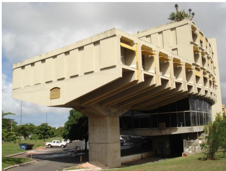
Figura 41-Destaque pilara prédio secretarias CAB
