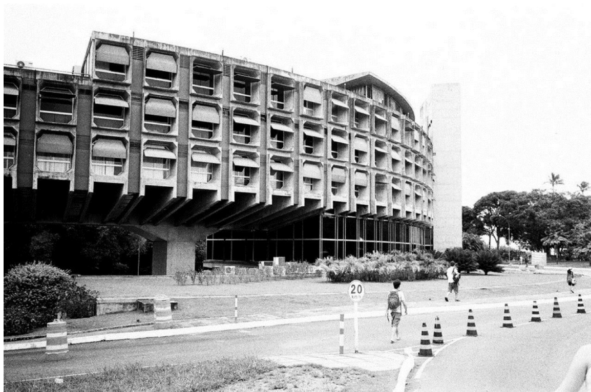
Figura 43-Fachada prédio das secretarias destaque caixas
