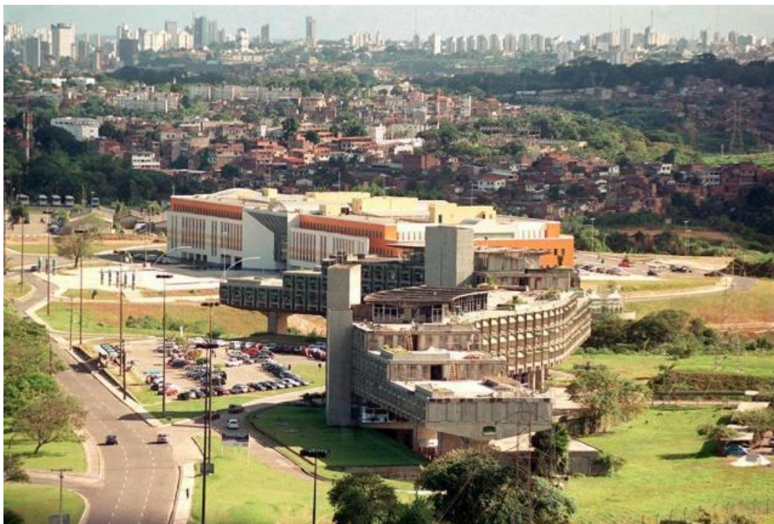
Figura 40-Perspectiva de um dos prédios secretarias CAB
