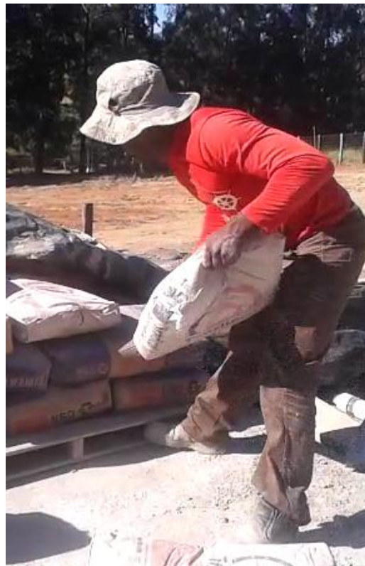
Figura 20 – Manuseio de sacas de cimento
