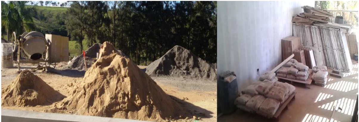
Figura 7- distribuição do material de construção
