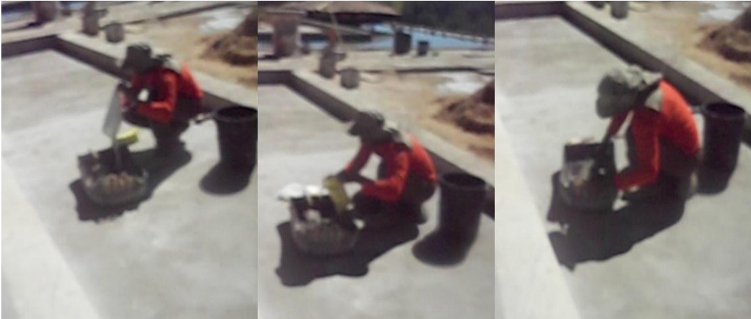
Figura 11 – Preparação do impermeabilizante
