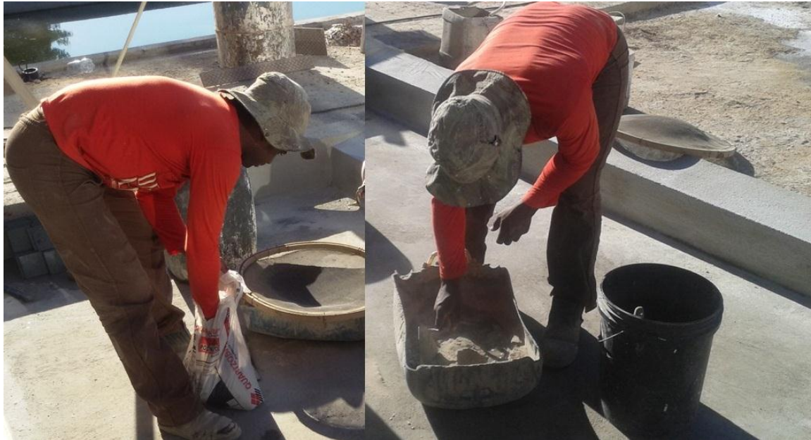
Figura 17 – Preparação da argamassa
