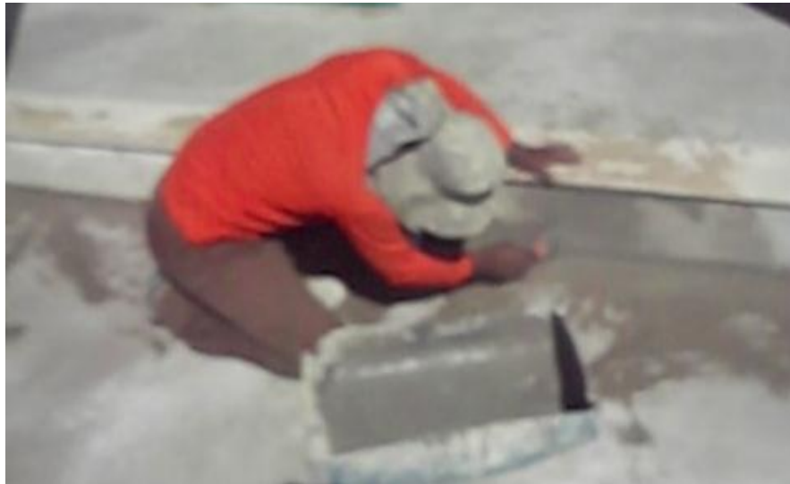
Figura 15 – Aplicação do impermeabilizante
