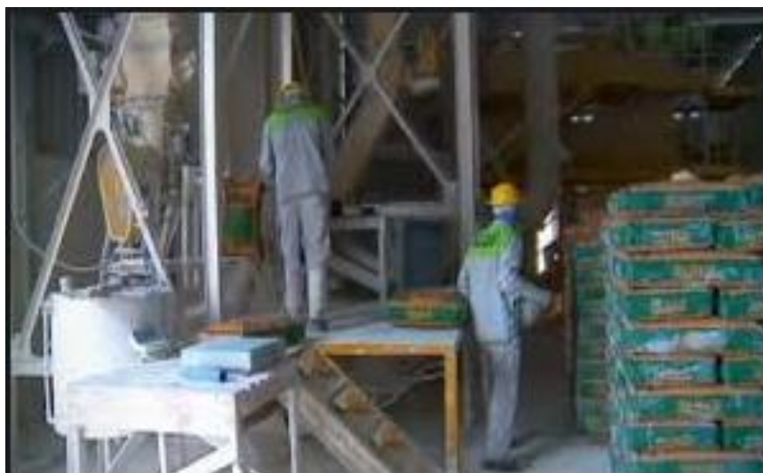
Figura 6 - Acondicionamento da cal
