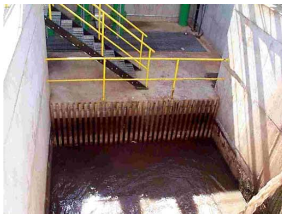
Figura 4 - Exemplo de gradeamento
