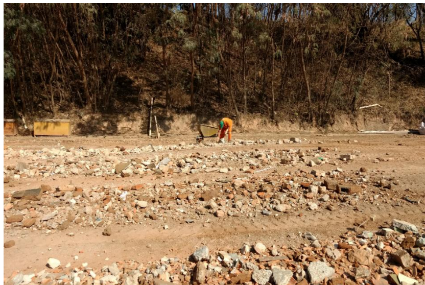
Figura 9 - Material espalhado para triagem manual
