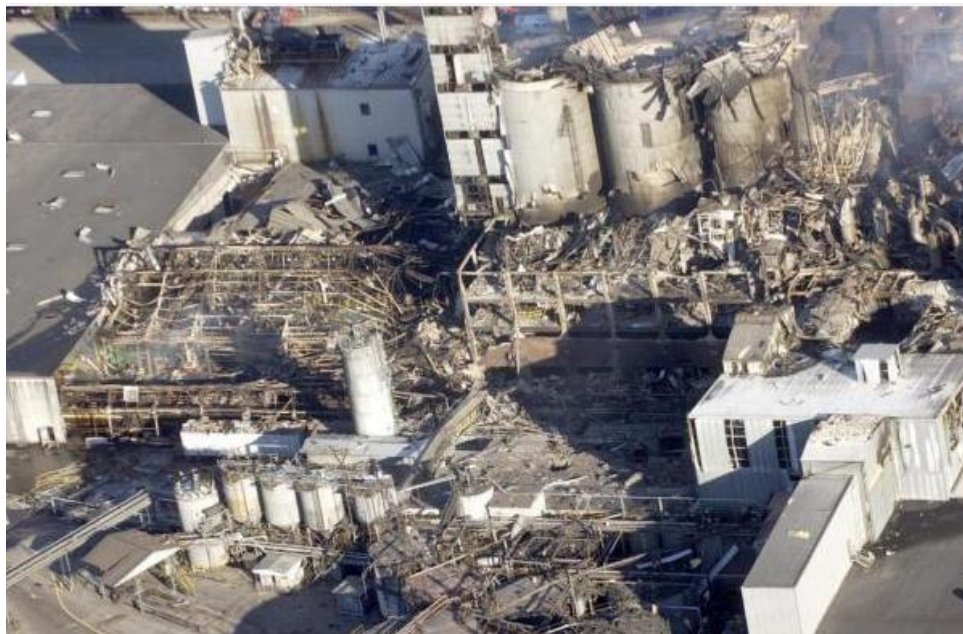
Figura 1 – Imagem aérea da Imperial Sugar Company depois da explosão e incêndio
