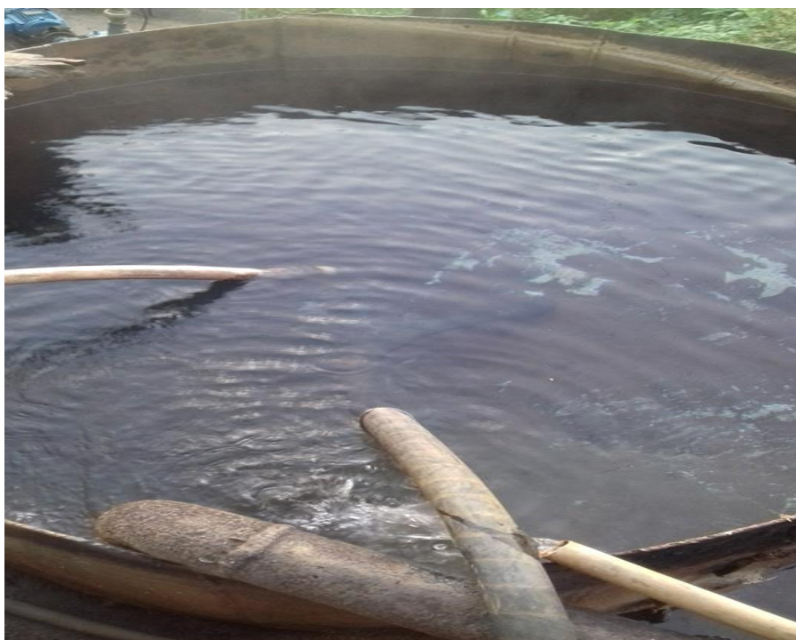
Figura 15 - Tanque de depósito do efluente utilizado no processo de resfriamento
