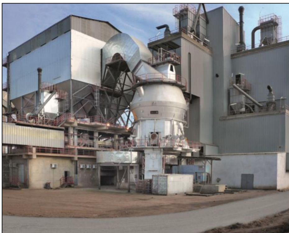
Figura 5 - Filtro de mangas instalado após a etapa de moagem da farinha
