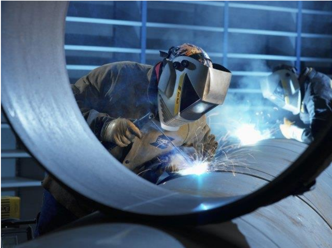
Figura 18 – Soldagem de um Tubo por Eletrodo Revestido
