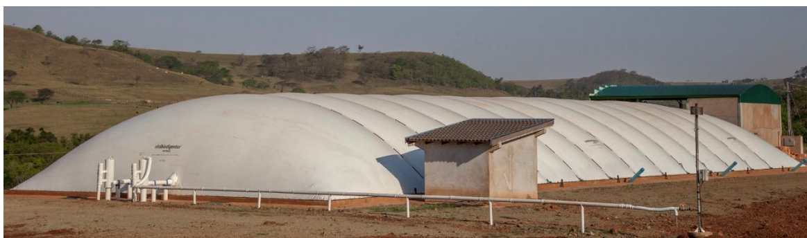
Figura 5 – Biodigestor canadense
