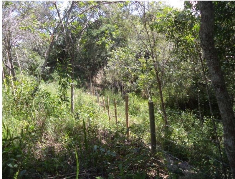
Figura 9 – Construção de cercas para isolamento e proteção.
