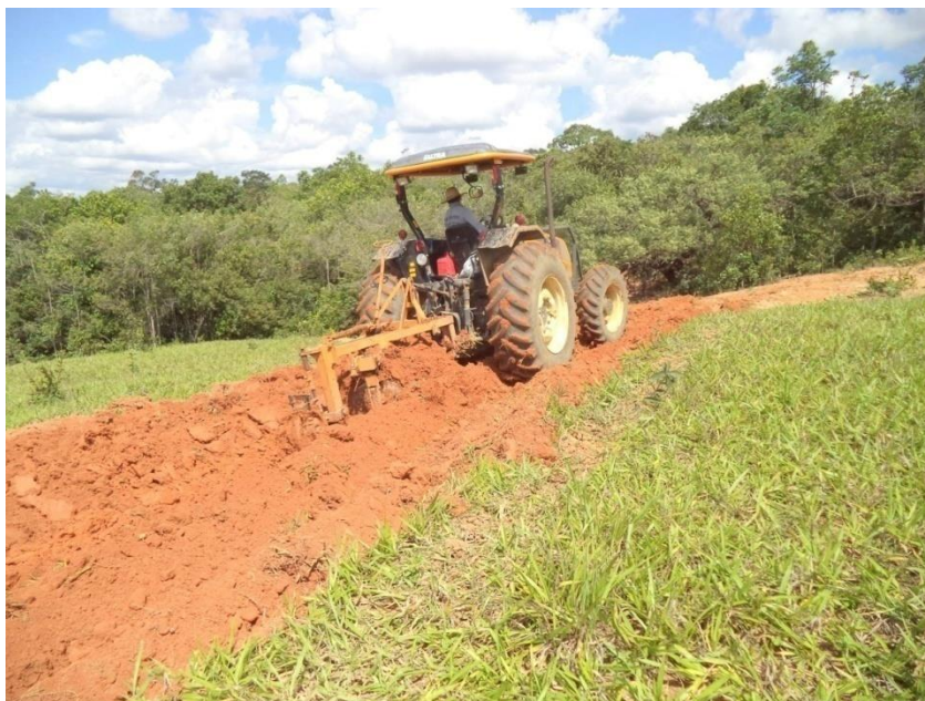
Figura 7 – Construção de terraços em nível.
