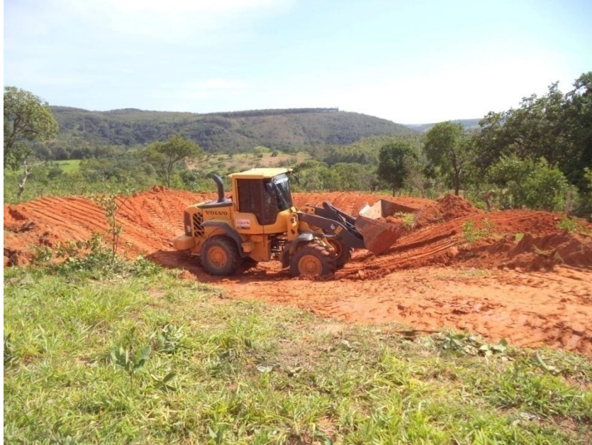
Figura 6 – Construção de barraginhas ou bacias de contenção.
