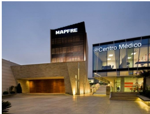
Figura 16- Vista exterior do complexo MAPFRE
