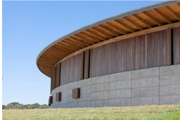
Figura 47 - Transição da alvenaria para madeira.
