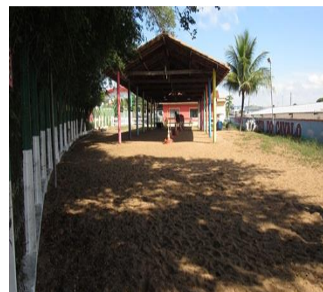
Figura 32 - Áreas aberta e coberta.
