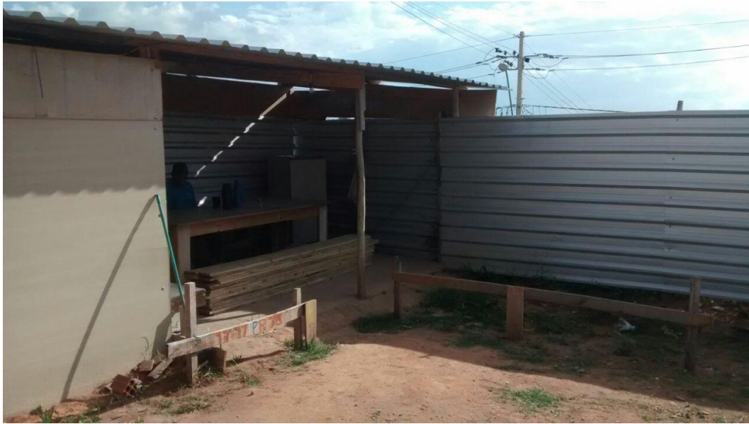
Figura 24 – Apoio e refeitório
