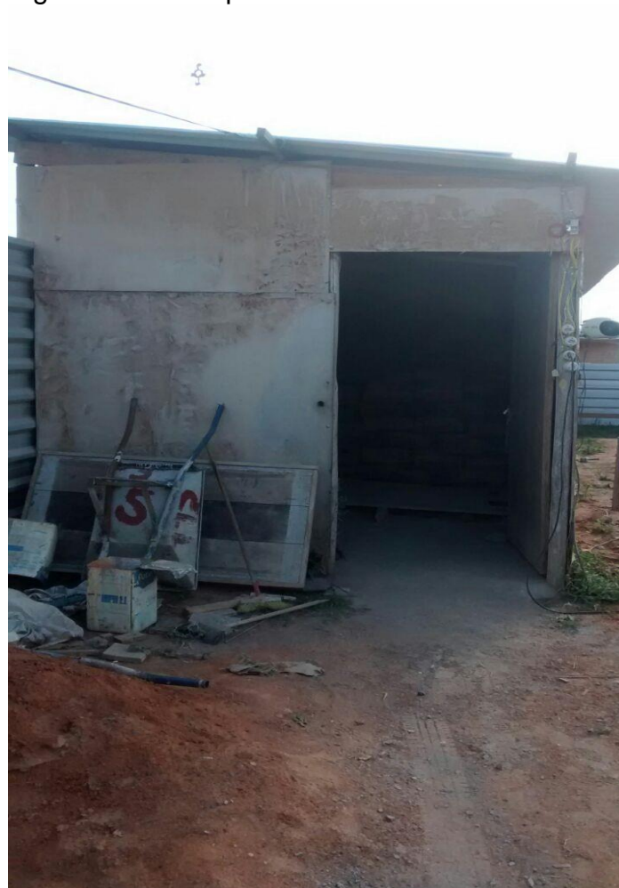
Figura 25 – Baia para armazenar cimento
