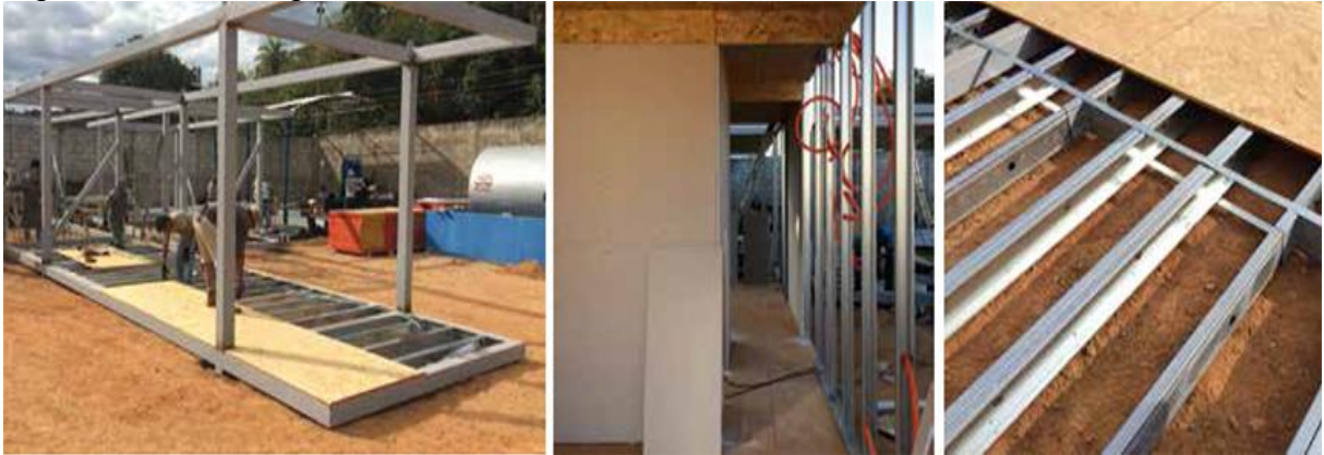
Figura 17 – Montagem da estrutura dos módulos
