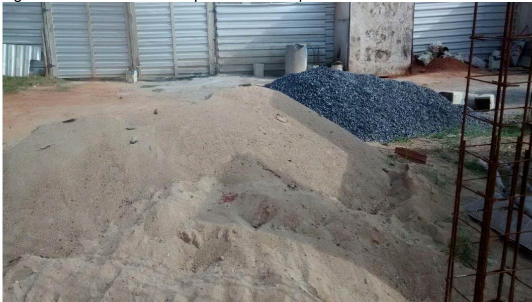
Figura 22 – Areia e brita expostas a intempéries
