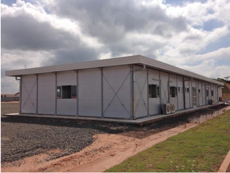
Figura 9 – Módulo para canteiro de obras
