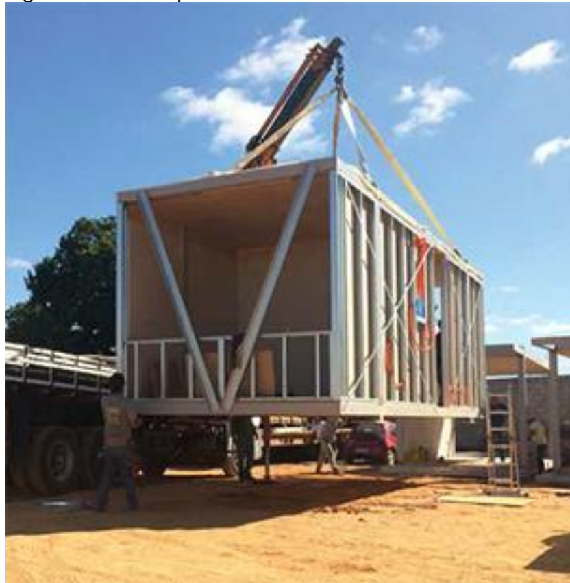
Figura 18 – Transporte dos módulos
