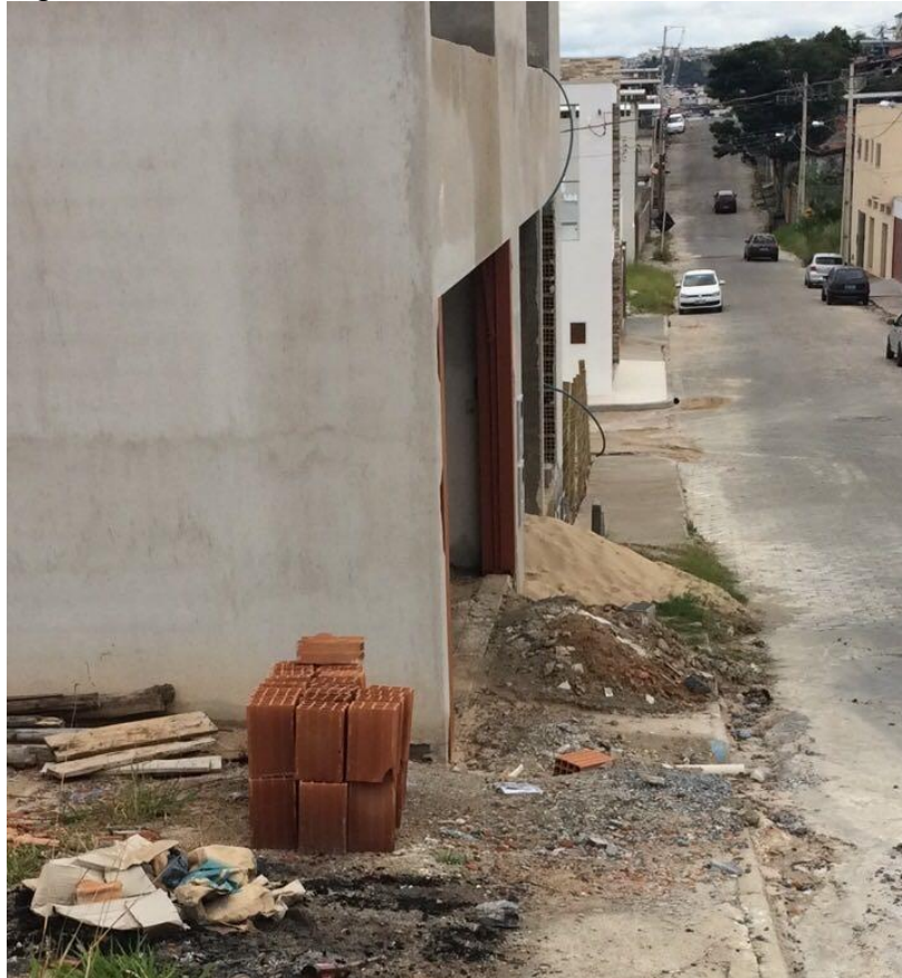
Figura 3 – Areia e britas não estocadas corretamente
