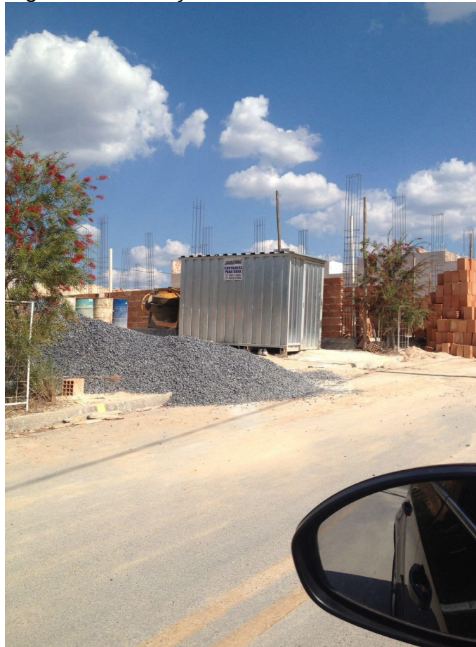
Figura 7 – Utilização de containers em obras
