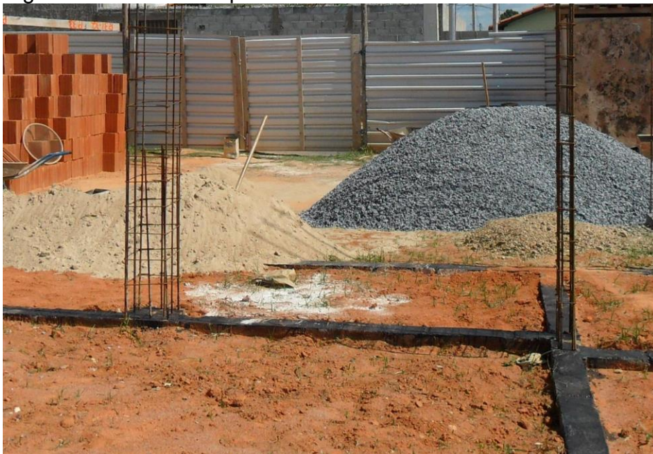
Figura 4 – Materiais expostos no terreno
