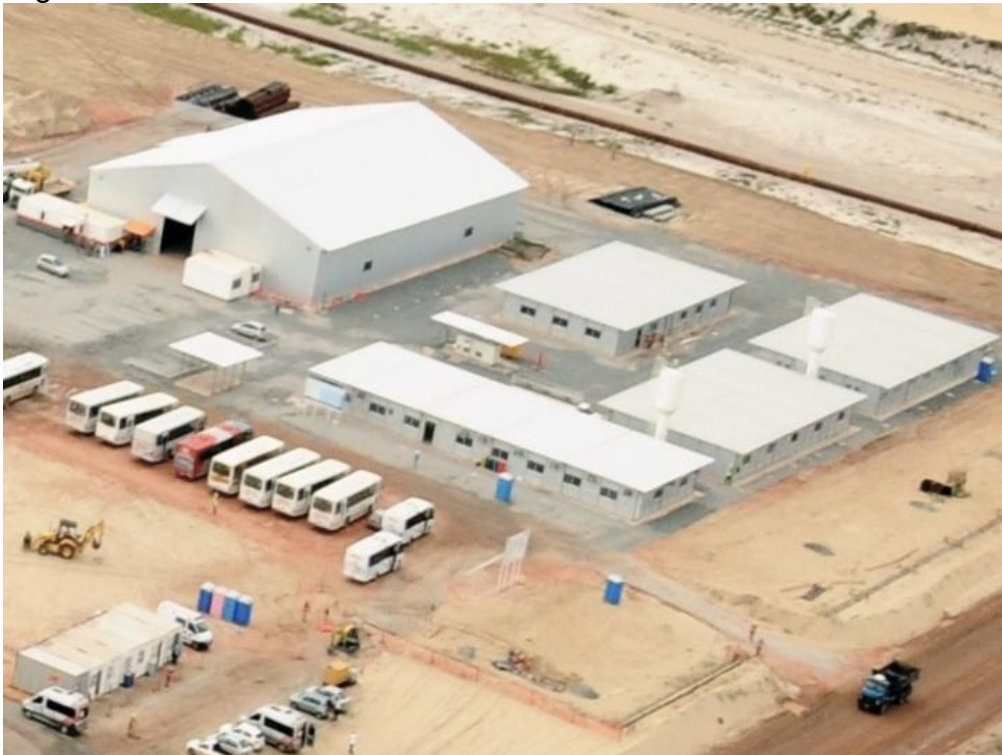
Figura 8 – Canteiro de obras modular
