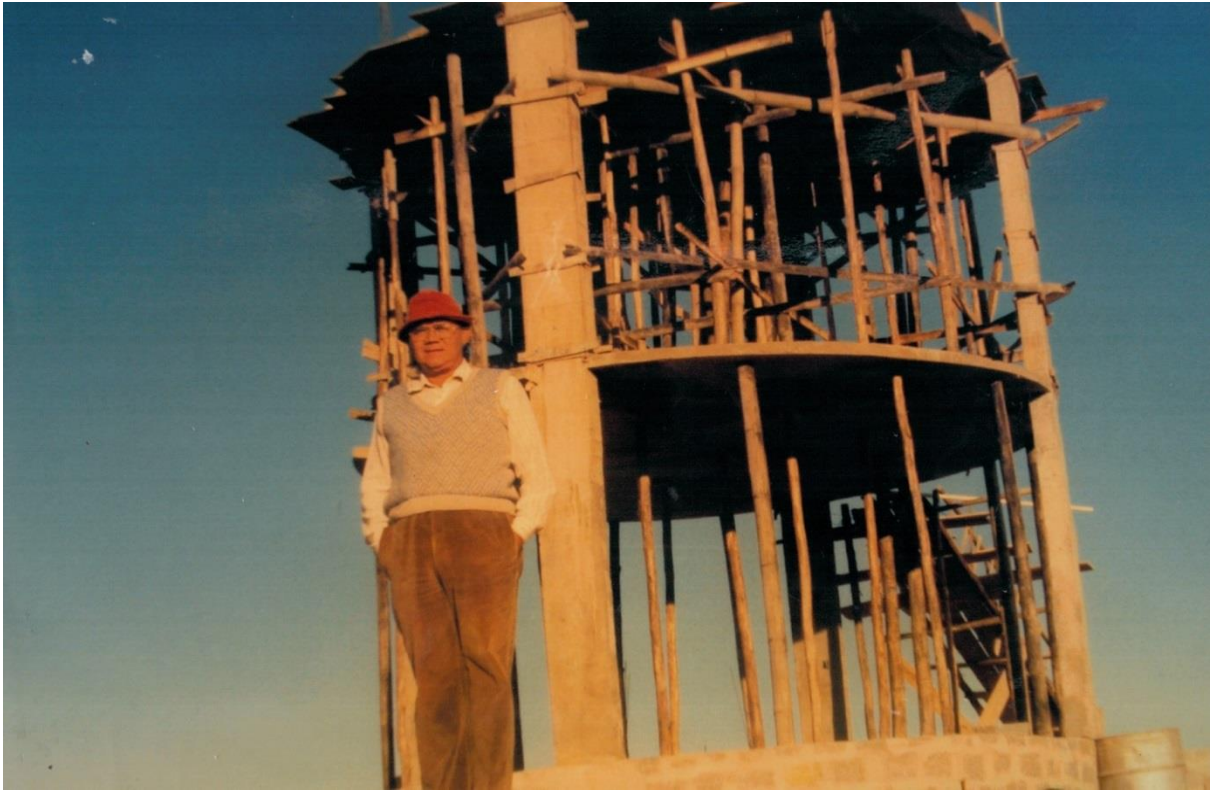
Figura 33 – Construção da Torre
