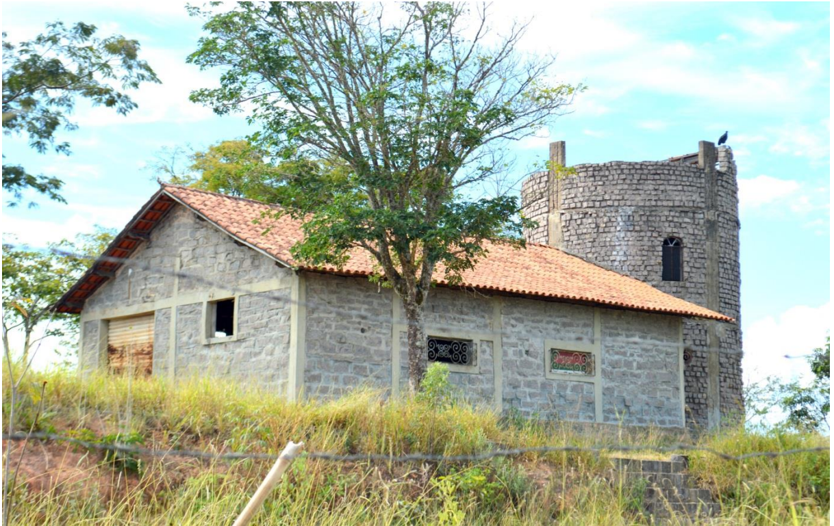
Figura 03 – Estado atual do Castelinho
