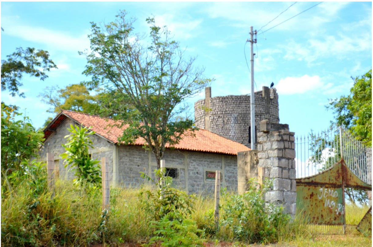
Figura 02 – Estado atual do Castelinho
