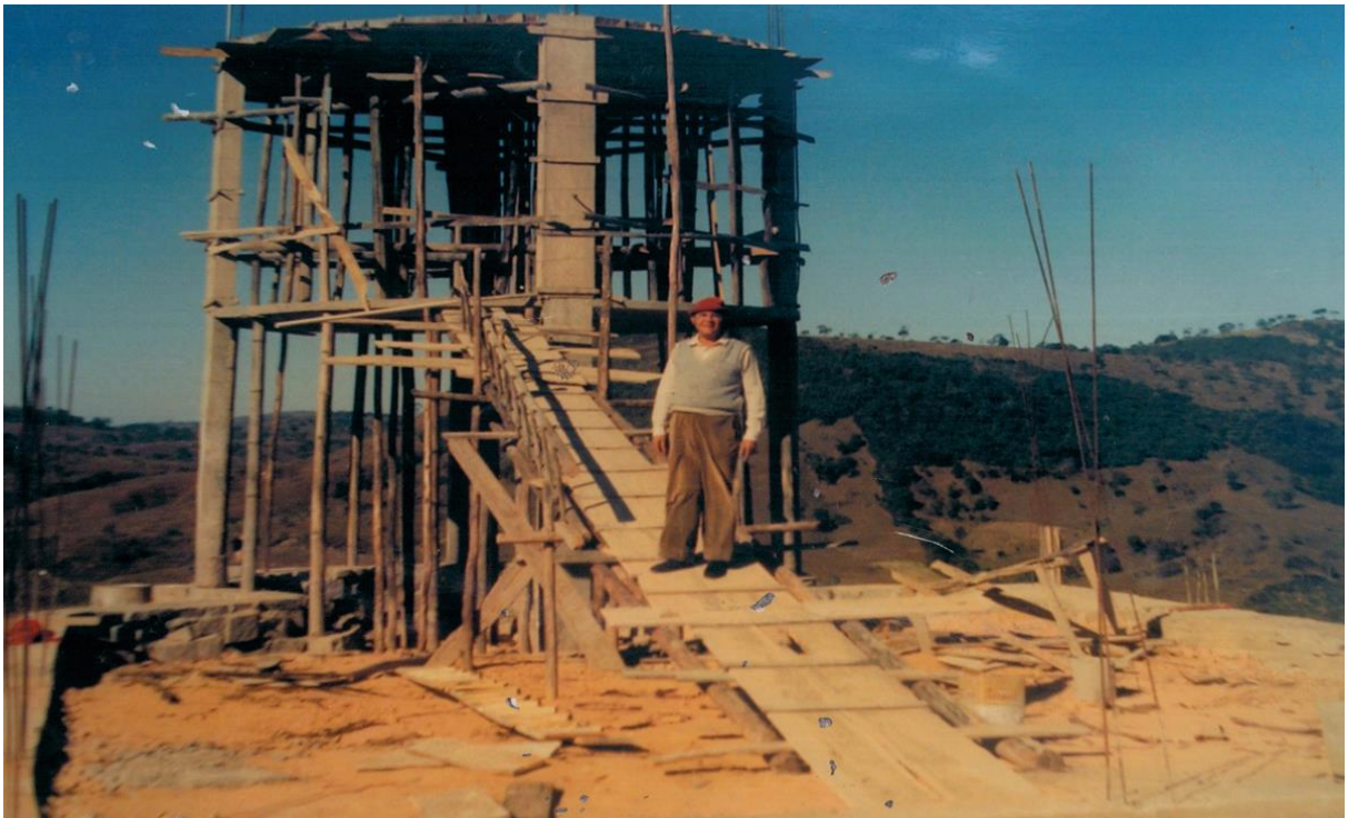
Figura 32 – Construção da Torre
