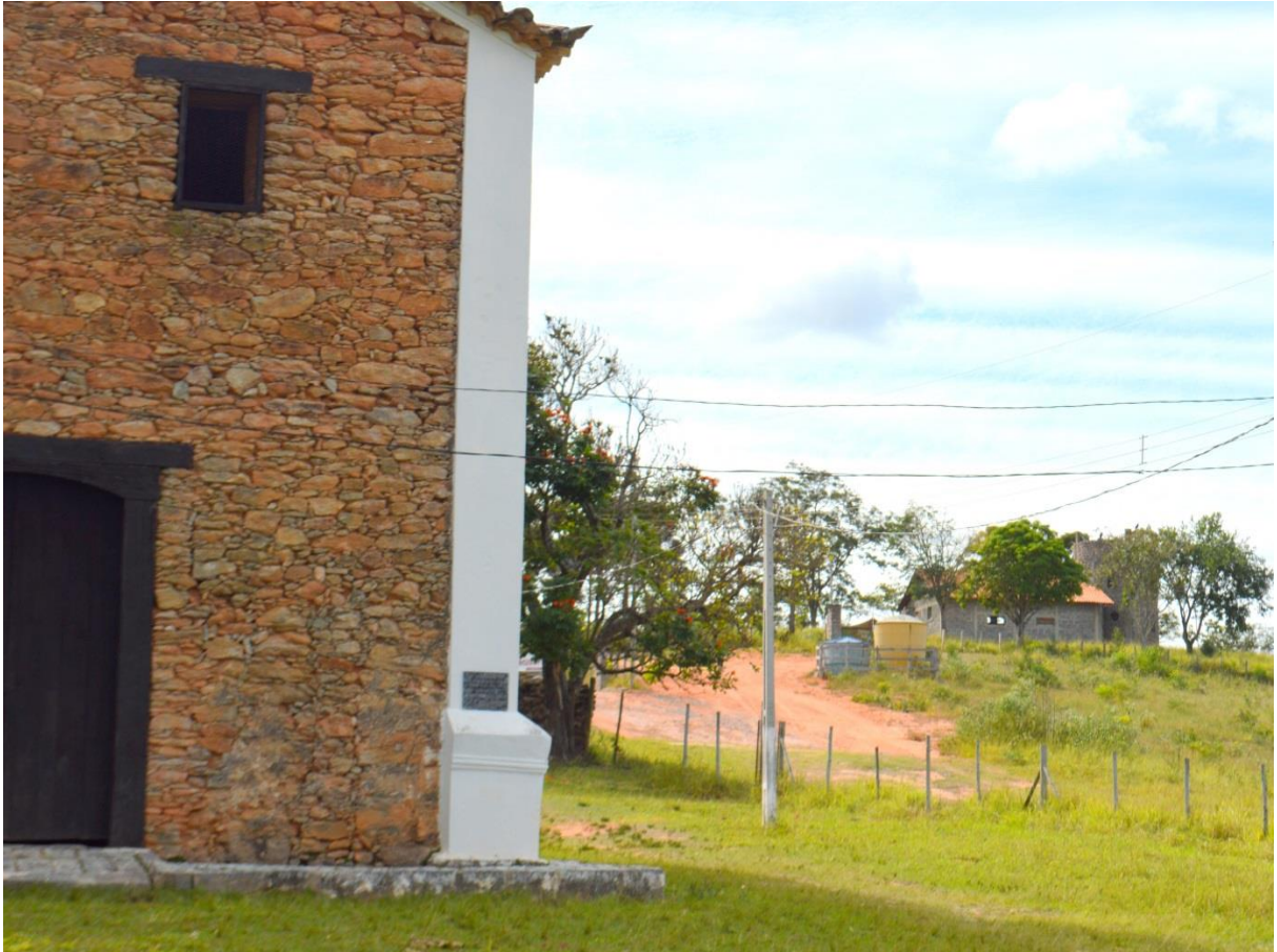
Figura 58 – Vista da Igrejinha e do Castelinho em 2017
