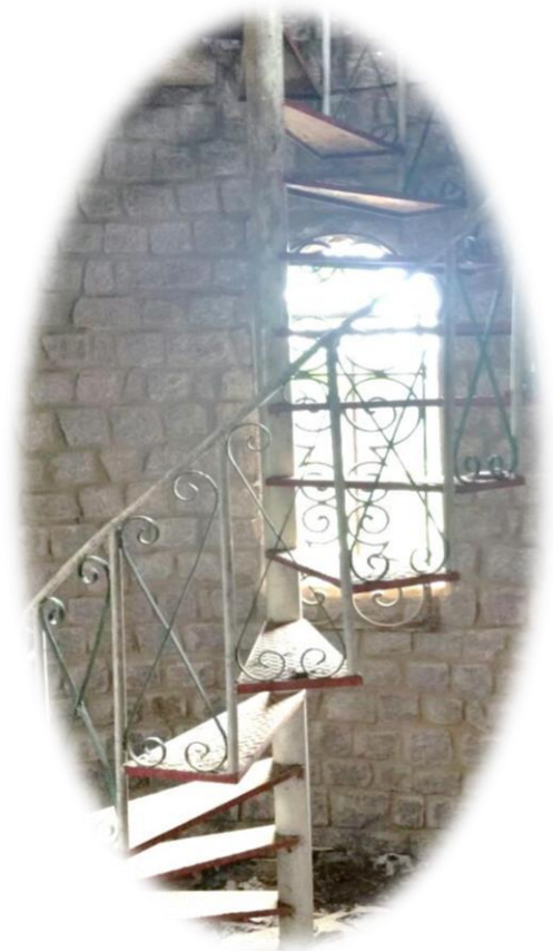
Figura 53 – Escada da Torre
