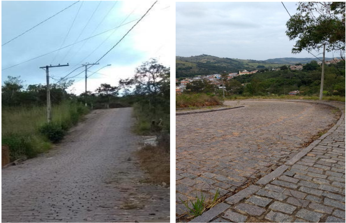
Figura 37 – Via de Acesso Principal Rua Paraná
