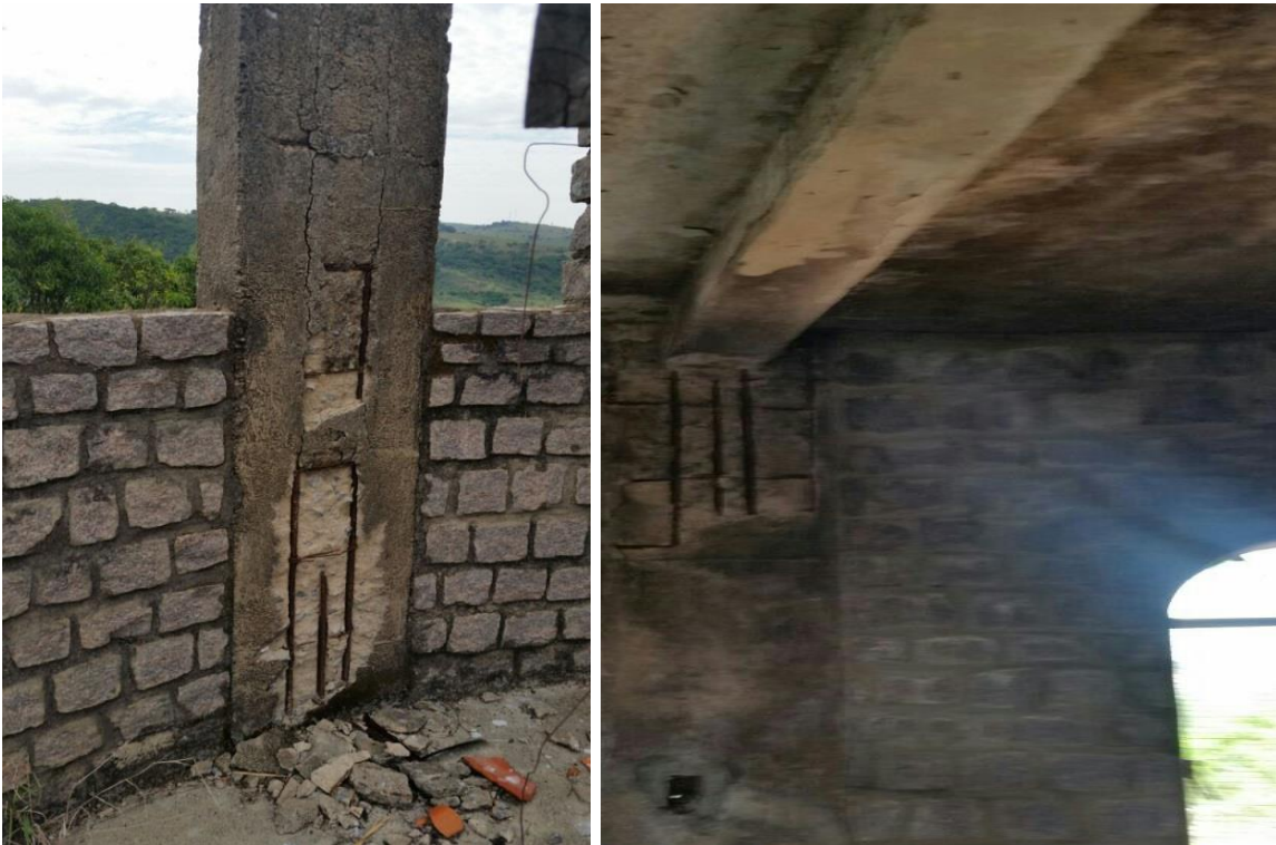
Figura 04 – Estrutura da torre
