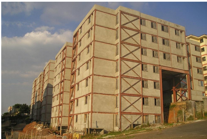
Figura 20 - Processo de Construção Paulo Freire
