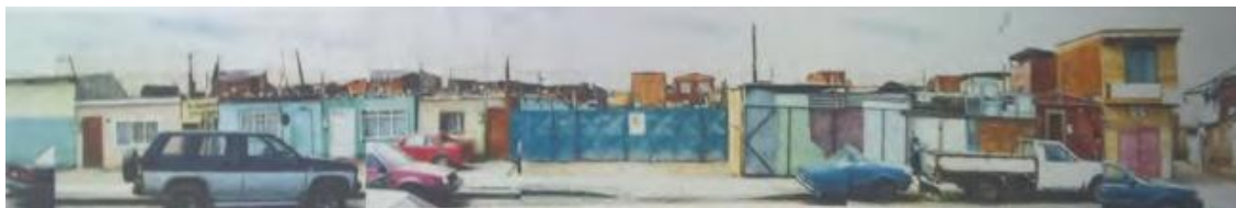
Figura 6 - Situação da ocupação irregular, antes da atuação do Elemental.
