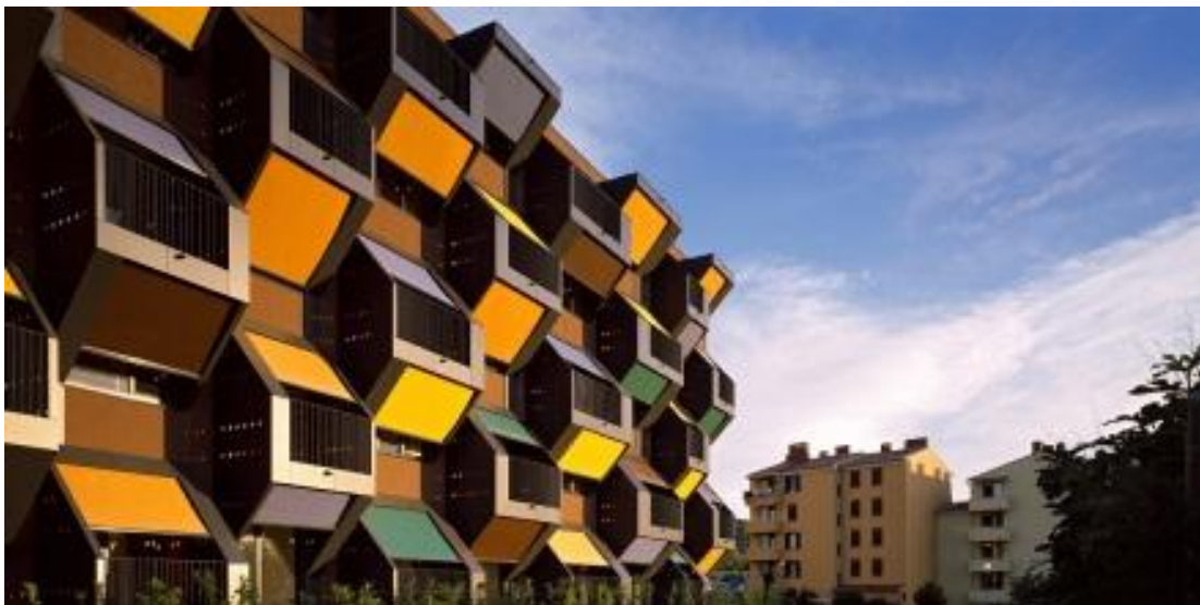
Figura 31 - Fachada frontal, podendo observar os furos laterais.
