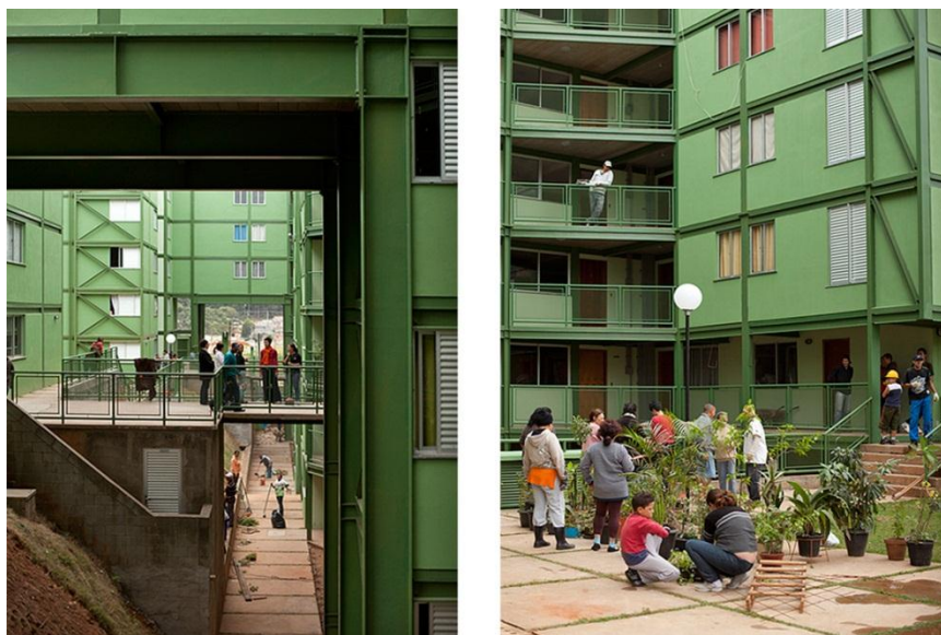
Figura 21 - Imagem área central das habitações.
