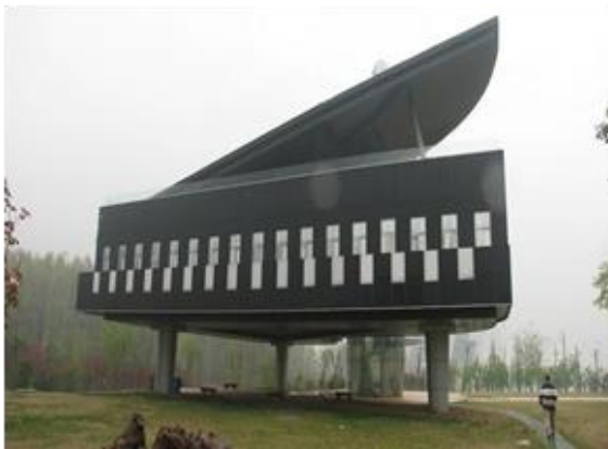
Figura 14 - Corpo central da edificação
