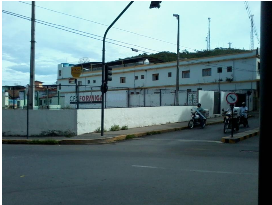
Figura 56 – Vista da Rua Carlos Chagas
