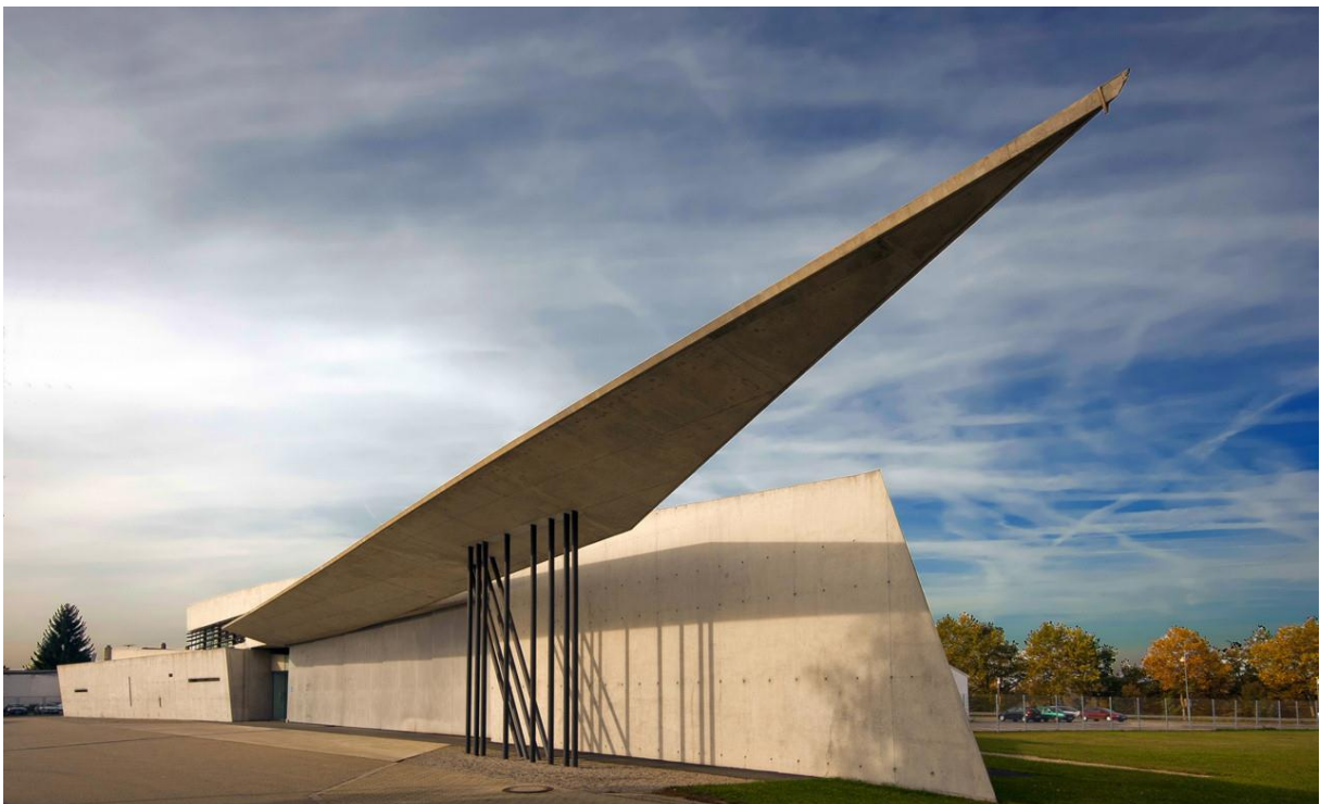
Figura 18 – Estação do Corpo de Bombeiros de Vitra.
