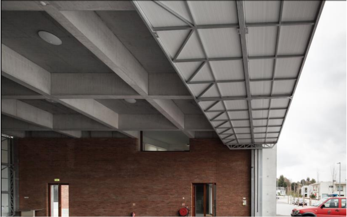
Figura 11 – Interior da garagem do Quartel.
