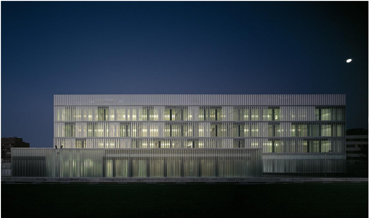
Figura 17 – Fachada frontal à noite, com a maioria dos painéis abertos.
