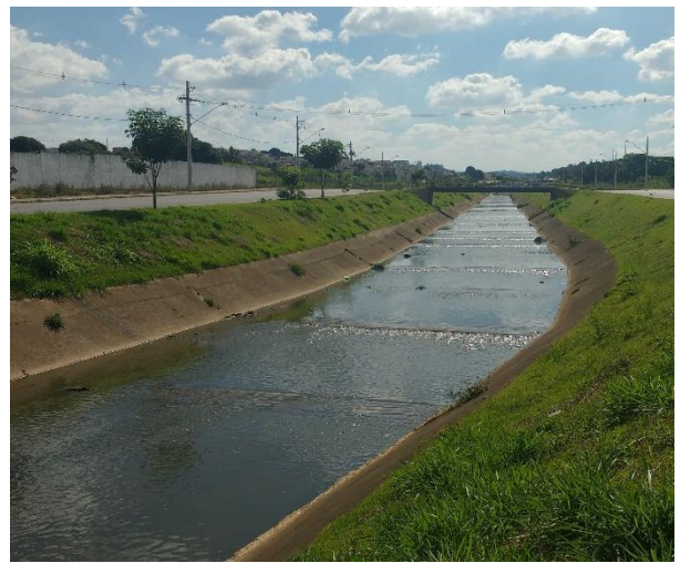
Figura 38 – Canalização na parte nova.
