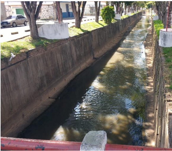
Figura 37 – Canalização na parte Central.
