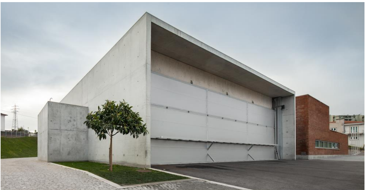
Figura 10 – Vista entrada da garagem do Quartel.
