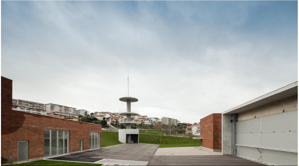
Figura 9 – Oficina, Parada Operacional e Casa Escola.
