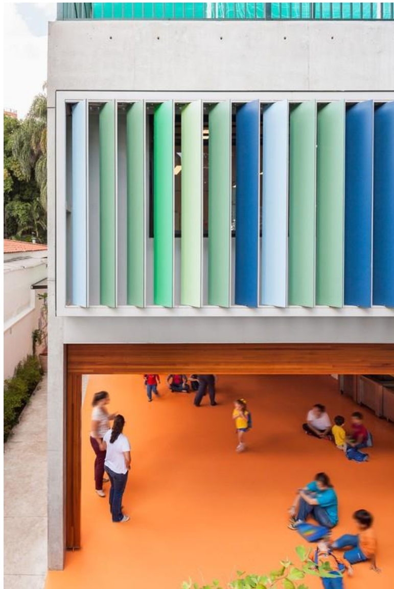
Figura 39 – Vedação de material pré-fabricado.
