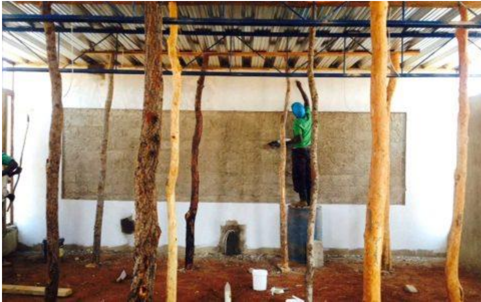
Figura 2 – Participação de um morador na construção da escola infantil.
