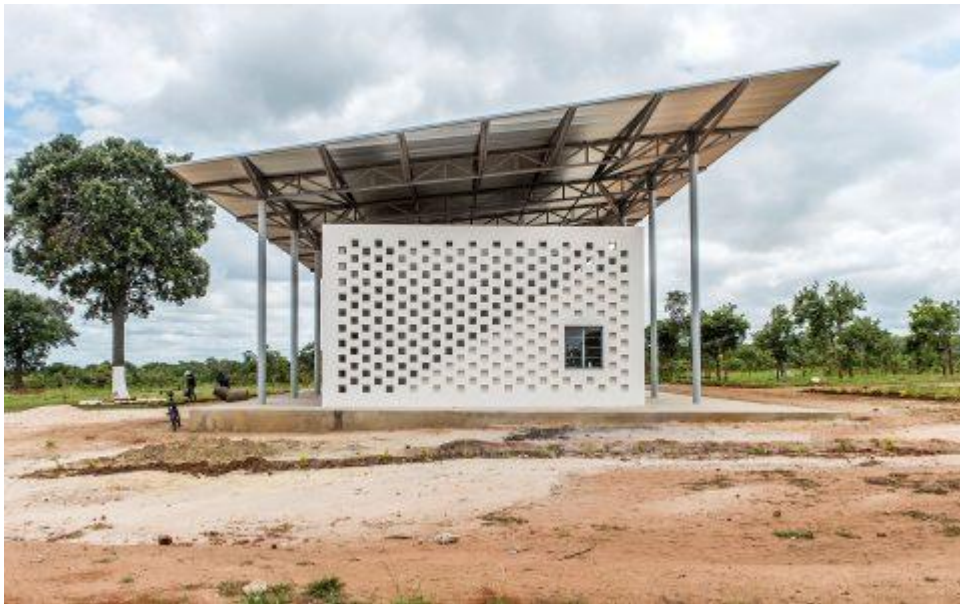
Figura 9 – Vedação que permite o aproveitamento da luz solar.
