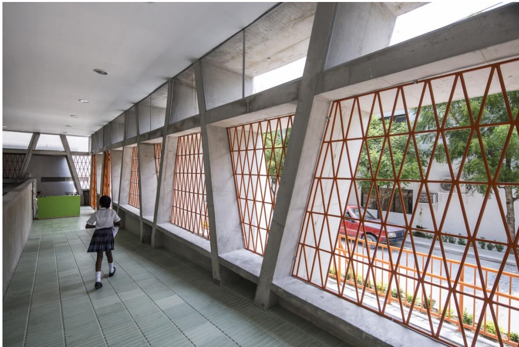
Figura 16 – Telas metálicas para controle bioclimático do edifício.
