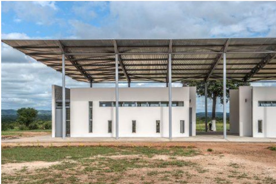
Figura 7 – Elevação da cobertura metálica em relação à laje de alvenaria.
