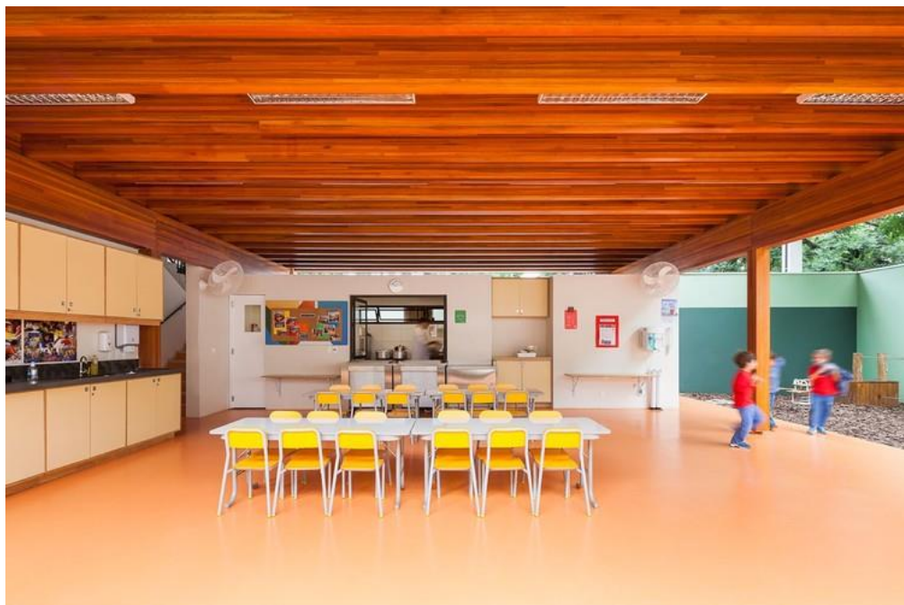
Figura 34 – Revestimento de madeira no interior da escola.
