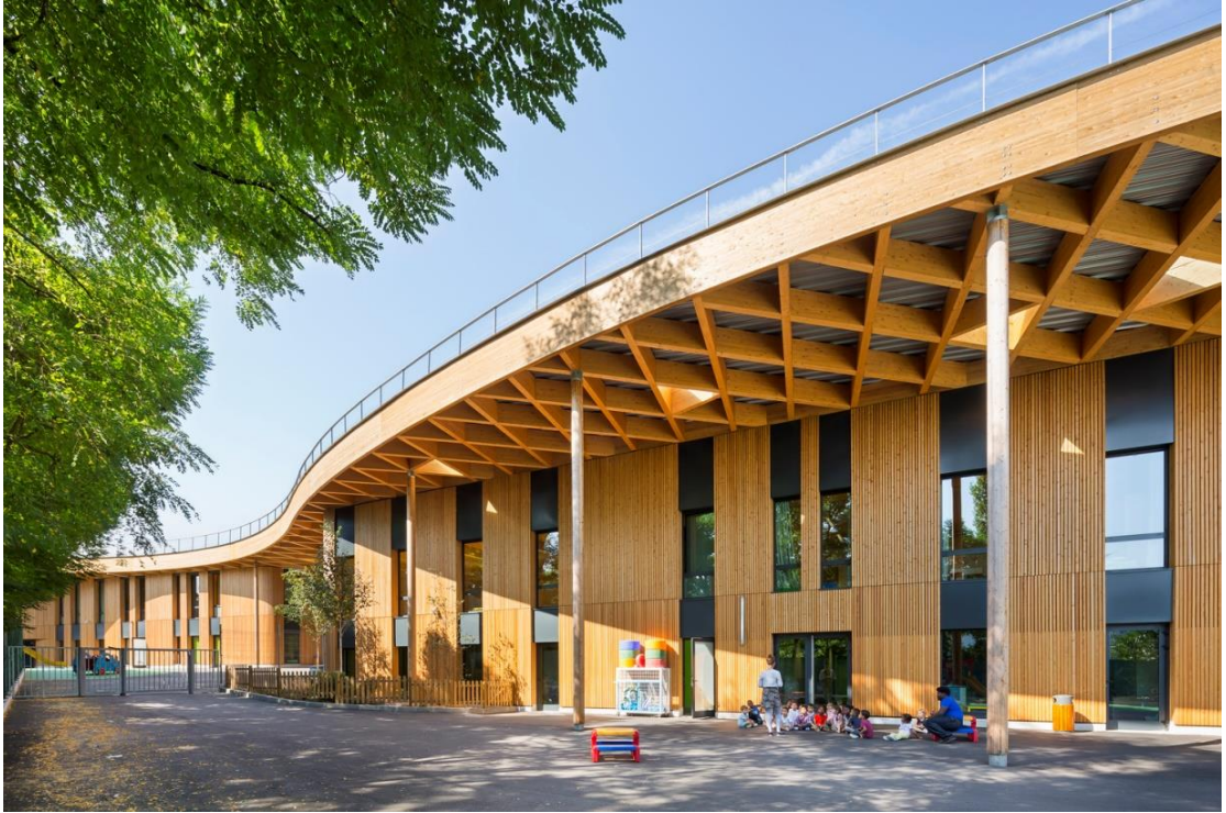
Figura 26 – Peças de madeira pré-fabricadas.
