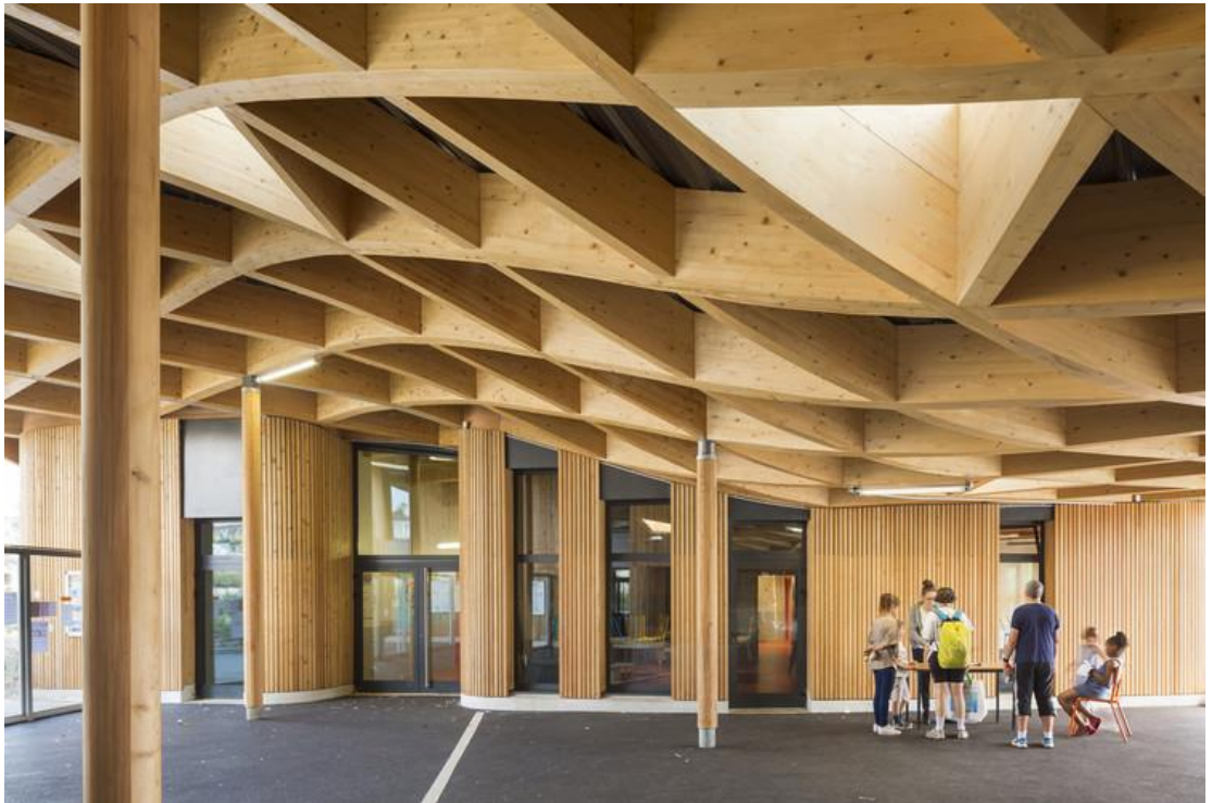
Figura 27 – Peças de madeira pré-fabricadas.
