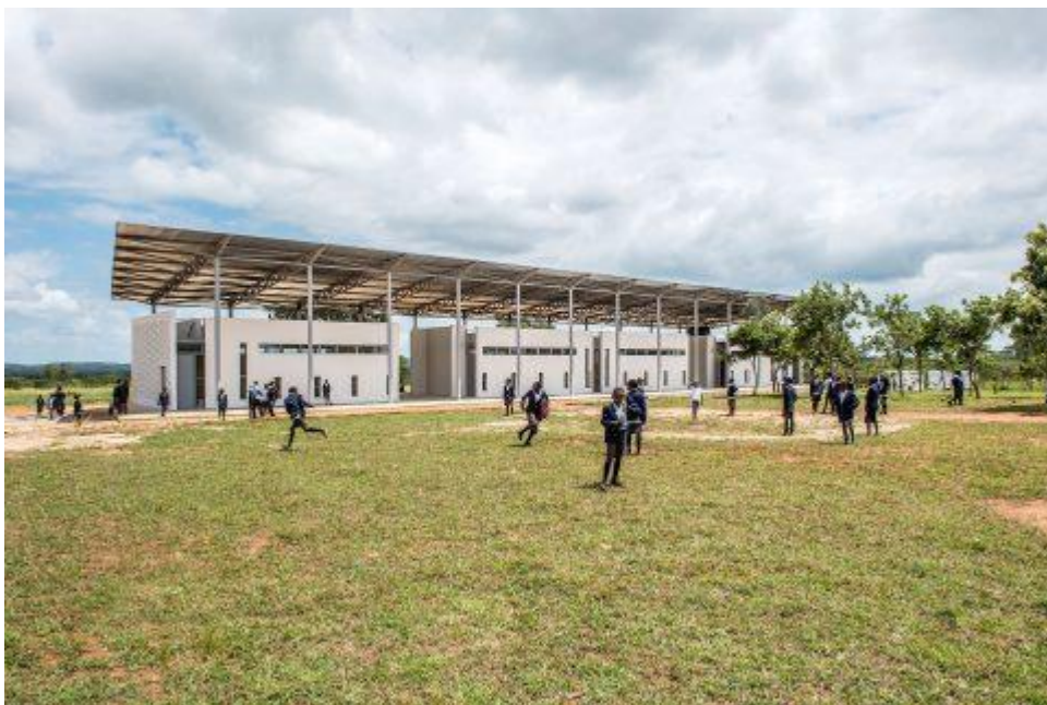
Figura 10 – Janelas contínuas de clerestory.
