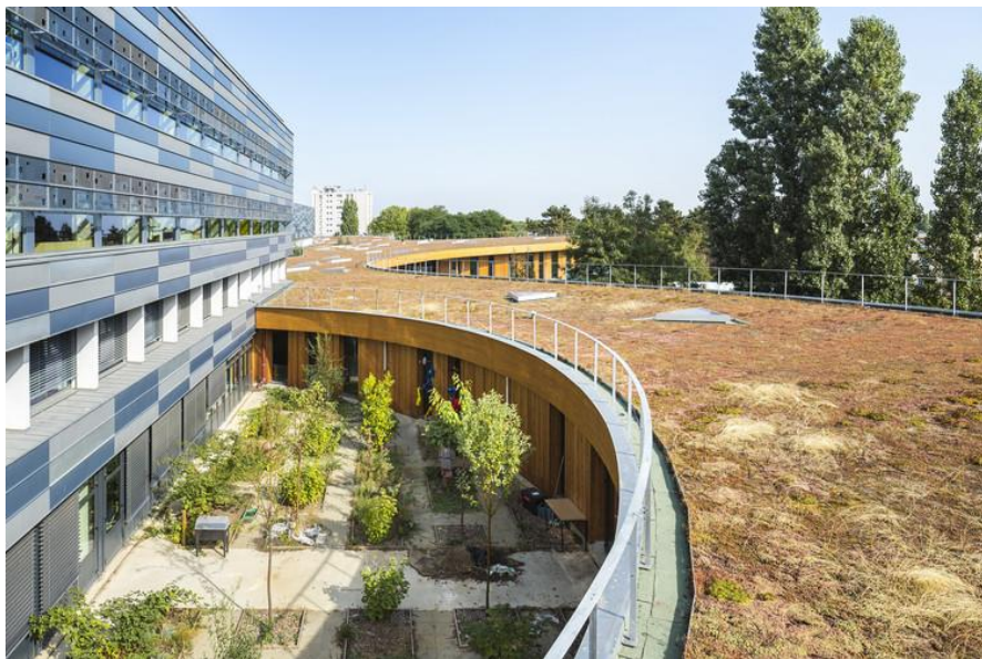
Figura 24 – Telhado verde atuando como ligação dos blocos.
