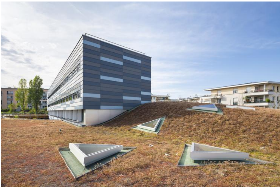
Figura 25 – Telhado verde atuando como ligação dos blocos.
