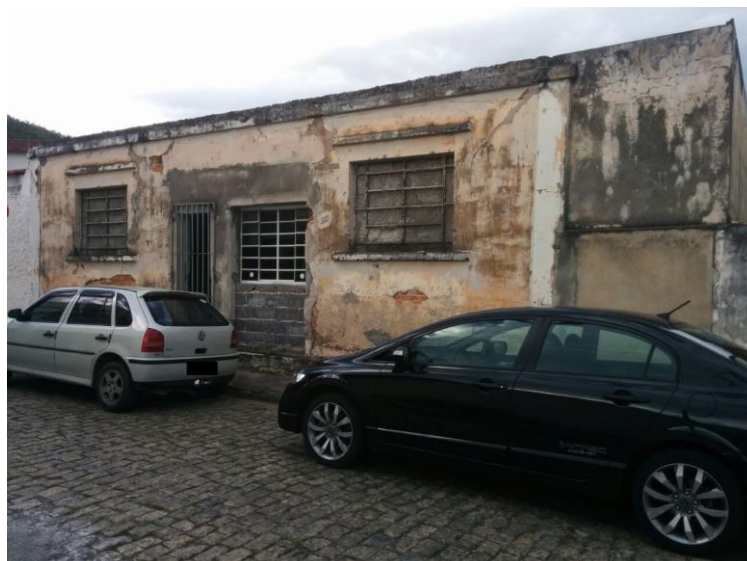
Figura 51 – Edificação abandonada na Rua Álvaro Alvin.
