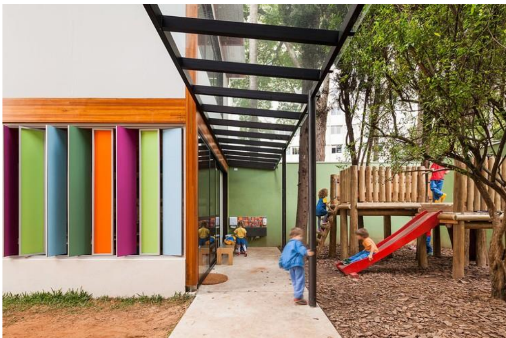
Figura 36 – Vedação de material pré-fabricado.
