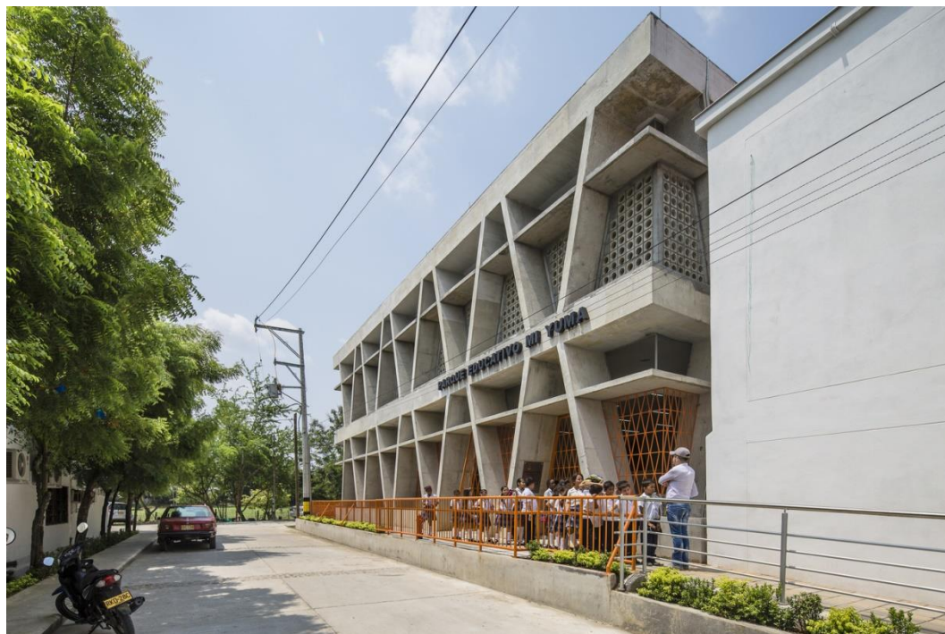
Figura 17 – Telas metálicas e paredes furadas para controle bioclimático do edifício.
