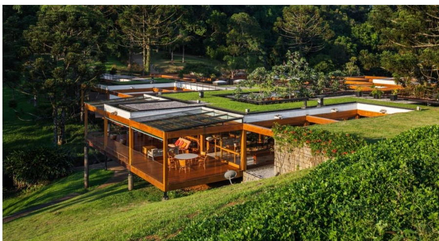
Figura 42 - Perspectiva da Grid House
