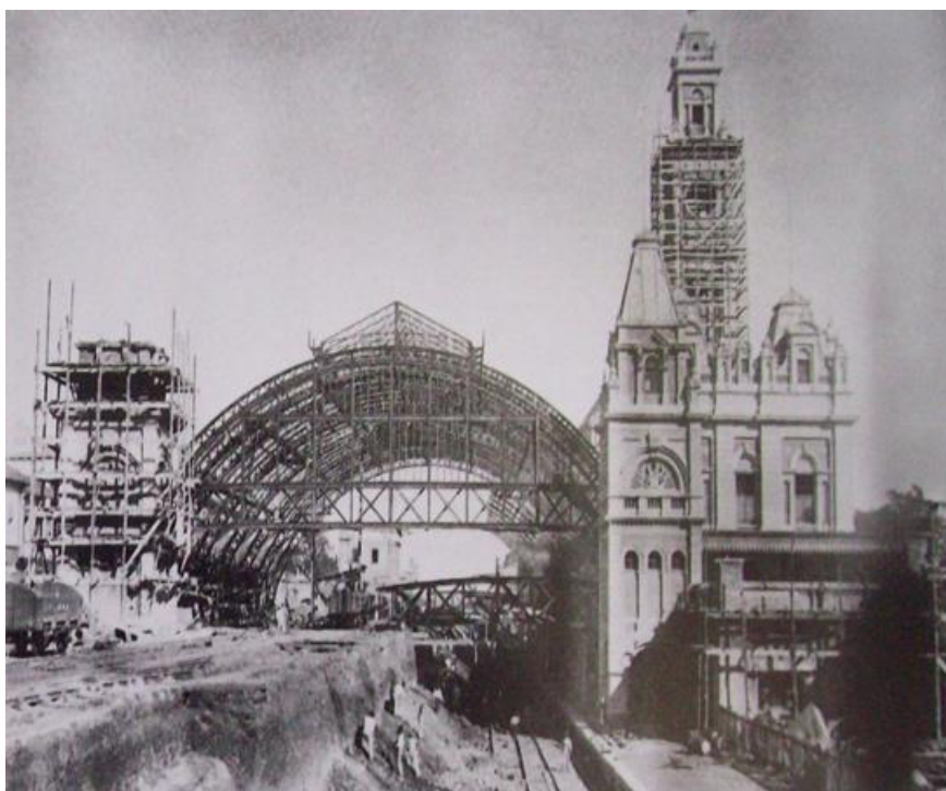
Figura 5 - Ferroviária da Luz em São Paulo/SP Início da nova Estação Ferroviária da Luz em São Paulo
