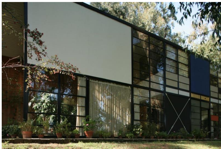
Figura 6 - Casa Eames fachada
