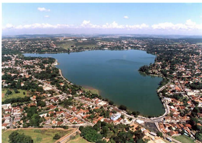
Figura 51 - Imagem aérea da cidade de Lagoa da Prata MG
