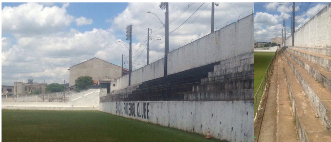
Figura 40 - Foto Interior do Terreno - Arquibancada
