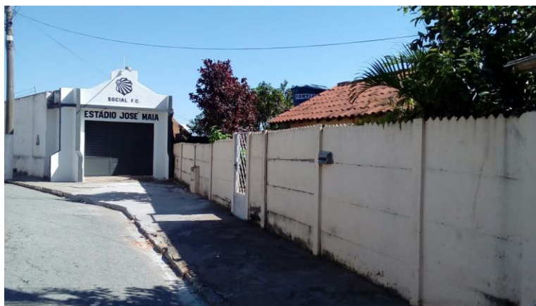
Figura 29 – Bilheteria Rua José Maia
