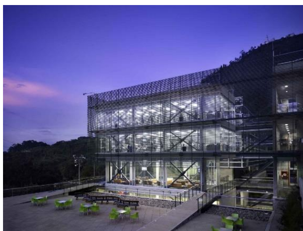
Figura 5 - Fachada e Pátio de Convivência
