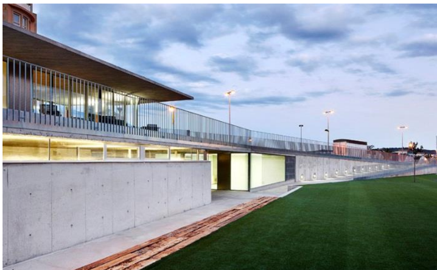
Figura 9 - Rampa de Acesso aos Campos Esportivos
