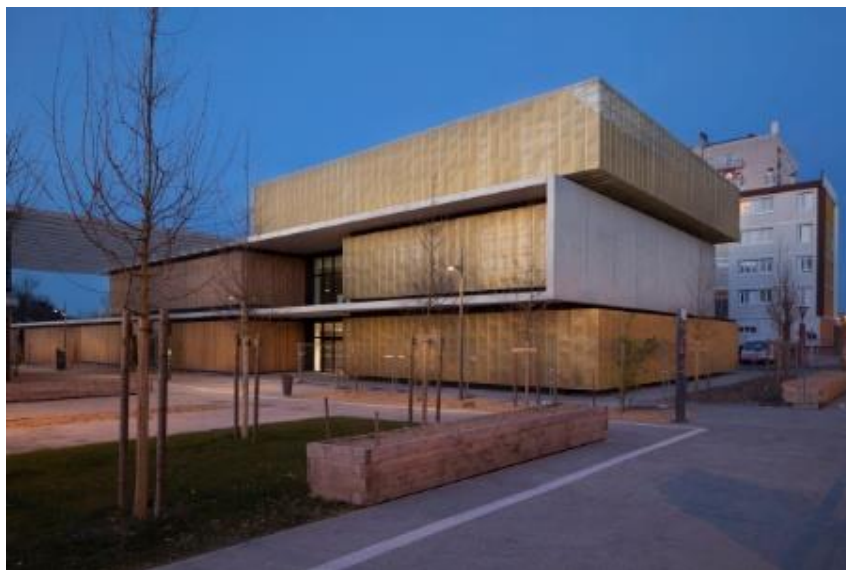
Figura 15 - Fachada Edificação Principal
