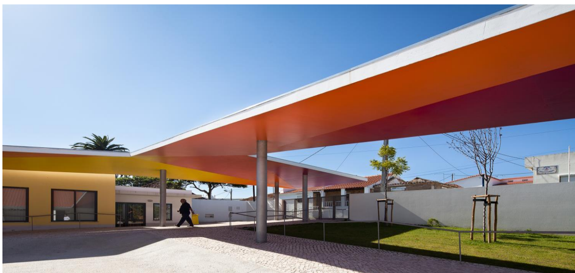
Figura 25 - Cobertura da escola em Romaria.
