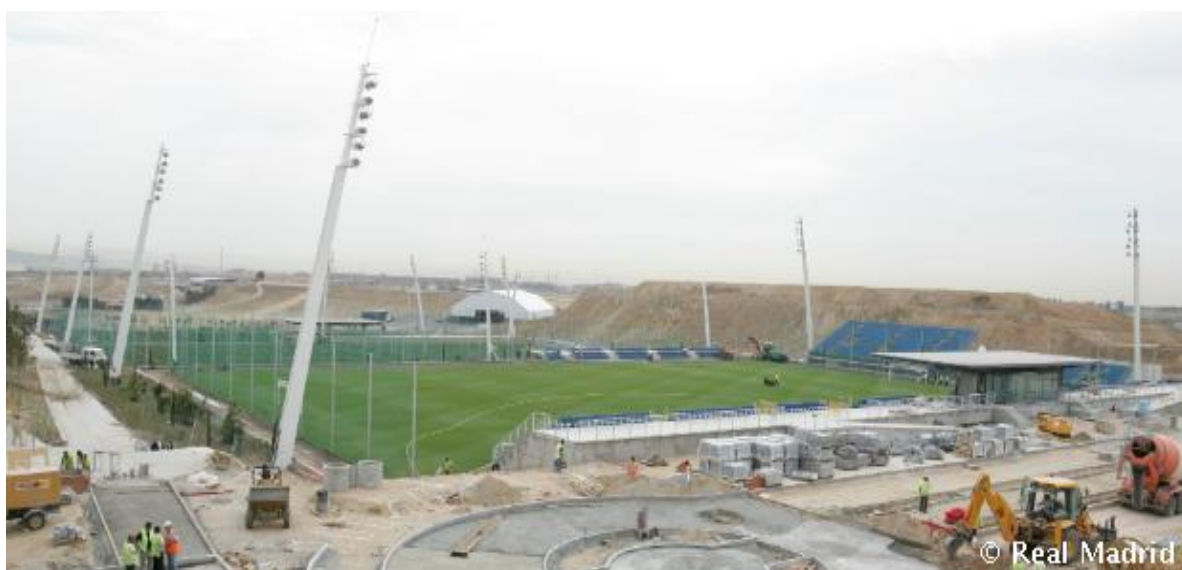
Figura 12 - Fase de construç o do CT do Real Madrid.
