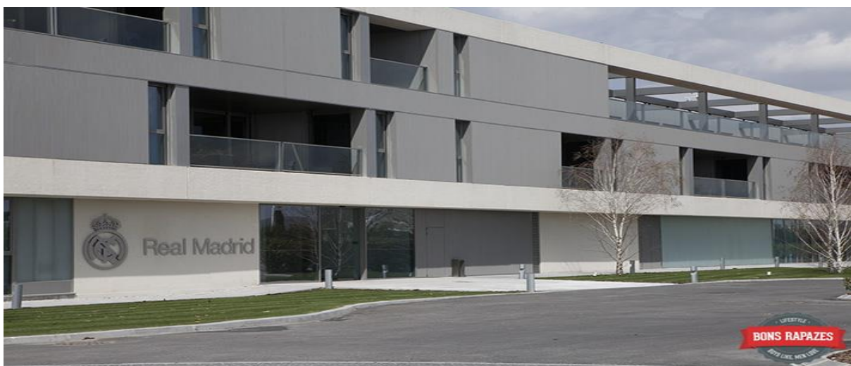
Figura 14 - Edifício principal do centro de treinamento.
