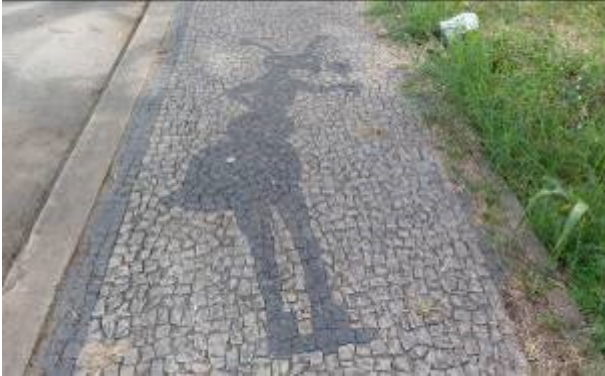
Figura 12 – Calçada em pedra portuguesa
