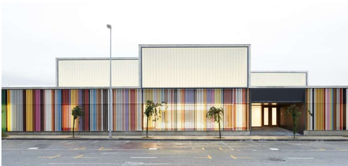
Figura 4 - Fachada escola de Berriozar
