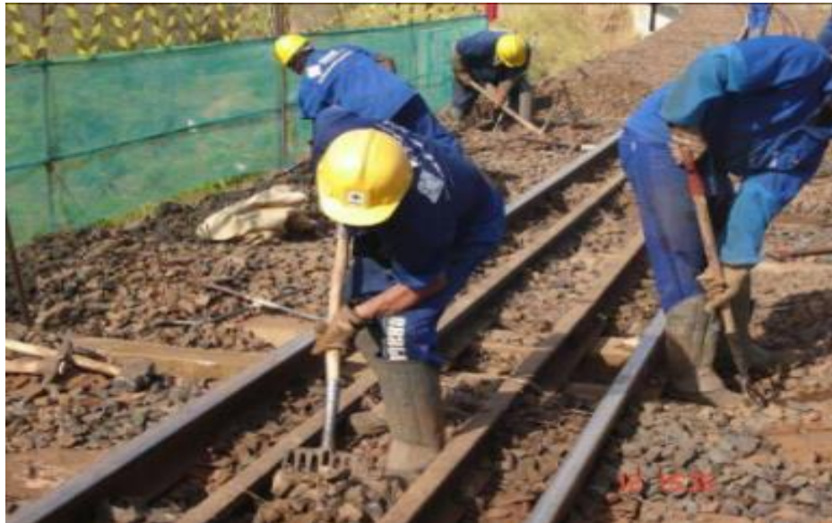
Figura 20 - Limpeza de lastro manual
