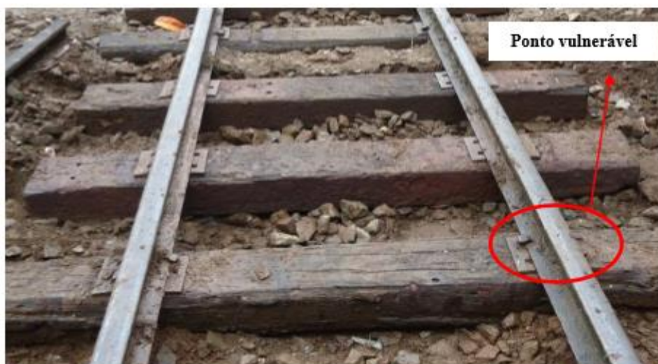
Figura 5 - Linha ferroviária com a utilização do dormente de madeira
