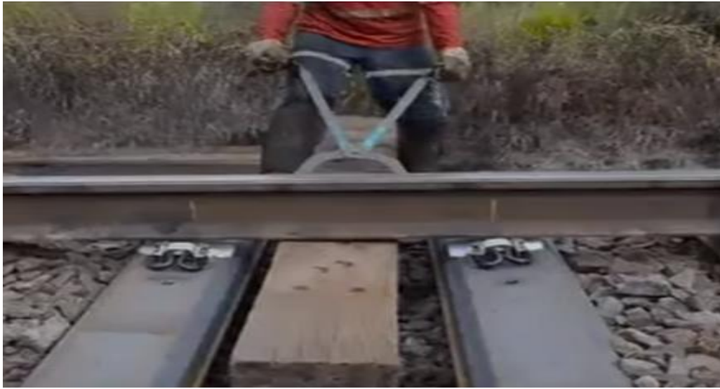
Figura 21 - Extração manual do dormente
