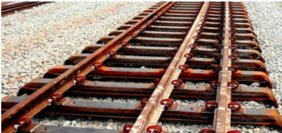
Figura 8 - Linha ferroviária utilizando do dormente de aço
