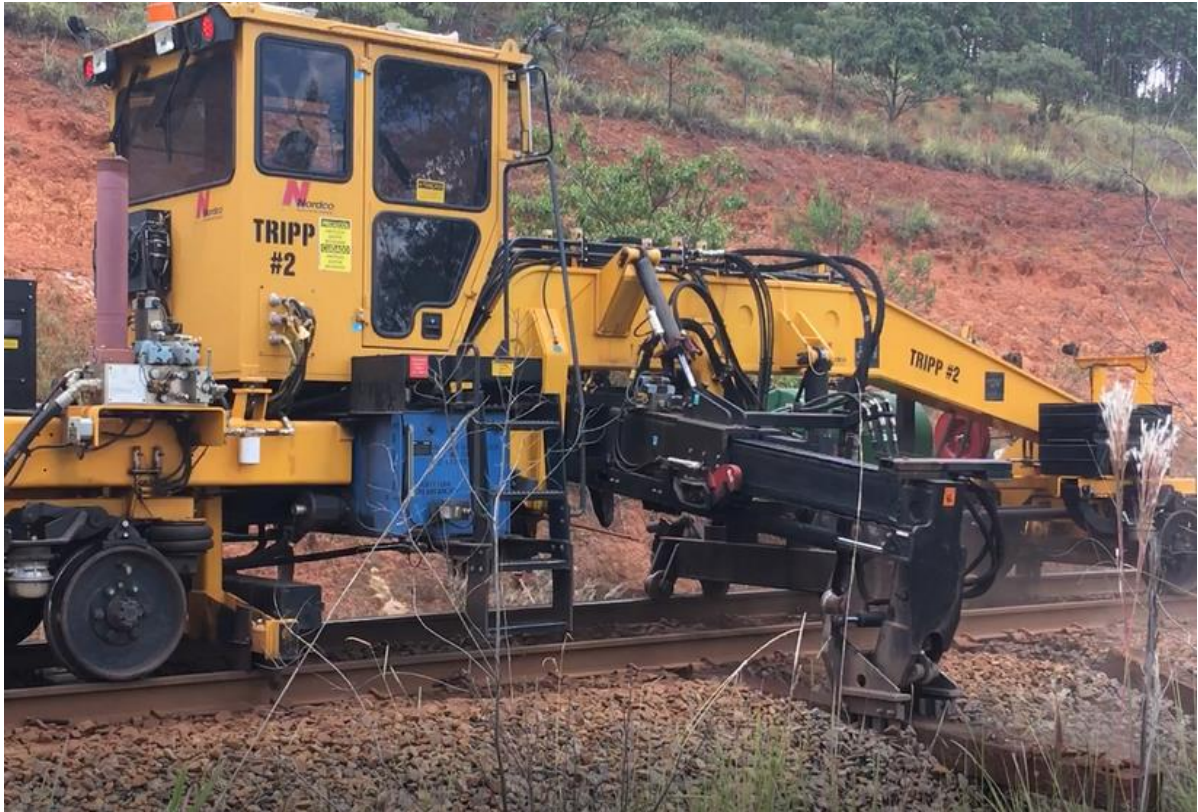
Figura 22 - Extração mecanizada do dormente
