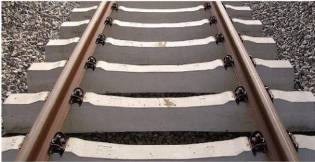
Figura 9 - Linha ferroviária utilizando dormente de concreto protendido
